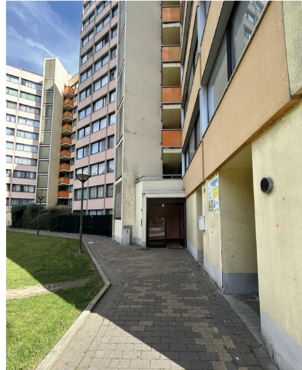
Figure 15: Entrée dans les espaces communs de la tour, Photographie: Auteure
