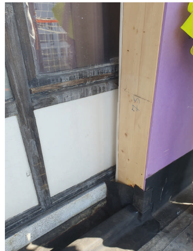
Mise à distance de 30 cm de la dalle destinée à recevoir le nouveau châssis double vitrage, et permettant le passage de la nouvelle tuyauterie des radiateurs.
