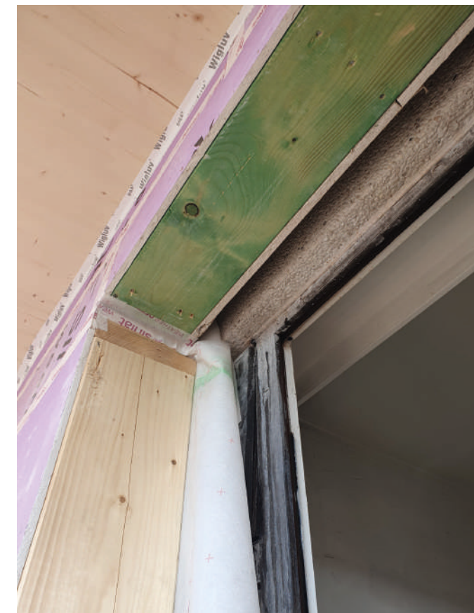
Murs en ossature bois préfabriqués, positionnés à 5 cm de la façade existante afin d'anticiper les mouvements du bois dans le temps, notamment son gonflement.
