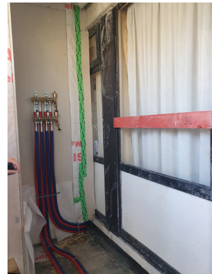
Mise en place d'une nouvelle trémie à l'intérieur du mur en ossature bois dans chaque extension, ensuite recouverte par une plaque d'OSB.
