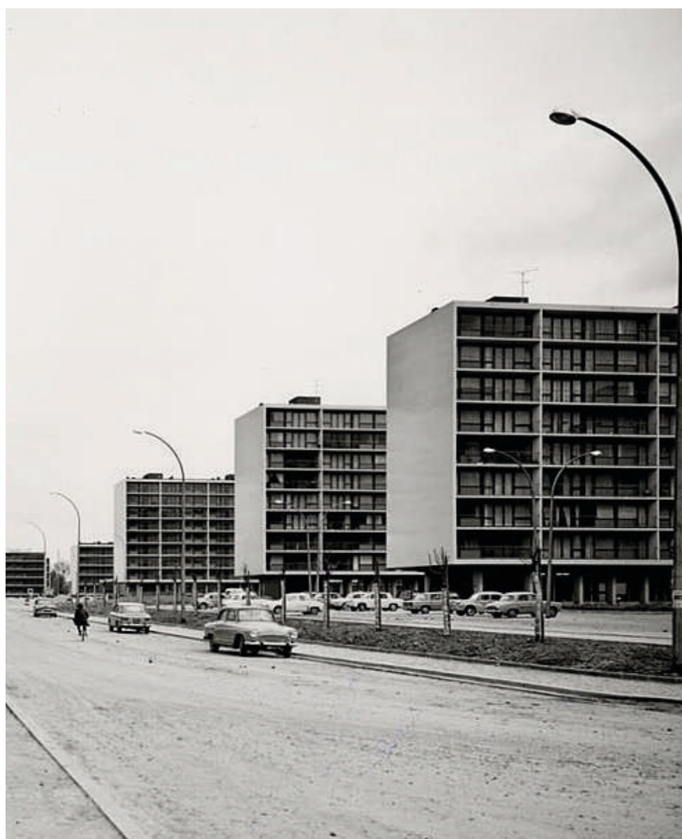
Figure 1: Les logements sociaux dans les années 1960-1970, Photographie: Wikimedia Commons
