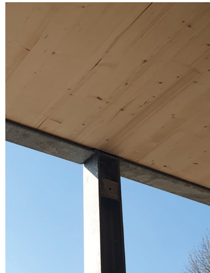
Jonction des poutres secondaires aux poteaux en acier réalisée à l'aide de plaques en acier et de fixations par vis.
