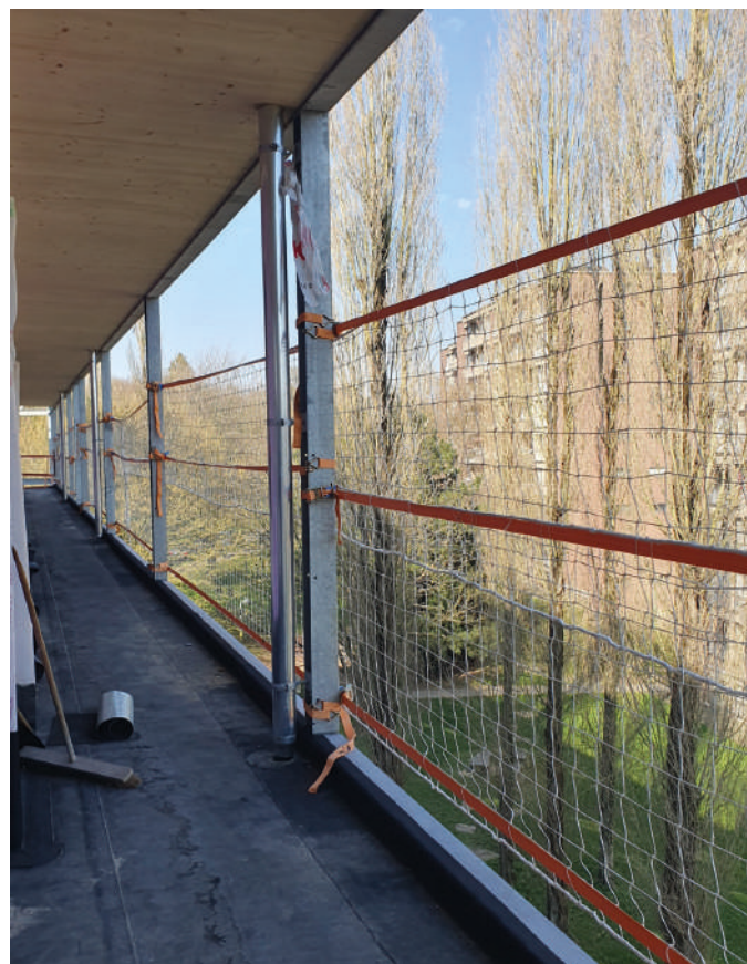
Extension périphérique de la terrasse avec mise en place d'un système de récupération des eaux pluviales, intégré et dissimulé derrière les poteaux en acier structurels.
