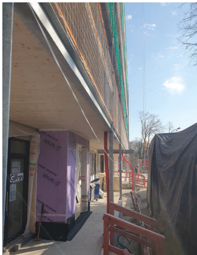
Extensions des chambres en blocs à ossature bois préfabriqués, avec l'intégration d'une baie vitrée donnant sur la terrasse au RDC. La structure est en acier, composée de poteaux verticaux du bas vers le haut, reliés par des poutres secondaires soudées.
