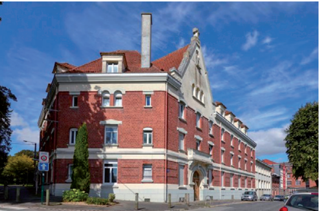
Fig 4. Maison d'enfant à caractère social «Elise Cestac» MECS de Baupauze en 2019 © Bouvet Hubert
