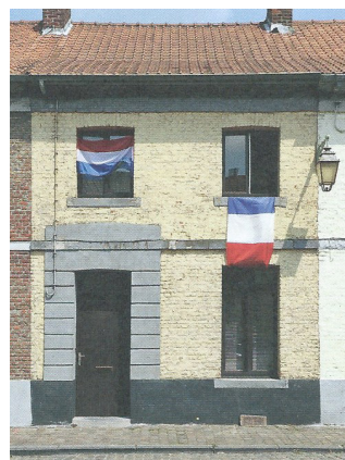
Fig. 54 Illustration d'une façade badigeonnée à la chaux
