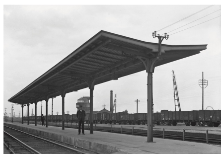
Figure 26 : L'abri-parapluie de Landen
