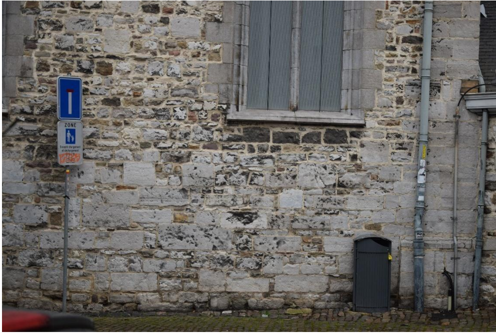
Figure 63. Huy, Église Saint-Mengold , extrémité orientale du mur gouttereau sud : vue depuis la Rue Saint-Mengold (© Gabriel Bister, 2025).
