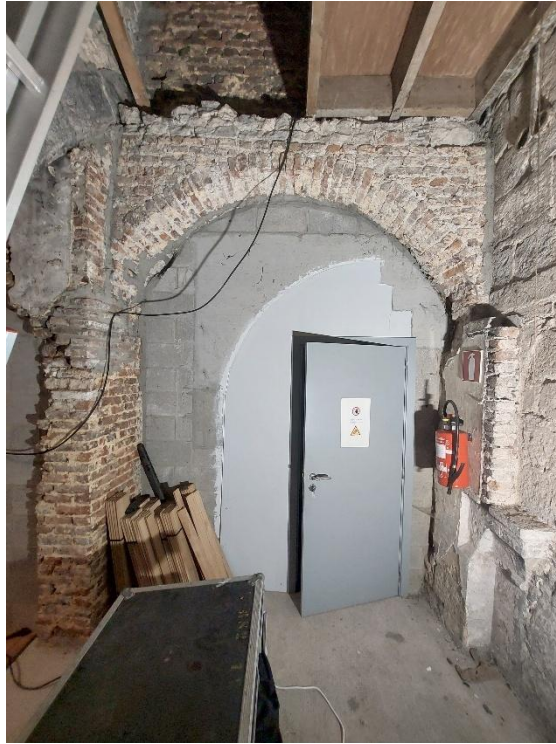
Figure 48. Huy, Église Saint-Mengold , arc en briques qui donne accès à la tribune : vue depuis la cage d'escalier (©Gabriel Bister, 2025).
