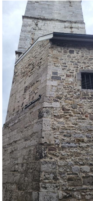
Figure 62. Huy, Église Saint-Mengold , chaîne à l'angle de la façade occidentale et du mur gouttereau du collatéral sud : vue depuis la Rue Saint-Mengold (© Gabriel Bister, 2025).
