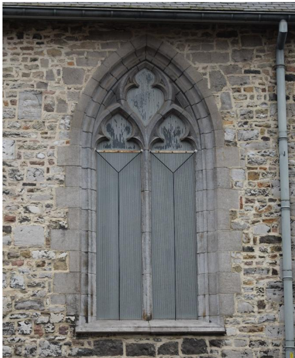
Figure 60. Huy, Église Saint-Mengold , fenêtre de la façade occidentale du collatéral sud : vue depuis la Rue Saint-Mengold (© Gabriel Bister, 2025).
