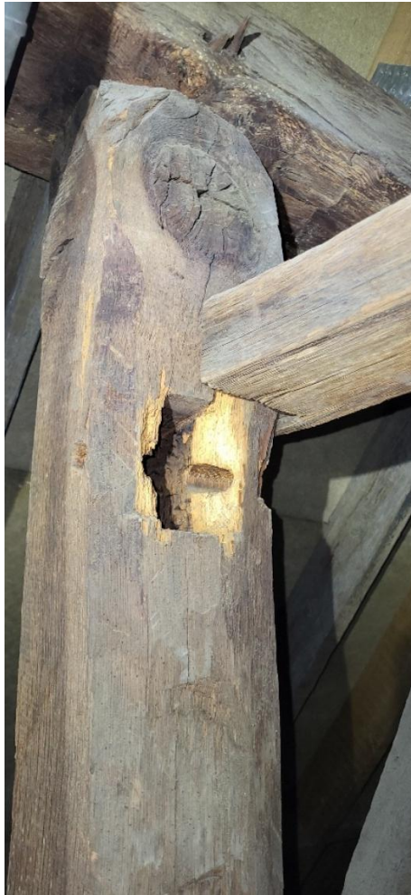
Figure 92. Huy, Église Saint-Mengold , trace de remploi sur un potelet de potence (© Gabriel Bister, 2025).
