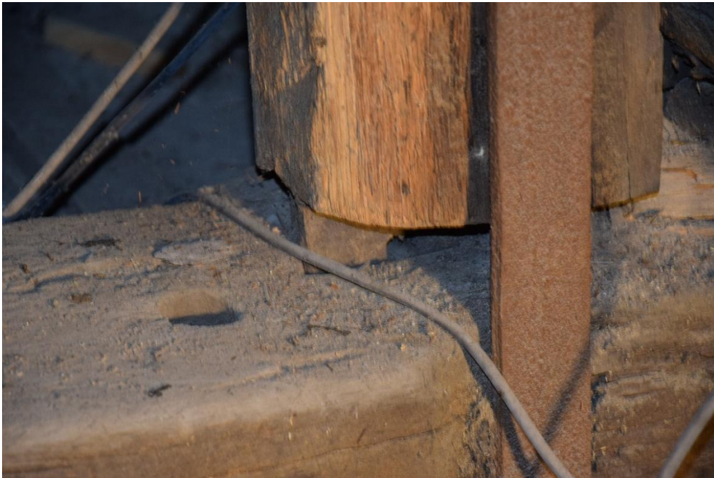
Figure 86. Huy, Église Saint-Mengold , assemblage d'un poinçon à l'entrait avec étrier (© Gabriel Bister, 2025).
