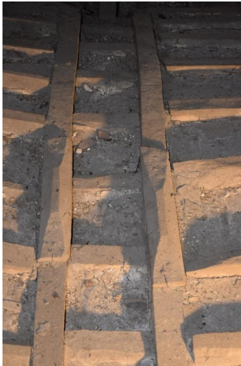
Figure 99. Huy, Église Saint-Mengold , sommet des arc doubleau de la fausse-voute, détail des liernes clavées et des agrafes (© Gabriel Bister, 2025).
