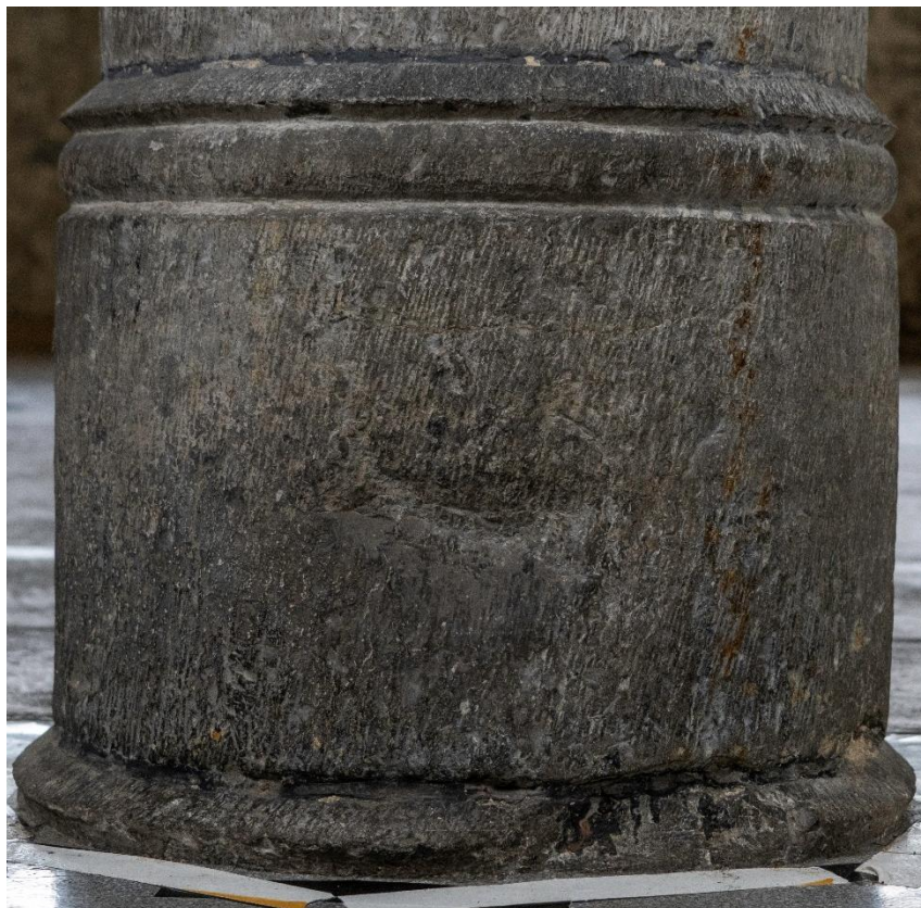
Figure 139. Huy, Église Saint-Mengold , détail de la taille d'une base de colonne [CLNb], circa dernier tiers du XV e siècle, (©Alexandre Bister, 2025).
