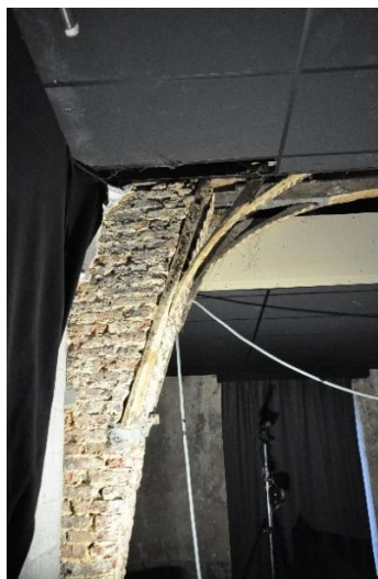
Figure 45. Huy, Église Saint-Mengold , pilier en briques qui écourte la première travée du collatéral nord : vue depuis la tribune en béton (©Gabriel Bister, 2025).
