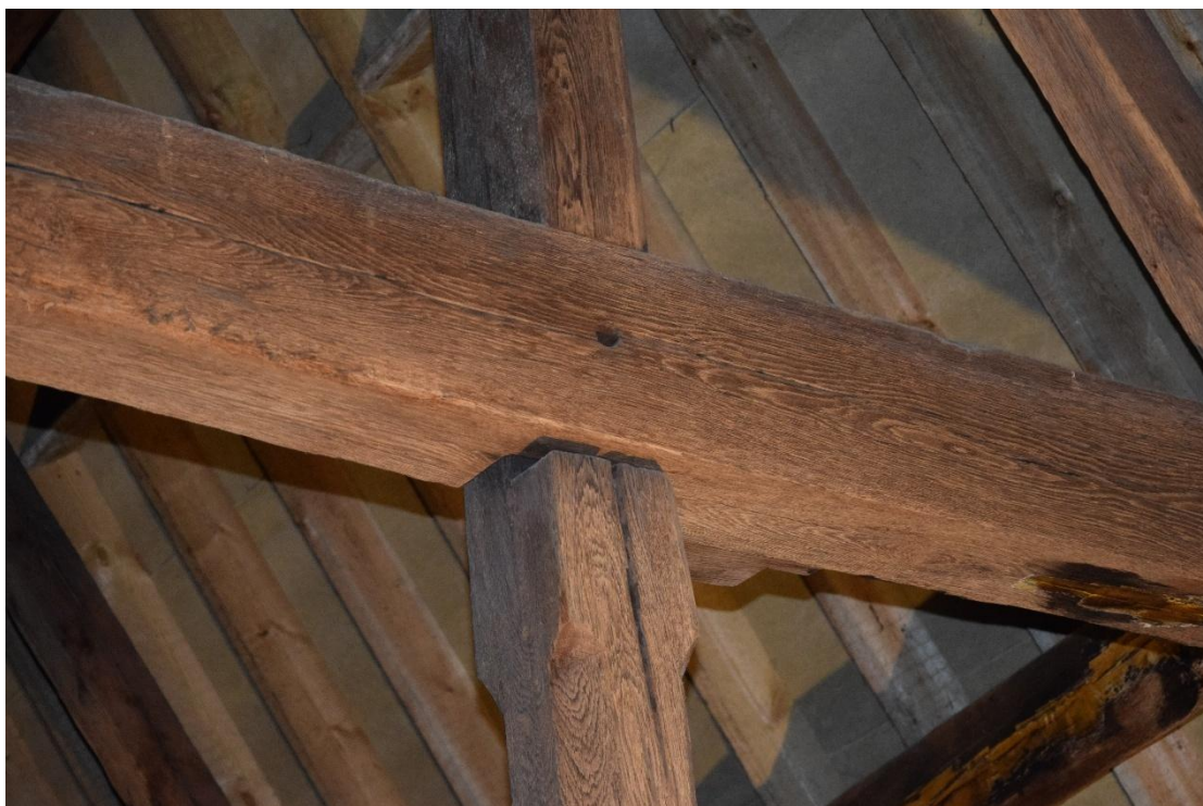
Figure 81. Huy, Église Saint-Mengold , assemblage du faux-entrait au poinçon (© Gabriel Bister, 2025).
