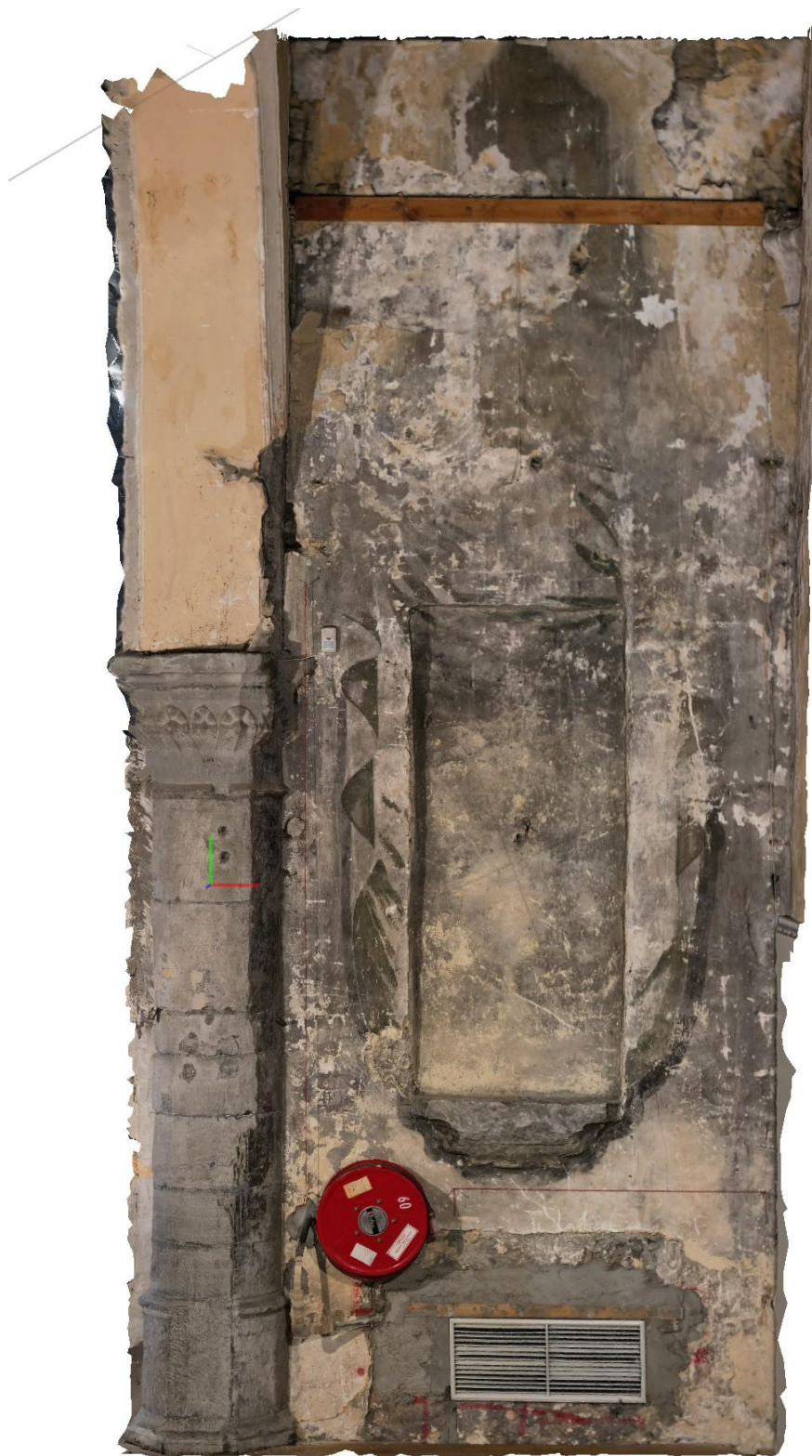
Figure 172. Huy, Église Saint-Mengold , le mur oriental du collatéral sud : vue depuis la nef, (© Gabriel Bister, 2025).
