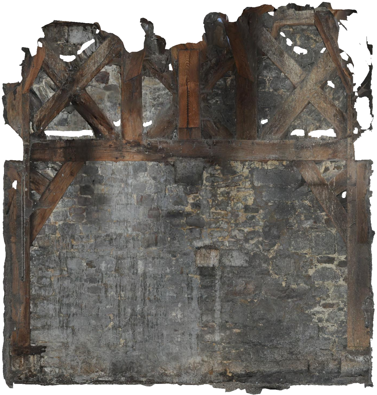
Figure 36. Huy, Église Saint-Mengold , face orientale de la tour au troisième étage : vue depuis le troisième étage de la tour (©Gabriel Bister [relevé photographique et orthophotographie], 2025).
