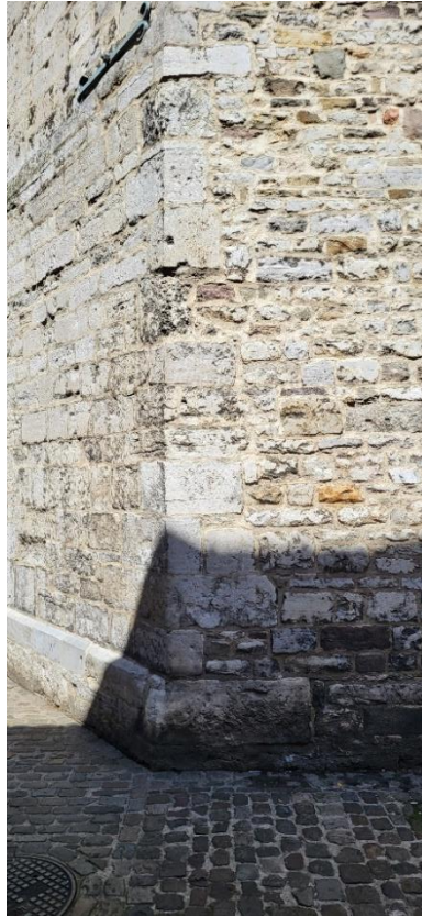
Figure 61. Huy, Église Saint-Mengold , chaîne à l'angle de la façade occidentale et du mur gouttereau du collatéral sud : vue depuis la Rue Saint-Mengold (© Gabriel Bister, 2025).
