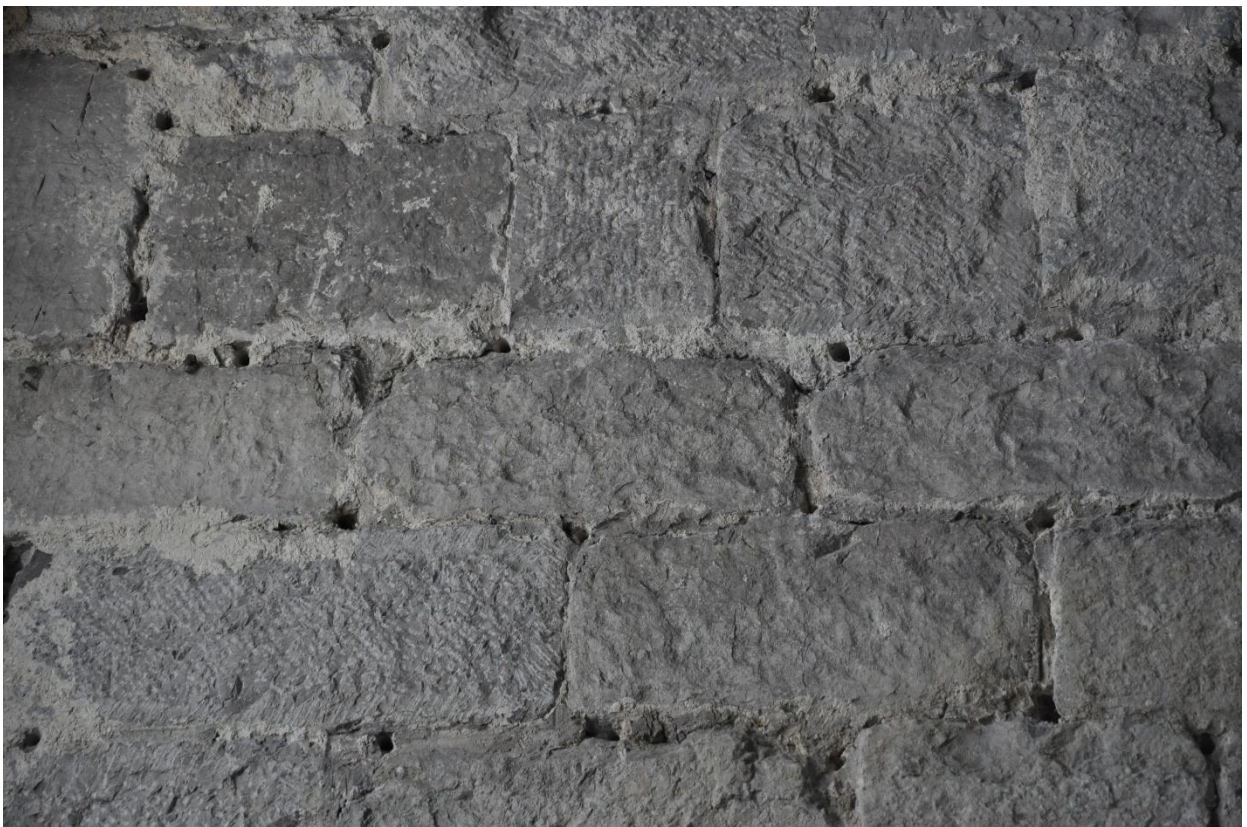
Figure 29. Huy, Église Saint-Mengold , face septentrionale de la tour au premier étage, détail de la variété des techniques de taille : vue depuis le premier étage de la tour (©Gabriel Bister, 2025).
