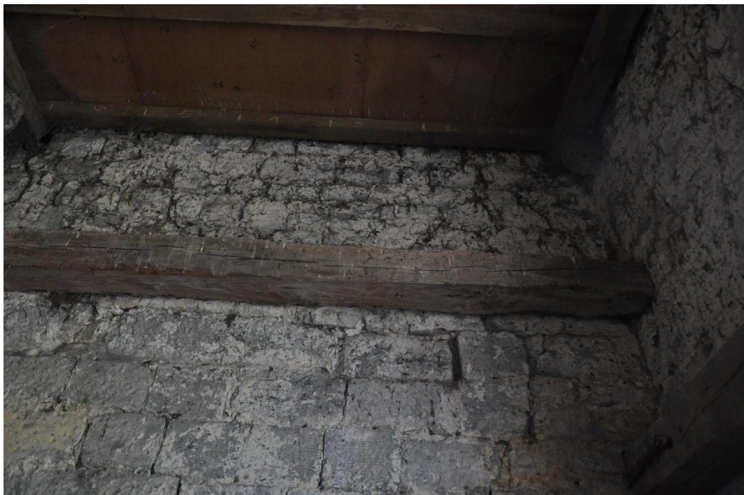
Figure 31. Huy, Église Saint-Mengold , face méridionale de la tour au premier étage : vue depuis le premier étage de la tour (©Gabriel Bister, 2025).
