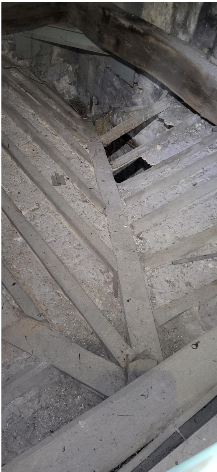
Figure 110. Huy, Église Saint-Mengold , quartier de la fausse-voute, détail de l'assemblage des chevrons à l'ogive cintrée (© Gabriel Bister, 2025).
