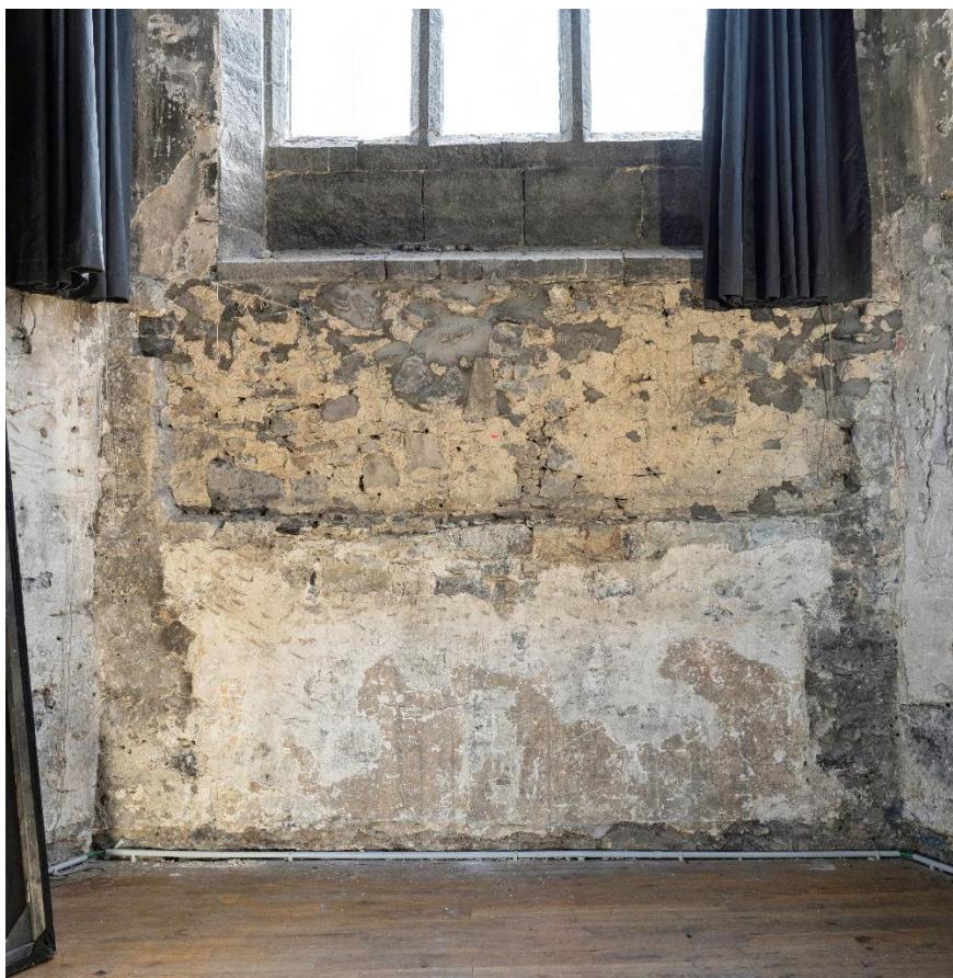
Figure 119. Huy, Église Saint-Mengold , pan central du chevet : vue depuis la nef (© Alexandre Bister).
