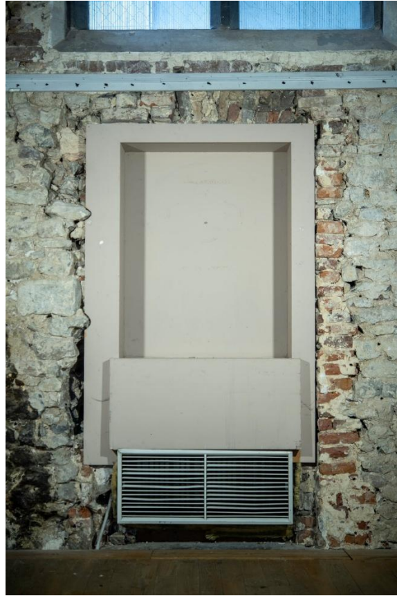
Figure 72. Huy, Église Saint-Mengold , extrémité orientale du mur septentrional du collatéral nord, détail de la baie comblée : vue depuis la nef (© Alexandre Bister, 2025)
