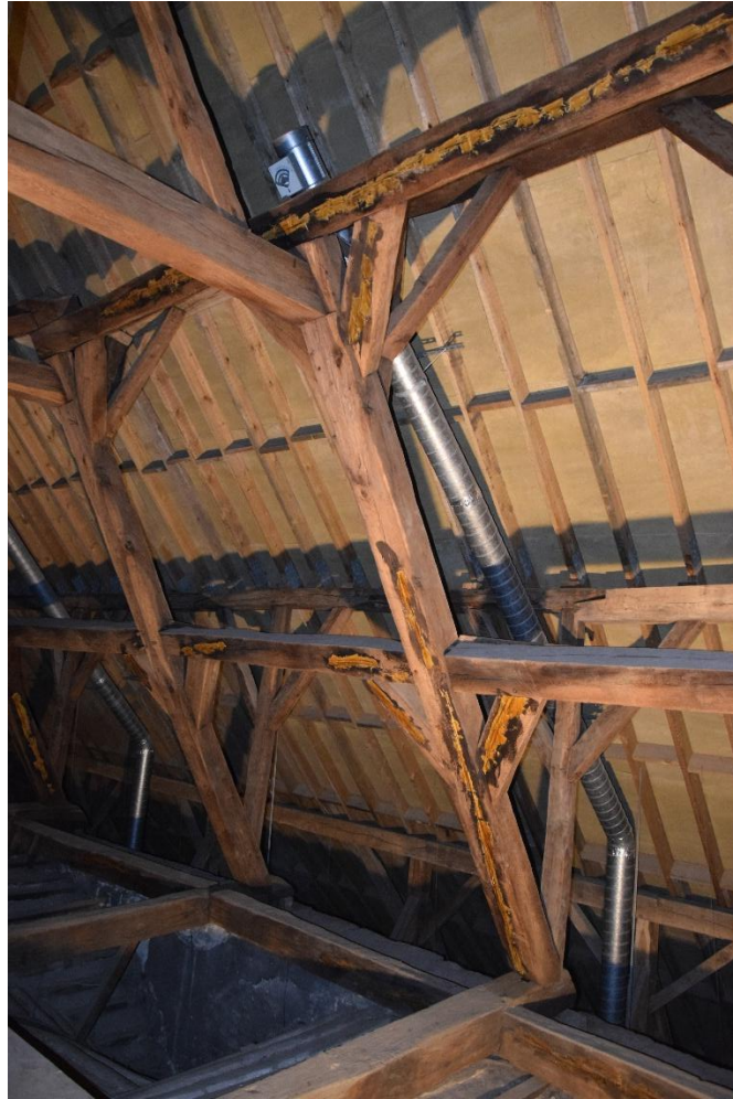
Figure 79. Huy, Église Saint-Mengold , assemblage du portique trapézoïdal (© Gabriel Bister, 2025).
