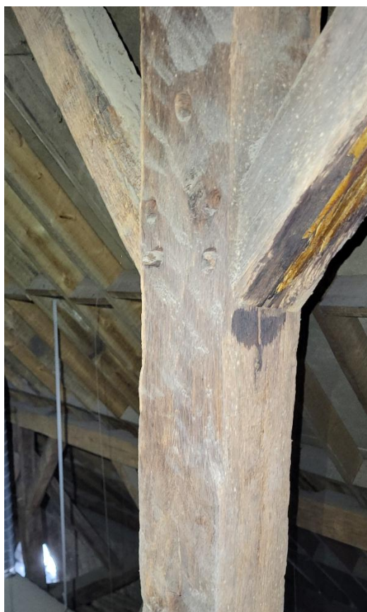
Figure 94. Huy, Église Saint-Mengold , potelet de potence, détails des cuvettes d'un débitage à la doloire (© Gabriel Bister, 2025).
