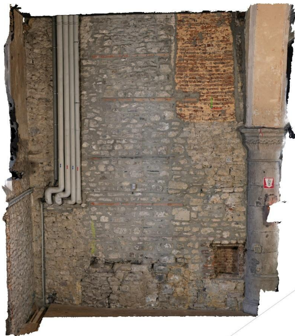
Figure 74. Huy, Église Saint-Mengold , le mur oriental du collatéral nord : vue depuis la nef (© Gabriel Bister [relevé photographique et photogrammétrie], 2025)
