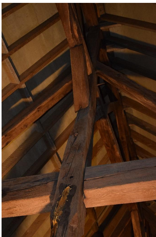
Figure 82. Huy, Église Saint-Mengold , assemblage de la sous-faîtière au poinçon (© Gabriel Bister, 2025).
