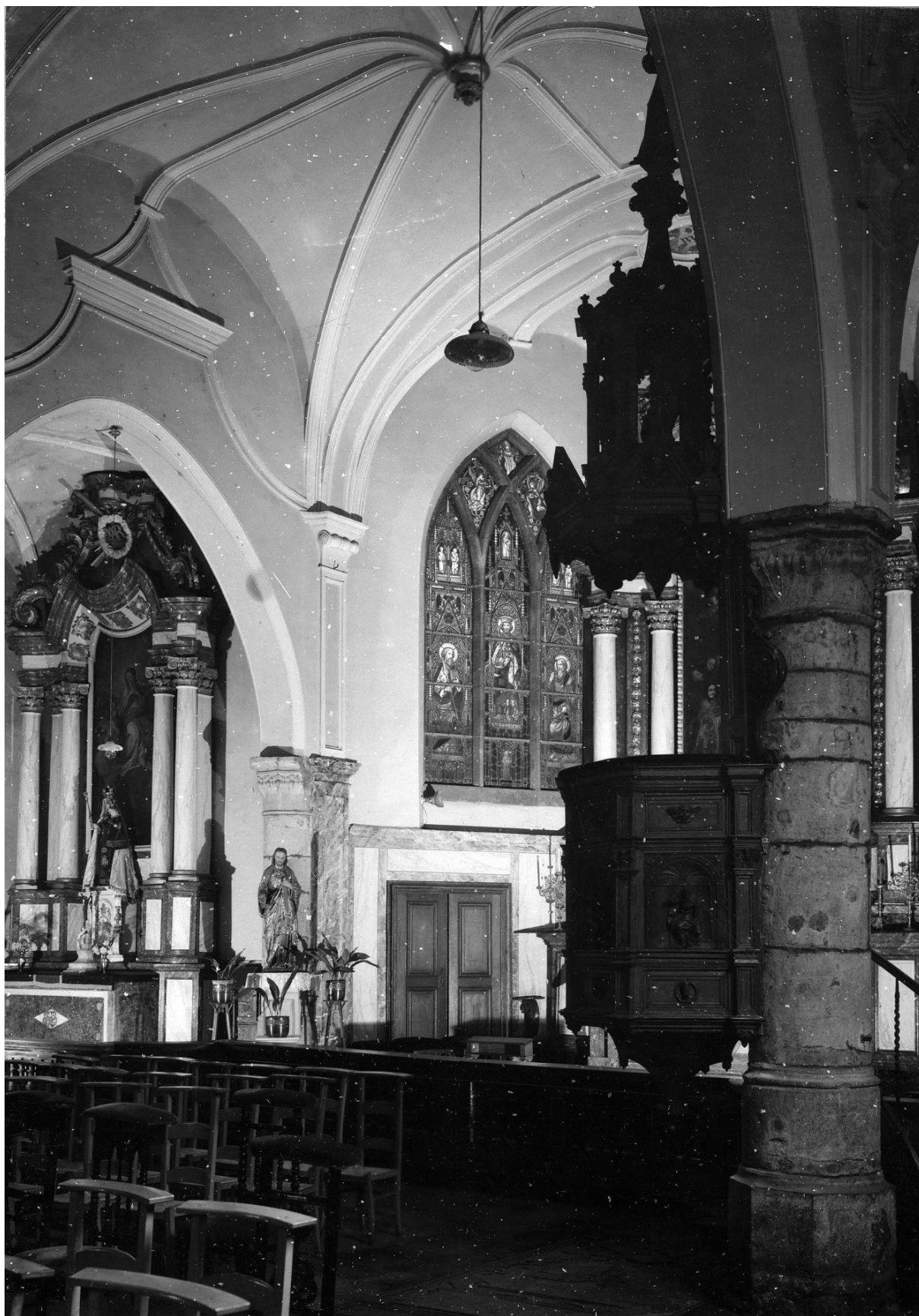
Figure 160. Huy, Église Saint-Mengold , vue du chœur depuis le collatéral sud, état 1916, (© KIK-IRPA, Bruxelles (Belgium), cliché A092390).
