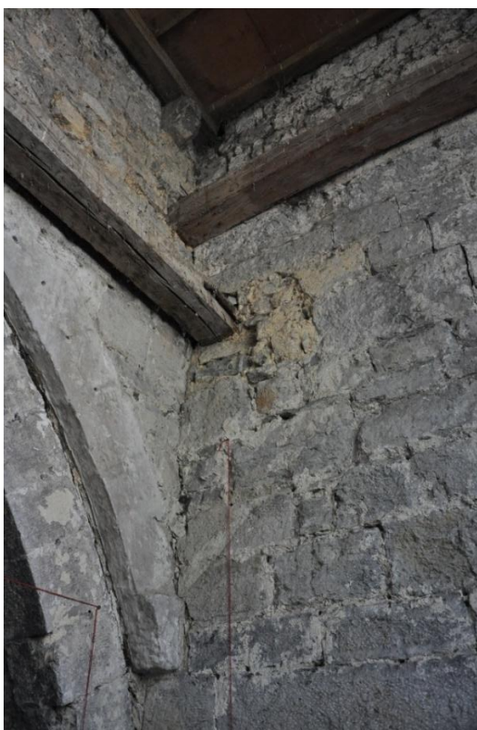
Figure 33. Huy, Église Saint-Mengold , face méridionale de la tour au premier étage : vue depuis le premier étage de la tour (©Gabriel Bister, 2025).
