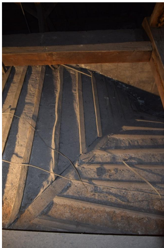
Figure 109. Huy, Église Saint-Mengold , quartier de la fausse-voûte, détail de l'assemblage des chevrons à l'ogive cintrée (© Gabriel Bister, 2025).
