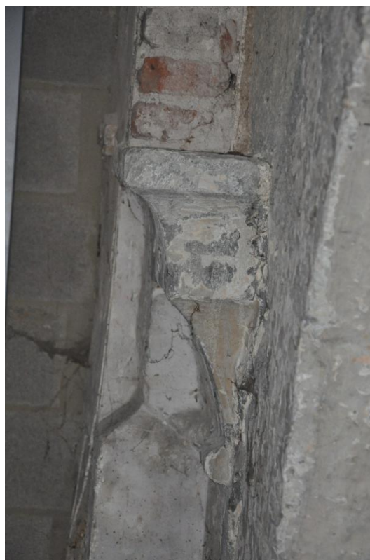
Figure 22. Huy, Église Saint-Mengold , culot du pilier oriental nord : vue depuis le premier étage de la cage d'escalier (© Gabriel Bister, 2025).
