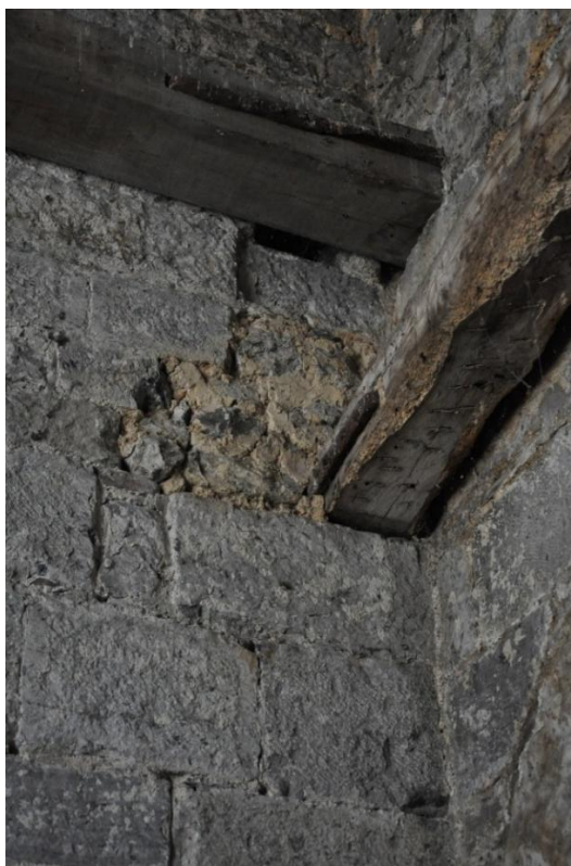
Figure 32. Huy, Église Saint-Mengold , face septentrionale de la tour au premier étage, détail des encastresments des poutres dans les maçonneries : vue depuis le premier étage de la tour (©Gabriel Bister, 2025).
