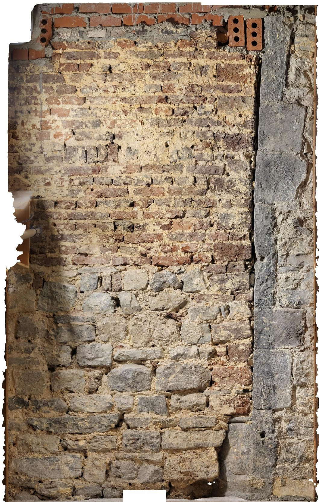
Figure 40. Huy, Église Saint-Mengold , face septentrionale de la cloison de la cage d'escalier : vue depuis les sanitaires (© Gabriel Bister [relevé photographique et orthophotographie], 2025).
