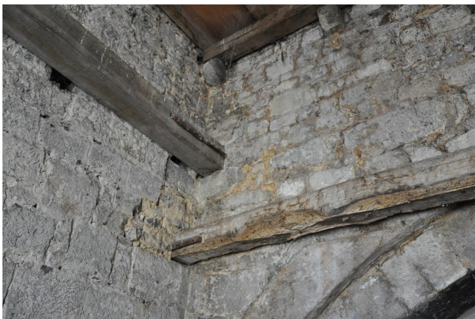
Figure 25. Huy, Église Saint-Mengold , face orientale de la tour au premier étage : vue depuis le premier étage de la tour (©Gabriel Bister, 2025).
