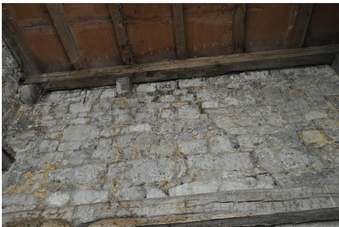
Figure 24. Huy, Église Saint-Mengold , face orientale de la tour au premier étage : vue depuis le premier étage de la tour (© Gabriel Bister, 2025).
