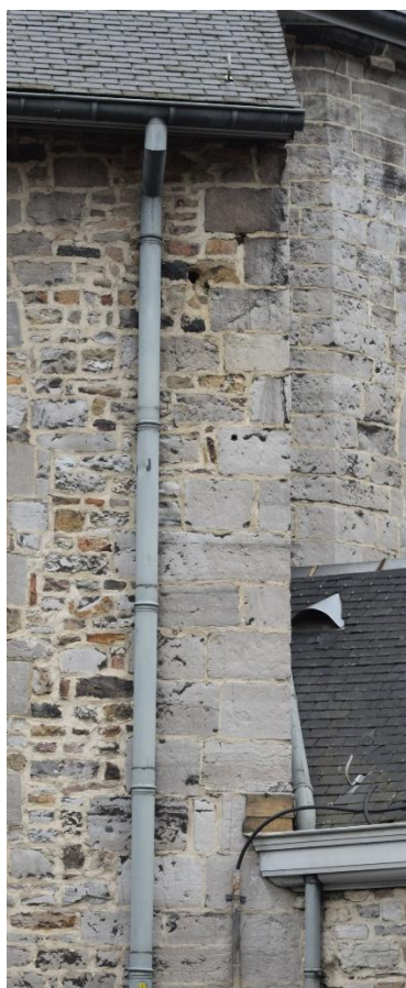
Figure 66. Huy, Église Saint-Mengold , chaîne à l'angle du mur gouttereau et de la façade orientale du collatéral sud : vue depuis la Rue Saint-Mengold (© Gabriel Bister, 2025).
