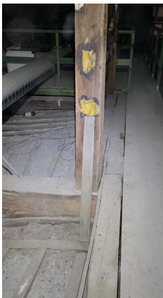
Figure 101. Huy, Église Saint-Mengold , détail d'un tirant de la fausse-voûte (© Gabriel Bister, 2025).
