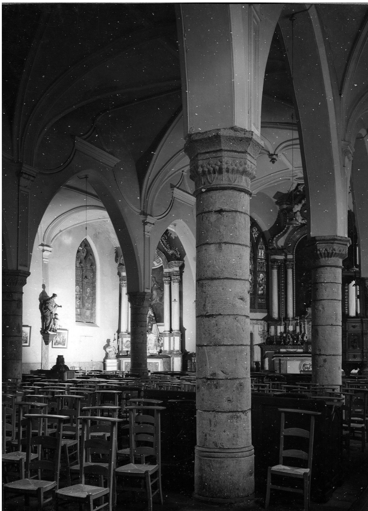
Figure 159. Huy, Église Saint-Mengold , vue large de la nef depuis l'extrémité occidentale du collatéral sud, état 1916, (© KIK-IRPA, Bruxelles (Belgium), cliché A092389).
