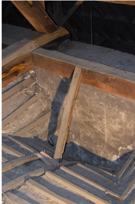
Figure 103. Huy, Église Saint-Mengold , détail d'un tirant de la fausse-voûte (© Gabriel Bister, 2025).
