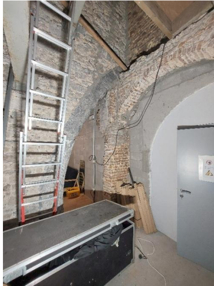
Figure 43. Huy, Église Saint-Mengold , pilier en briques qui écourte la première travée du collatéral nord : vue depuis le premier étage de la cage d'escalier (© Gabriel Bister, 2025).
