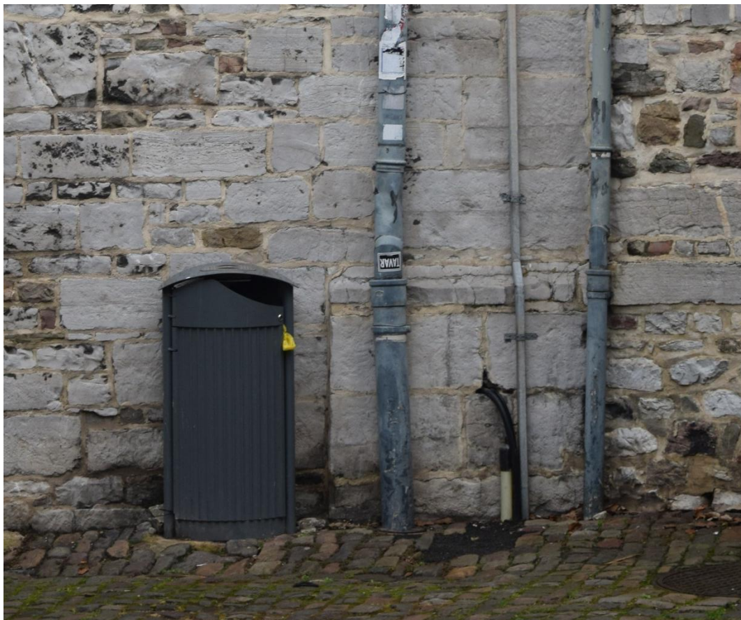
Figure 64. Huy, Église Saint-Mengold , soubassement chanfreiné à l'extrémité orientale du mur gouttereau sud : vue depuis la Rue Saint-Mengold (© Gabriel Bister, 2025).
