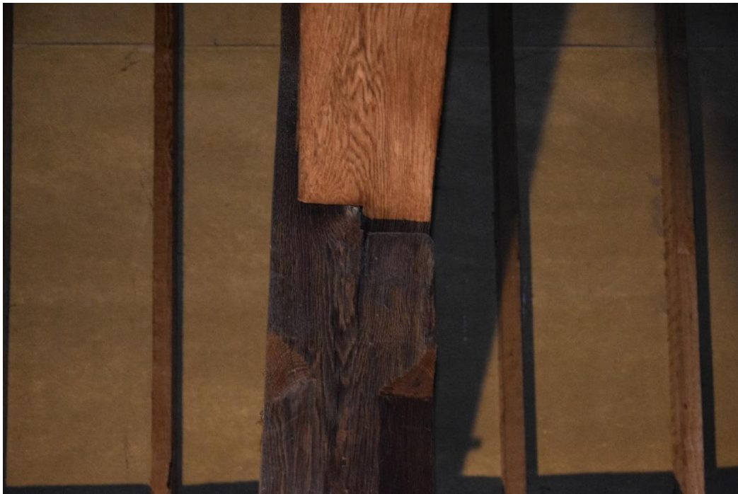
Figure 80. Huy, Église Saint-Mengold , assemblage du faux-entrait au poinçon (© Gabriel Bister, 2025).
