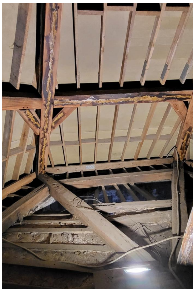
Figure 123. Huy, Église Saint-Mengold , charpente du chœur, détail des coyers, longrines et arbalétriers (© Gabriel Bister, 2025).
