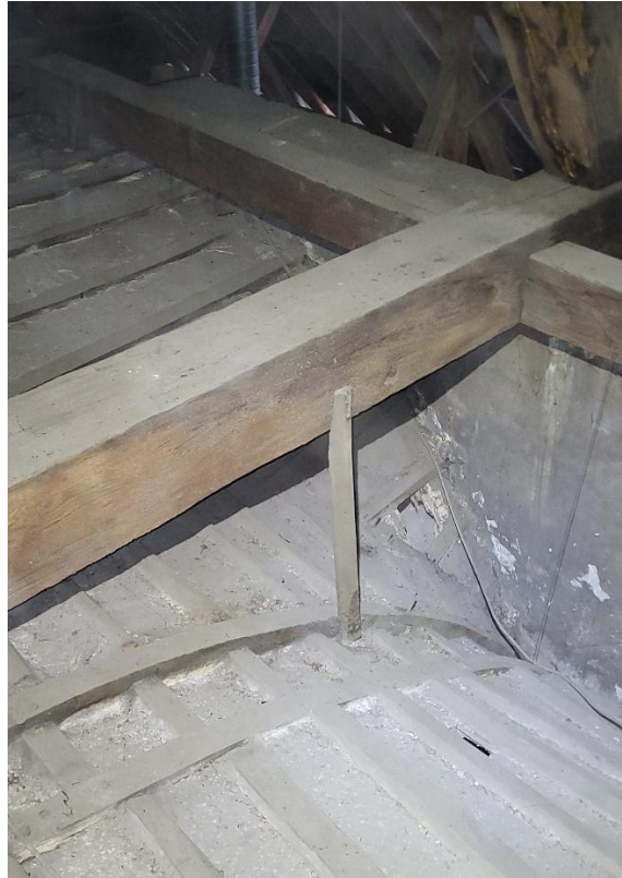
Figure 102. Huy, Église Saint-Mengold , détail d'un tirant de la fausse-voûte (© Gabriel Bister, 2025).
