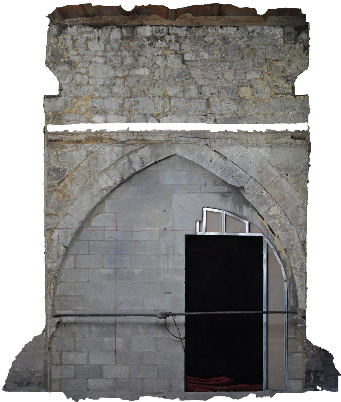
Figure 20. Huy, Église Saint-Mengold , face orientale de la tour au premier étage : vue depuis le premier étage de la tour (©Gabriel Bister [relevé photographique et orthophotographie], 2025).
