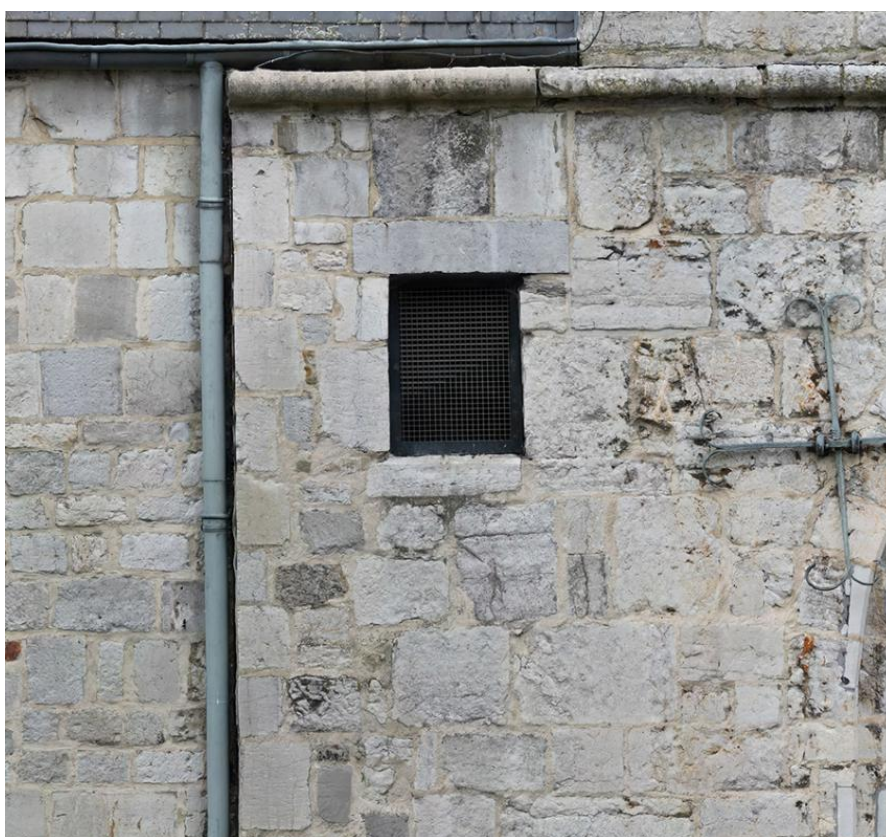
Figure 11. Huy, Église Saint-Mengold , fenêtre dans le coin supérieur du premier registre de la façade occidentale de la tour : vue depuis la Place Verte (© Mathieu Piavaux, 2025).
