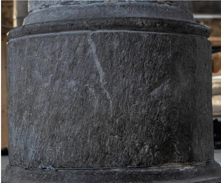
Figure 138. Huy, Église Saint-Mengold , détail de la taille d'une base de colonne [CLNC], circa dernier tiers du XV e siècle, (©Alexandre Bister, 2025).
