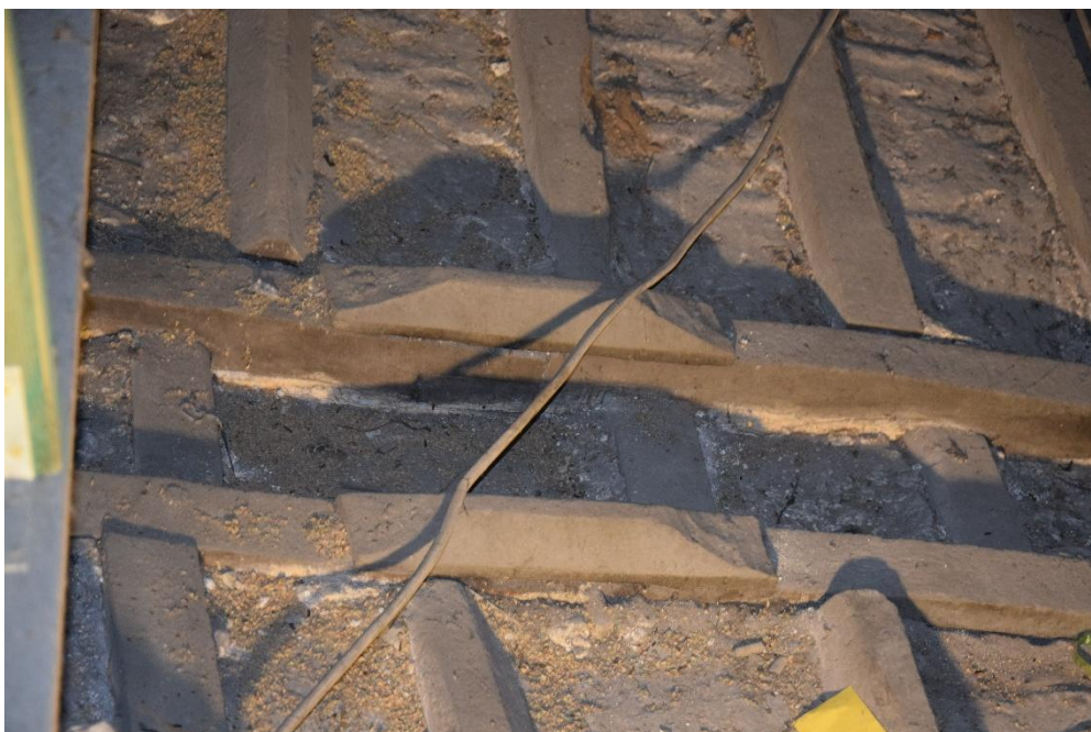
Figure 100. Huy, Église Saint-Mengold , sommet des arc doubleau de la fausse-voûte, détail des liernes clavées et des agrafes (© Gabriel Bister, 2025).
