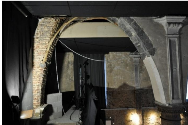
Figure 44. Huy, Église Saint-Mengold , pilier en briques qui écourte la première travée du collatéral nord : vue depuis la tribune en béton (©Gabriel Bister, 2025).
