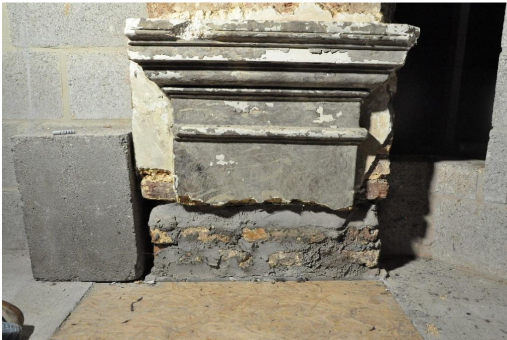
Figure 47. Huy, Église Saint-Mengold , chapiteau de pilastre en stuc adossé au pilier en briques : vue depuis la tribune en béton (©Gabriel Bister, 2025).
