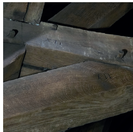
Figure 29 : Marques de charpentier © J.-L. Vanden Eynde (2025)
