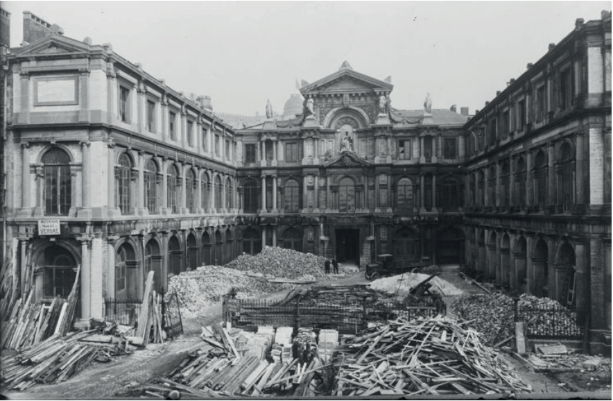
Figure 3 : 1928, démolition de l'ancien Palais Granvelle, un ouvrage datant de 1550 qui se situait à l'emplacement de l'actuelle galerie Ravenstein. © KIK-IRPA, cliché A105361
