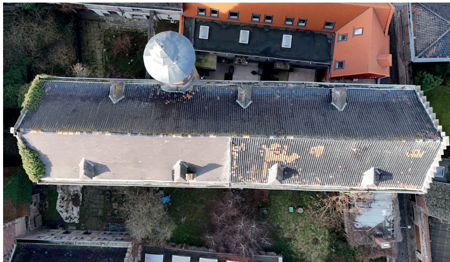
Figure 51 : Toiture du mont. © Valentin Bouvry (2026)
