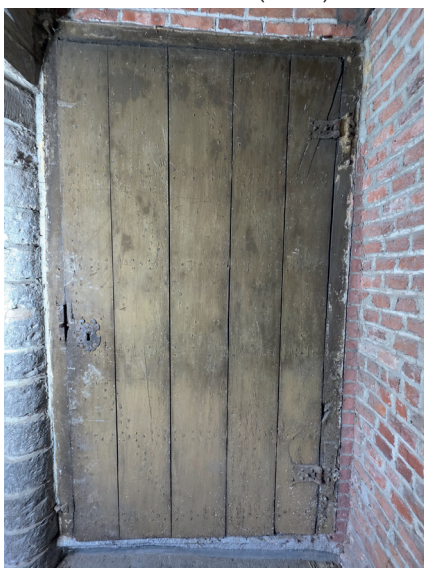
Figure 65 : Porte de la tourelle. © J.-L. Vanden Eynde (2025)
