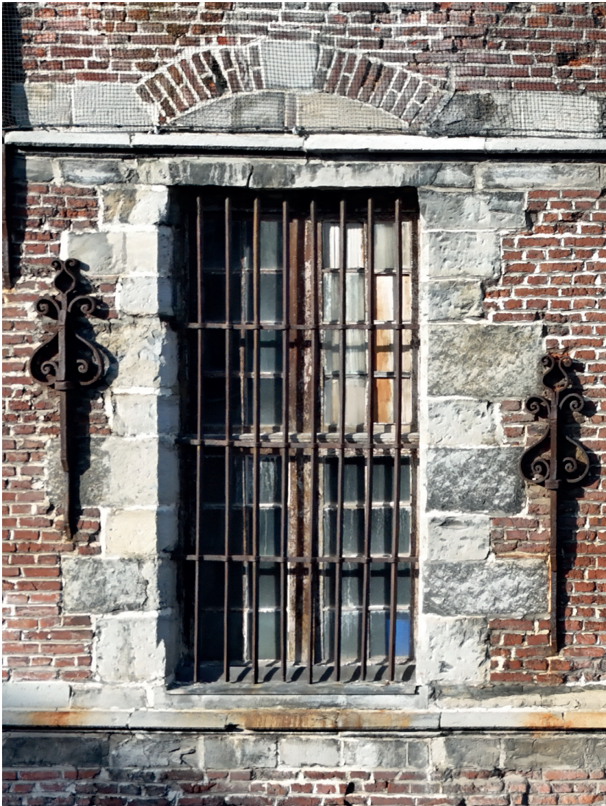
Des grilles en fer forgé sécurisent les baies tout en reprenant les charges verticales. Ce bâtiment est l'un des premiers construits à Tournai dont les fenêtres ne comportent pas de meneaux.
