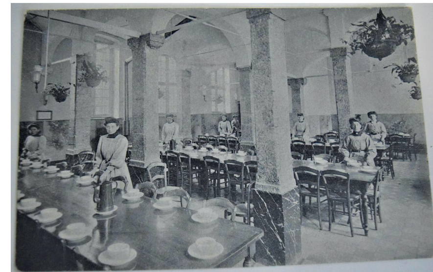
Figure 40 : Réfectoire de l'internat dans la grande salle du rdc (1904). Photographie extraite de delcampe.net
