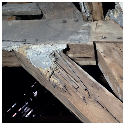
Figure 49 : Trace de plafonnage. © J.-L. Vanden Eynde (2025)
