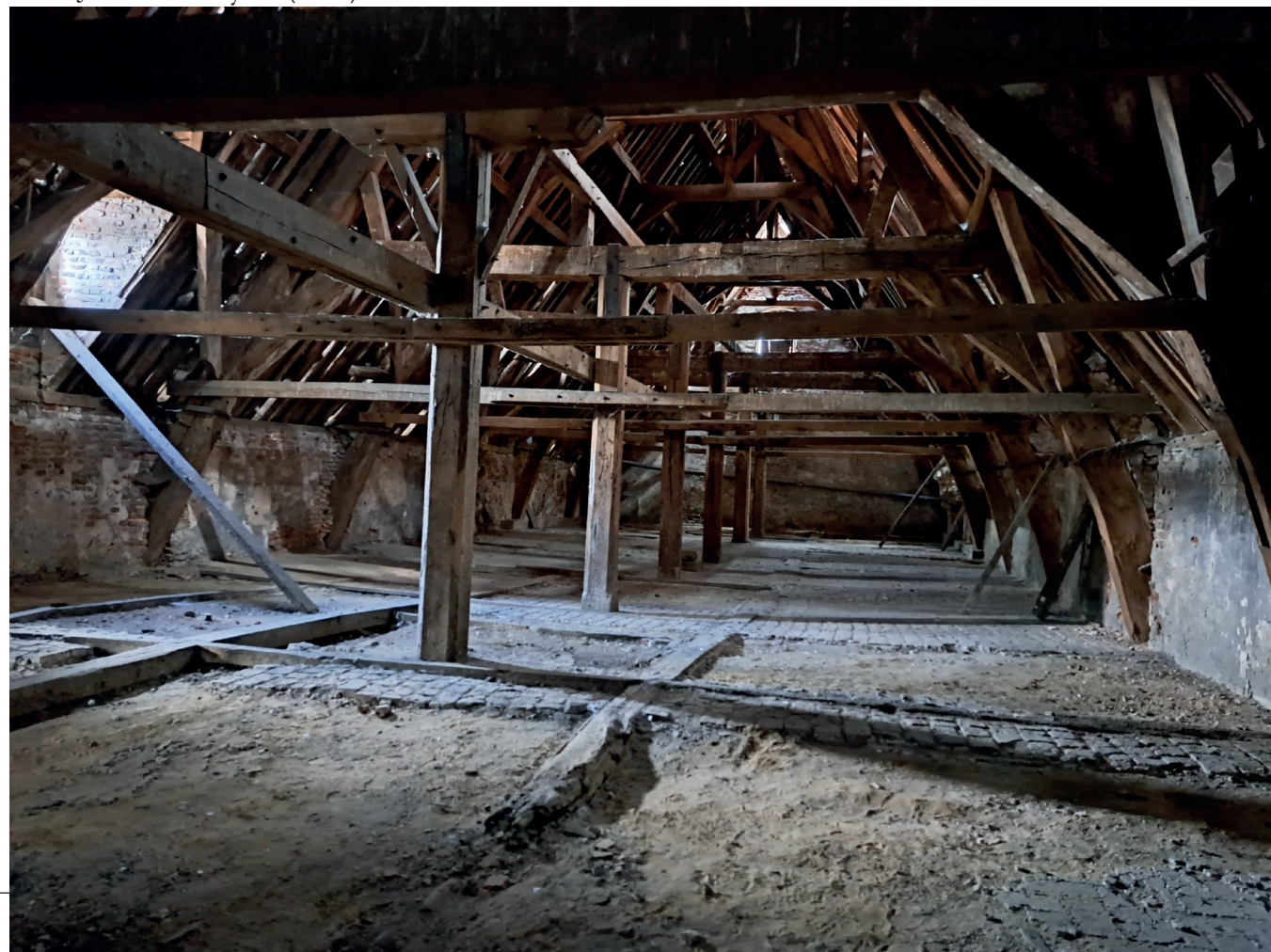
Figure 30 : Photo de la charpente © J.-L. Vanden Eynde (2023)
