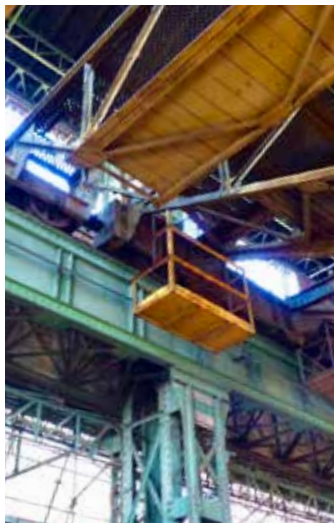
(11) Le Pont roulant Jaune et la structure Verte @t.gempp
