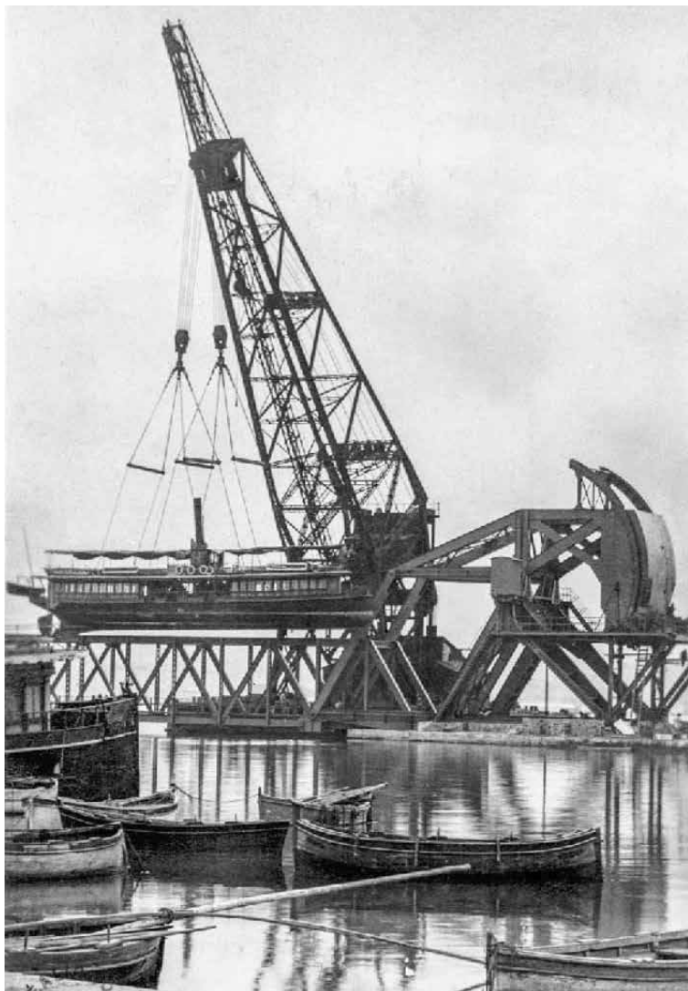
(9) Grue Atlas détruite en 1994
