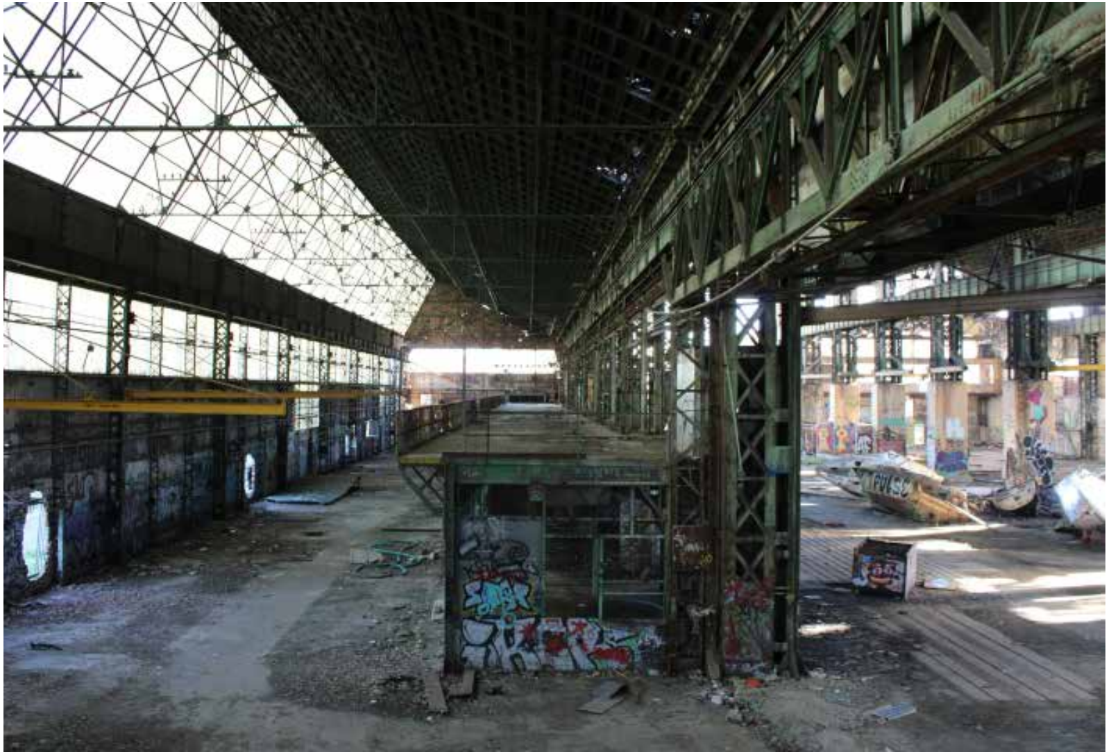
(26) Photographie de l'intérieur de l'Atelier Mécanique vue de la mezzanine @a.gempp
