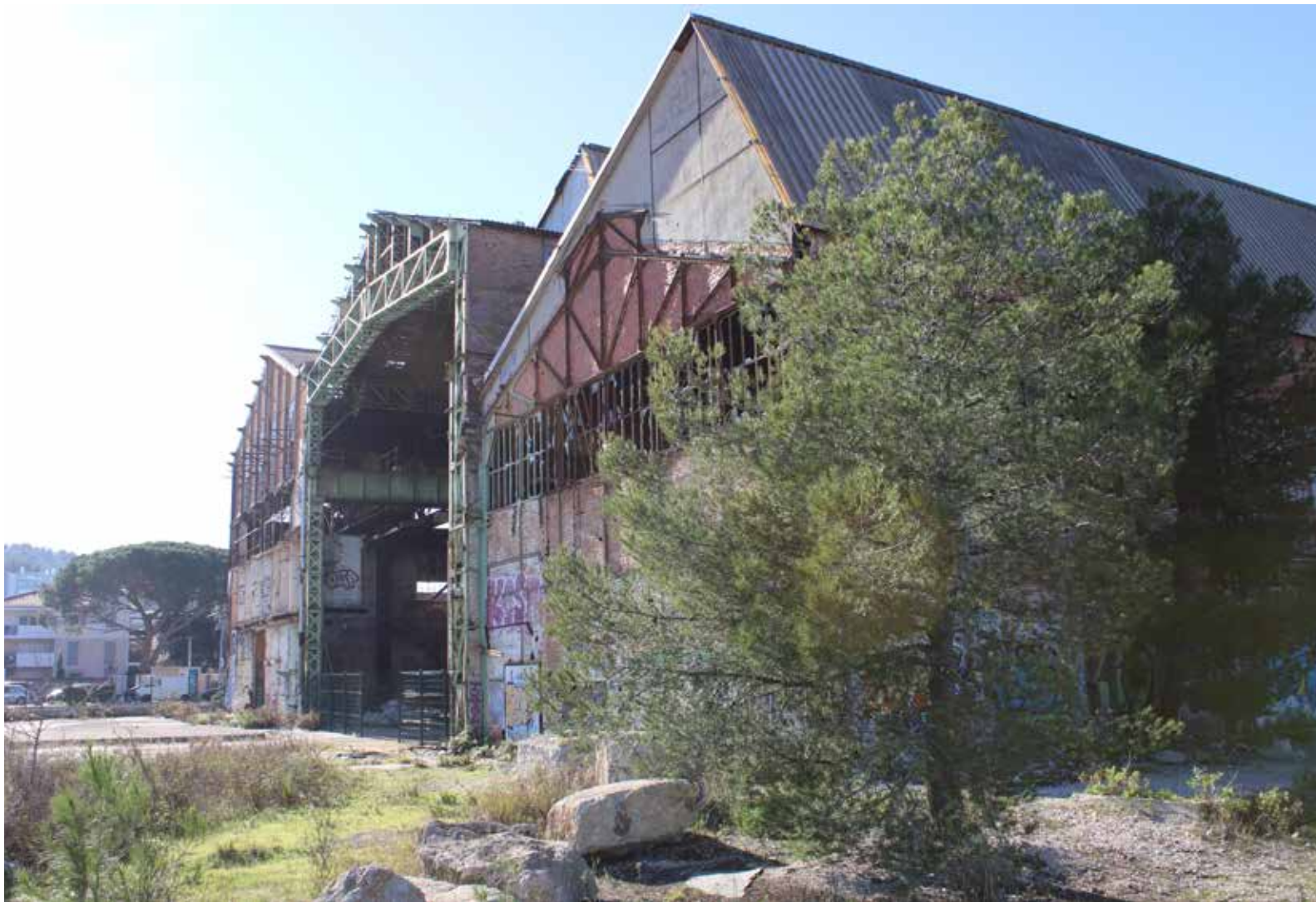
(20) Photographie de l'Atelier Mécanique vue de la dalle (Façade Est) @a.gempp
