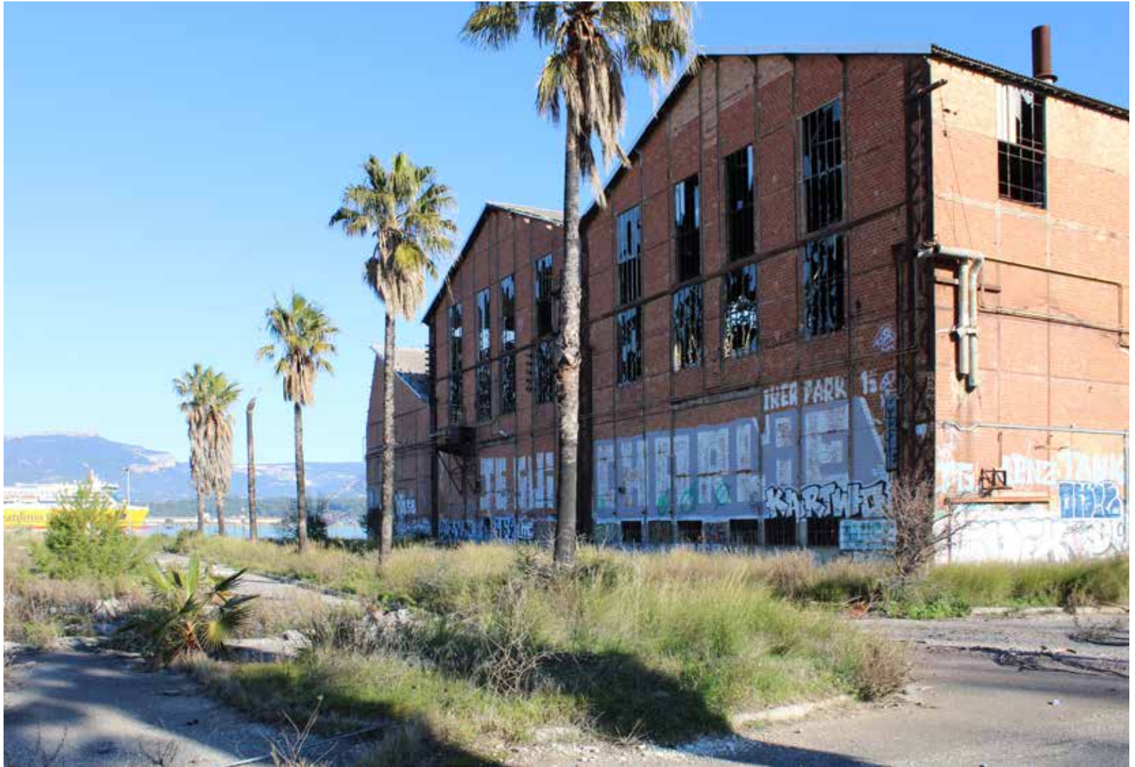
(19) Photographie de l'Atelier Mécanique vue de la ville (Façade Sud et Ouest) @a.gempp
