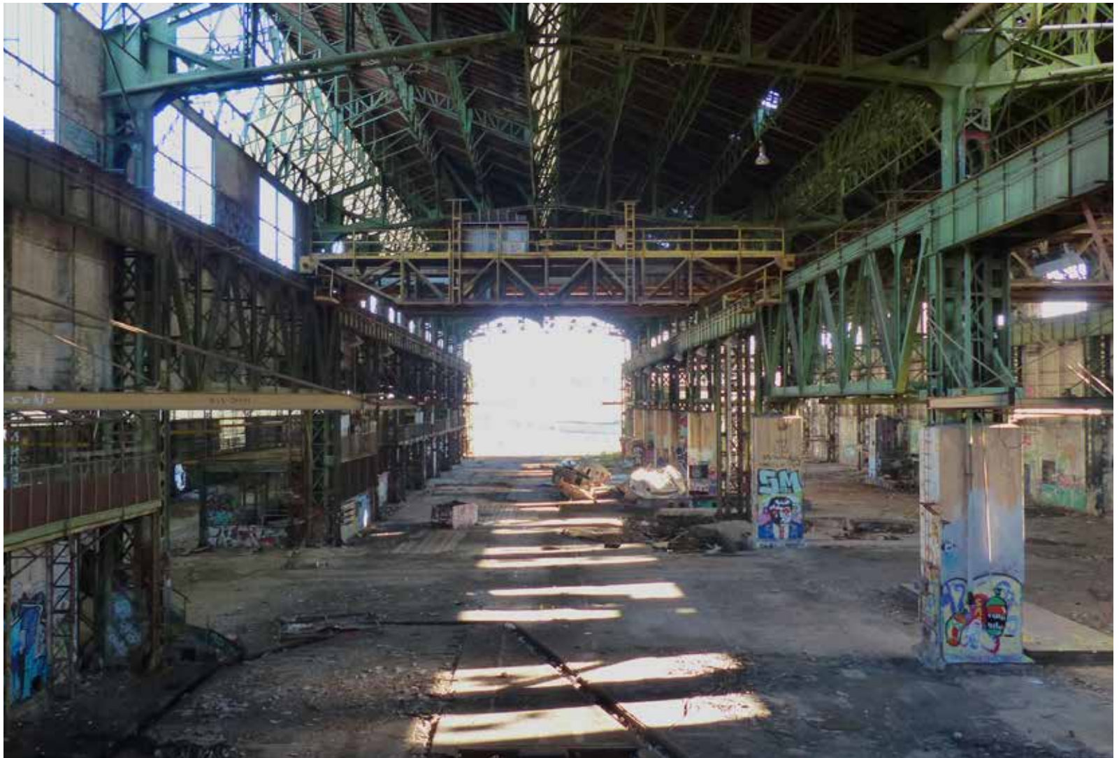
(29) Photographie de l'intérieur de l'Atelier Mécanique Nef 2 : centrale @t.gempp
