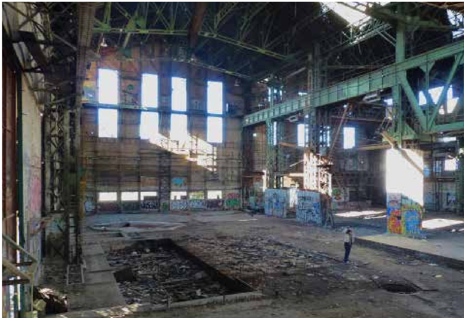
(28) Photographie de l'intérieur de l'Atelier Mécanique Nef 1 @t.gempp
