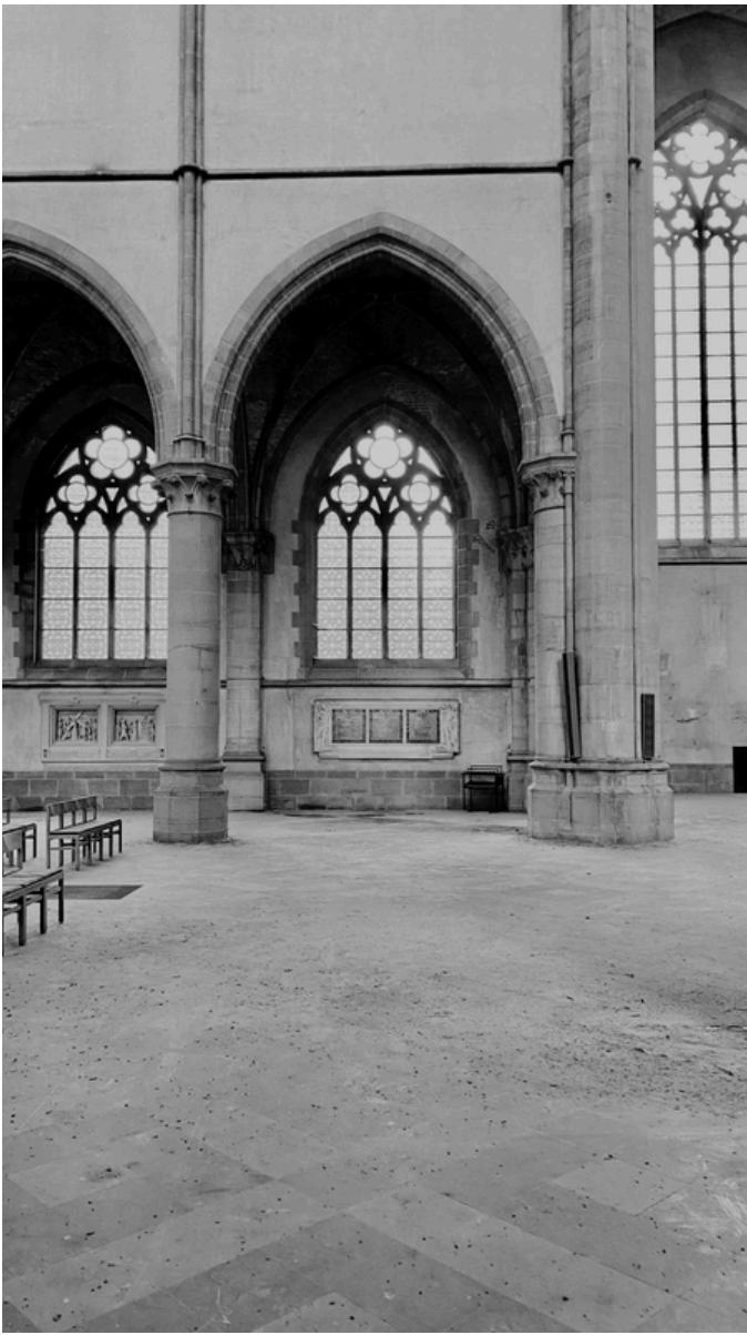
depuis la nef vers la dernière travée du collatéral sud
