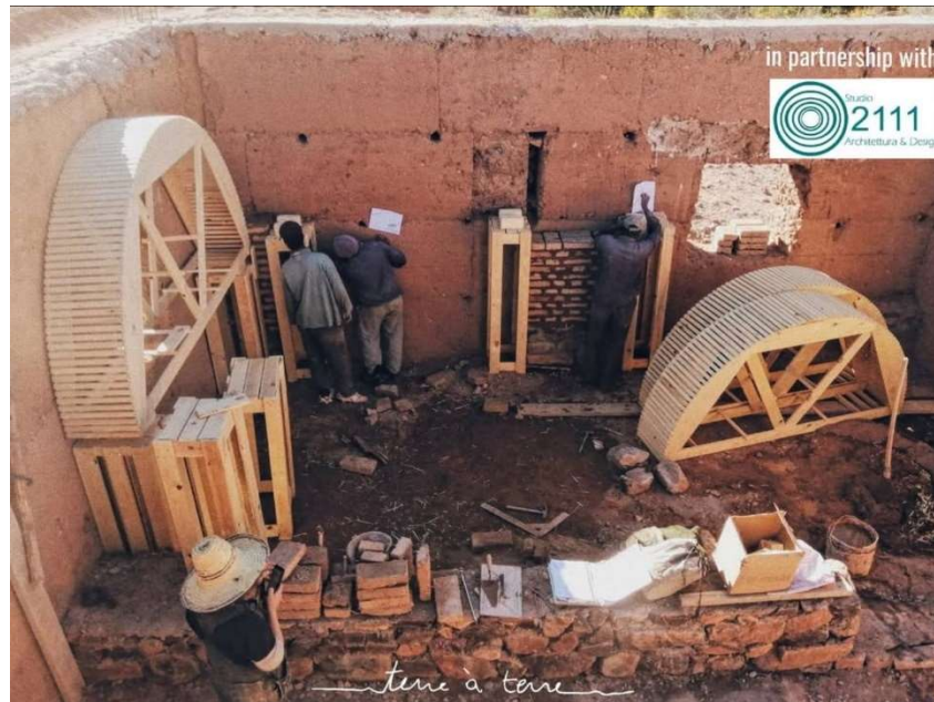
Fig. 60 : Supervision des travaux par Studio 2111, crédit Terre à Terre.
