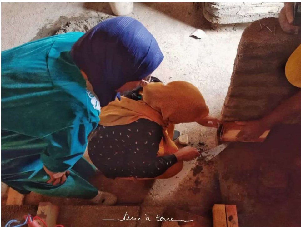
Fig. 65 : Travaux de finition intérieur dans le projet de Imloul, crédit Terre à Terre.
