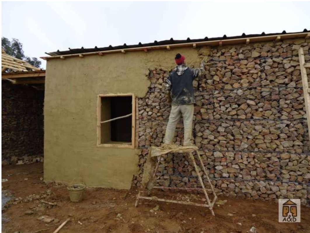
Fig. 58 : Application de l'enduit de finition, crédit Architecture&Développement.
