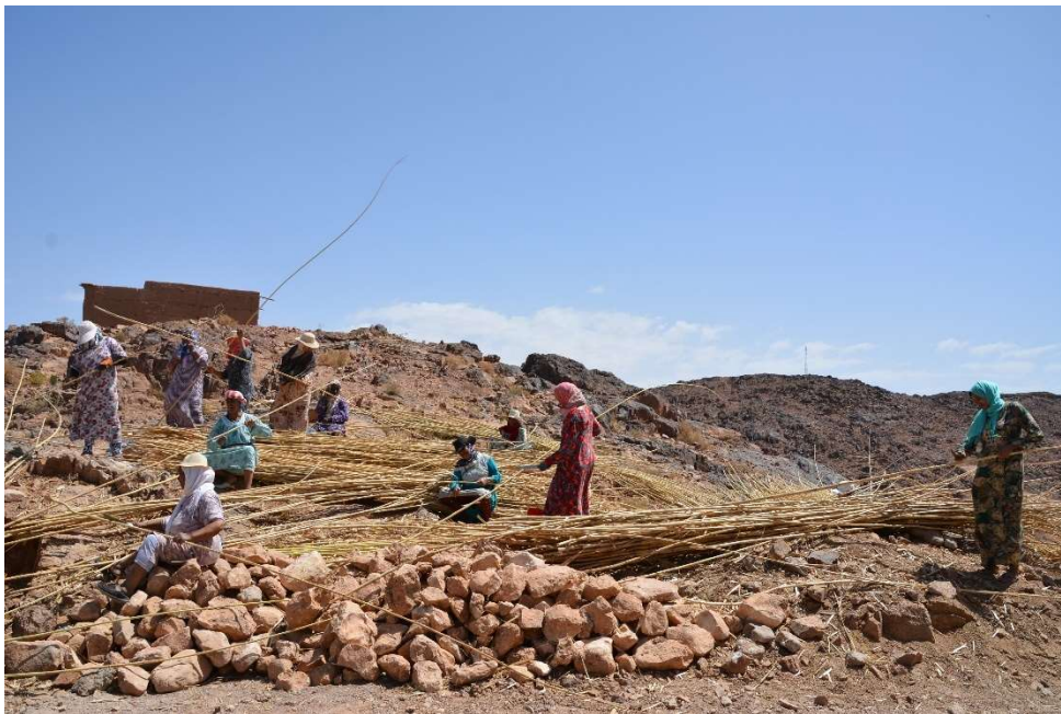
Fig. 62 : Préparation du bambou pour la toiture dans le projet de Ouled Merzoug, tiré du site Archdaily.com.
