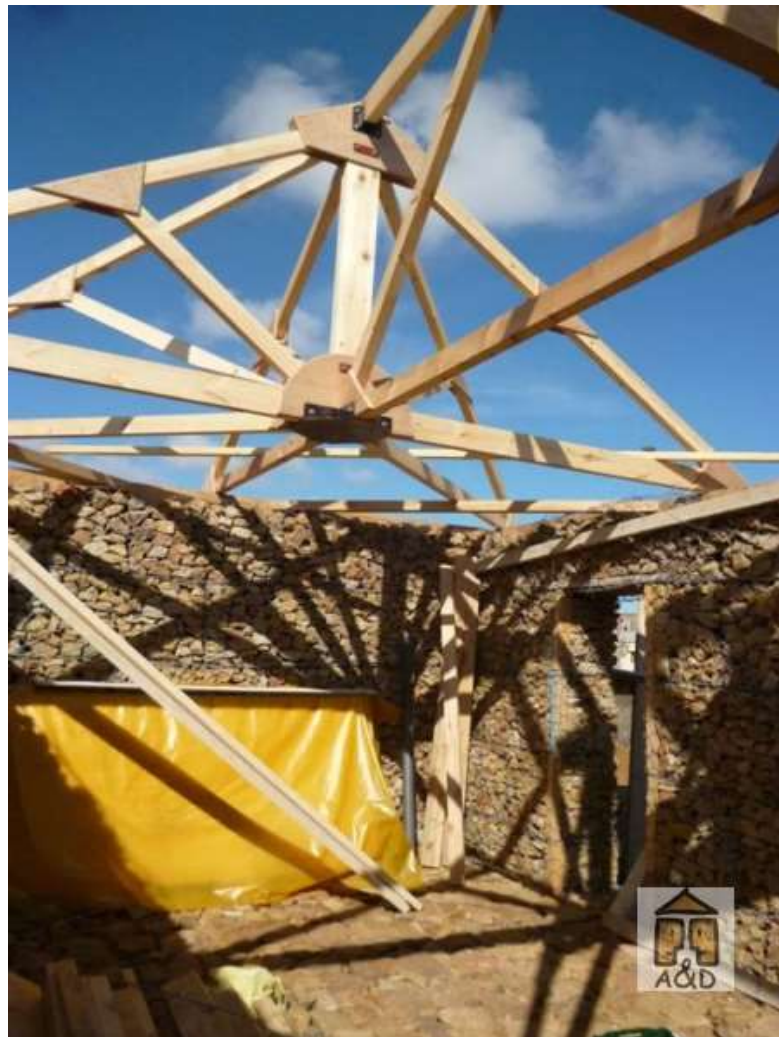
Fig. 57 : Pose de la toiture, crédit Architecture&Développement.
