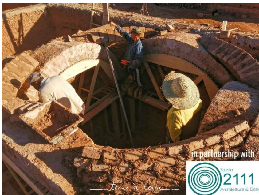
Fig. 61 : Fermeture de la voûte en cours, crédit Terre à Terre.
