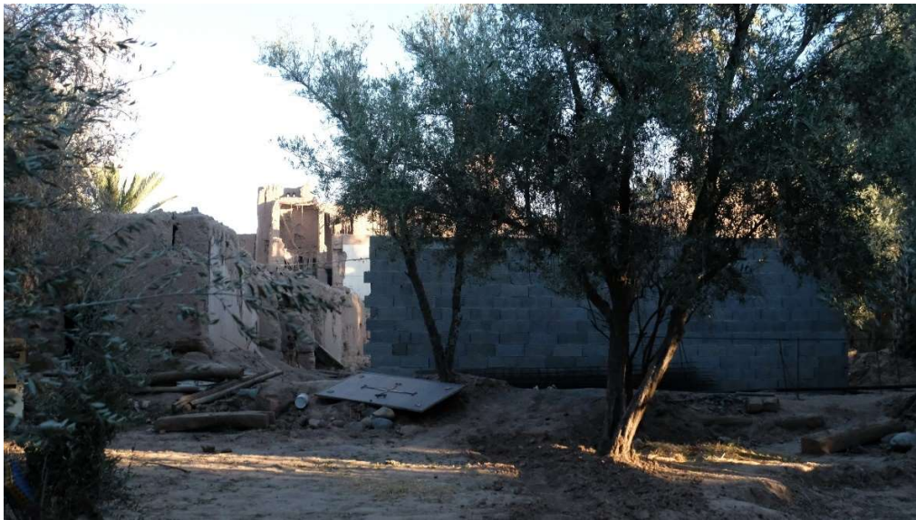
Fig. 1 : Reconstruction en ciment d'une maison détruite par le séisme, face à ses ruines, dans le village de Tajanate. Photo partagée par Jérôme Lemaire, habitant du village.
