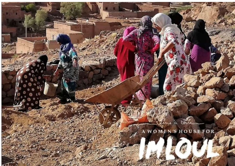
Fig. 64 : Collecte et transport des pierres dans le projet de Imloul, crédit Terre à Terre.
