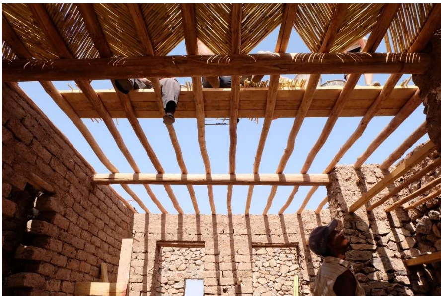
Fig. 19 : Travaux de pose de la toiture, tiré du site Archdaily.com.
