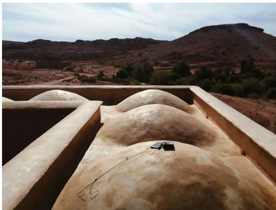
Fig. 59 : Vue sur la toiture voûtée enduite, crédit Terre à Terre.
