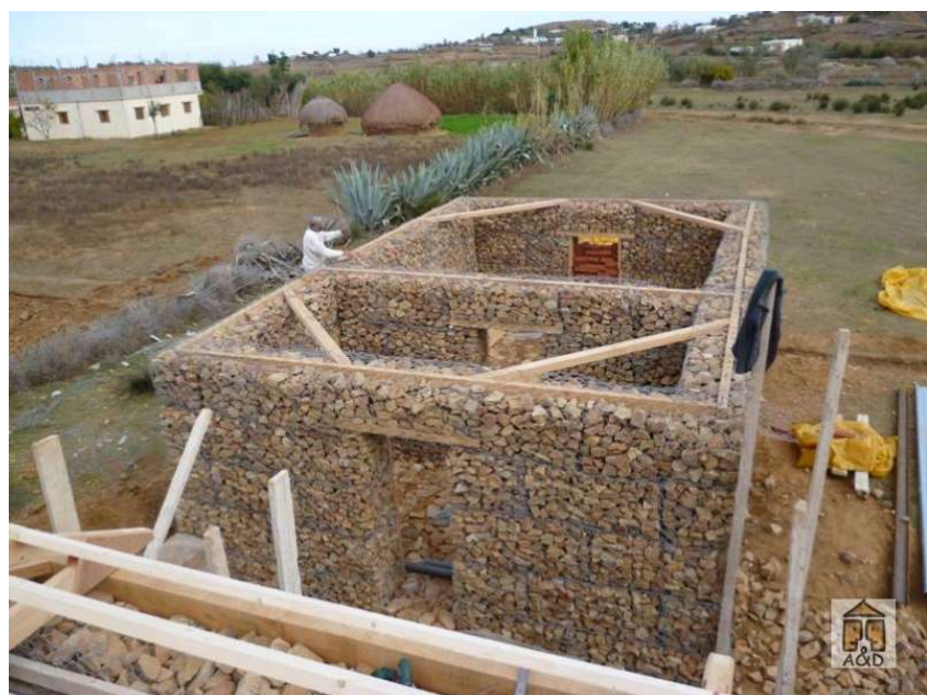
Fig. 55 : Murs achevés : préparation à la mise en place de la toiture, crédit Architecture&Développement.
