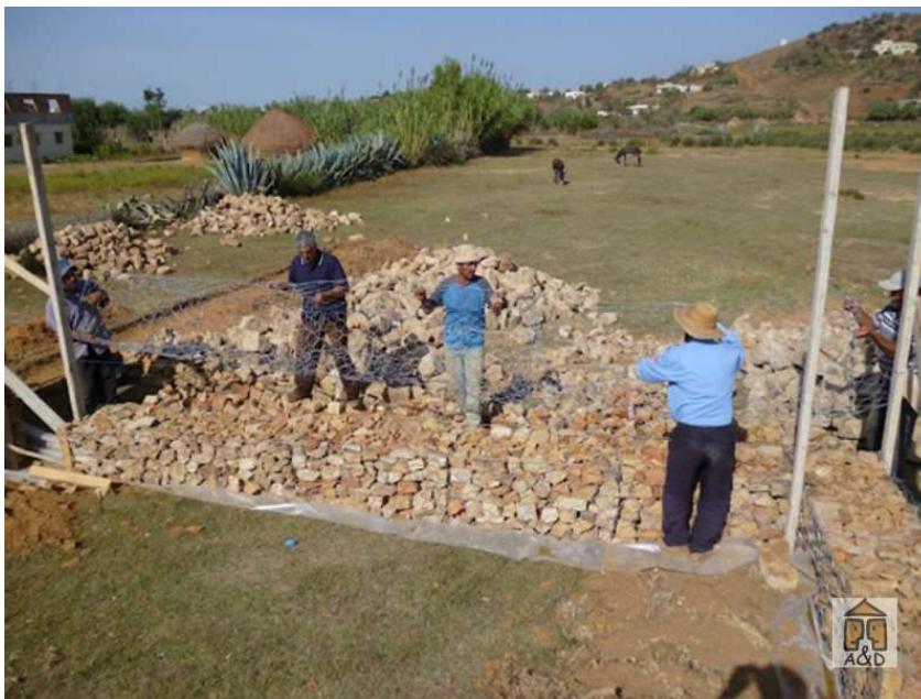
Fig. 54 : Mise en oeuvre des fondations, crédit Architecture&Développement.
