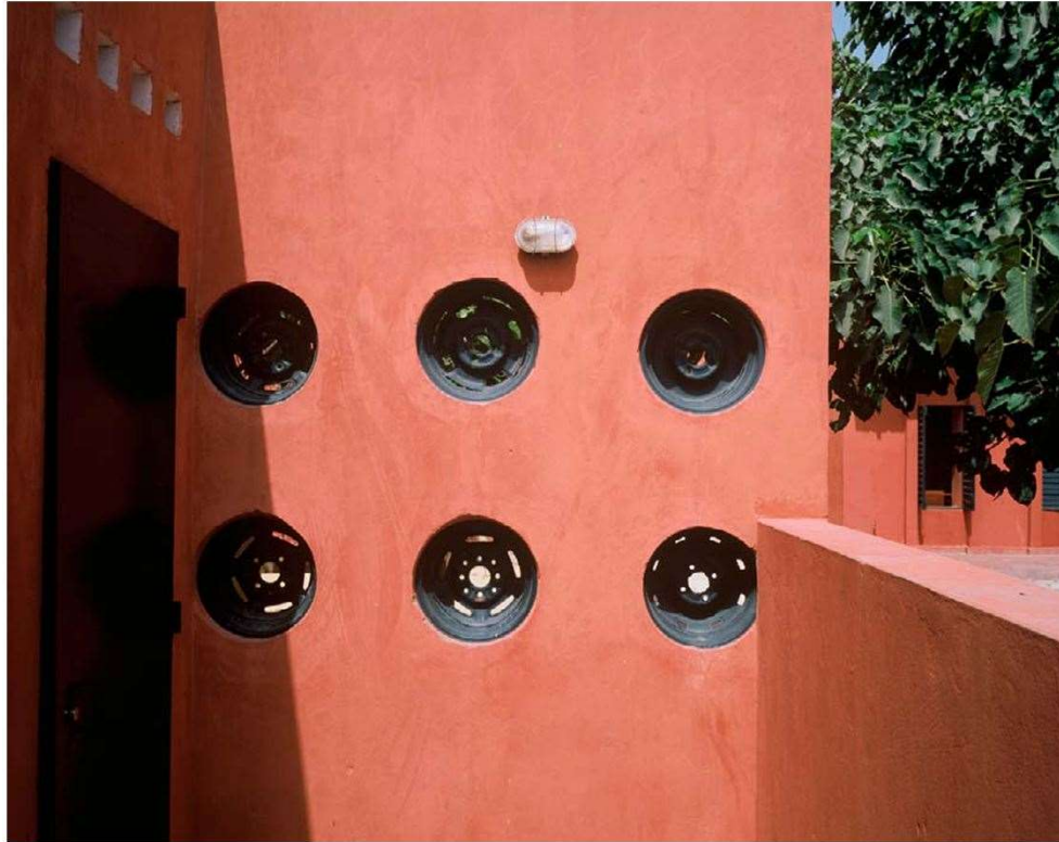
Fig. 10 : Jantes de roues d'automobiles réemployées comme bouches d'aération dans les toilettes, crédit Fernando Varanda.
