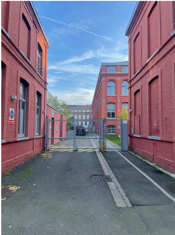
Fig. 39, Le CHRS Les Moulins de l'espoir vu depuis la rue Photographie réalisée par l'auteur
