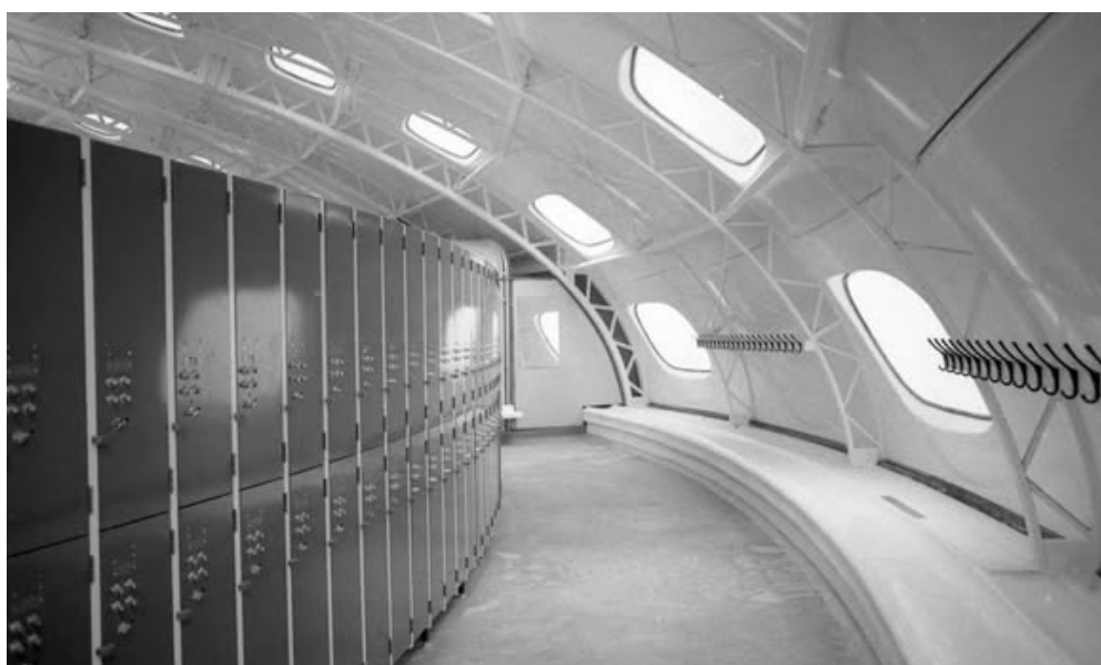
Fig 34 : Vue du vestiaire vers le bloc d'eau de la piscine Tournesol de Calais lors de son inauguration, 1975
