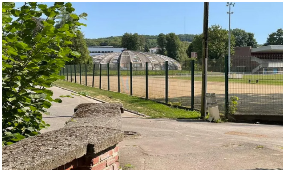
Fig 78 : Vue extérieure de la piscine Tournesol de Poix-en-Picardie
