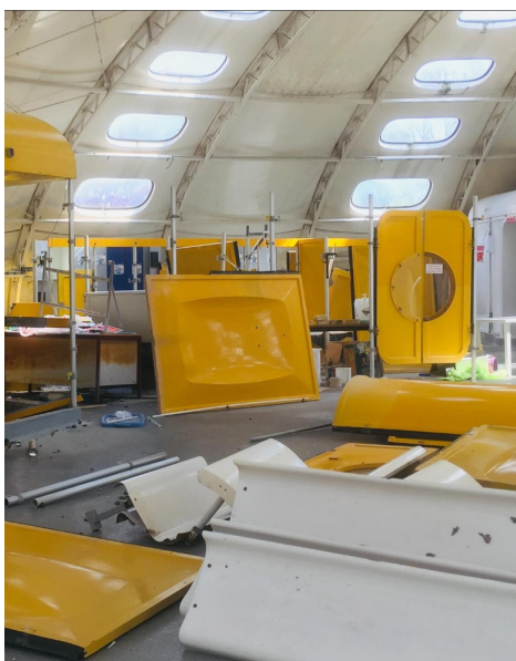
Fig 63 (gauche) : Démontage des cloisons intérieures d'une piscine tournesol
