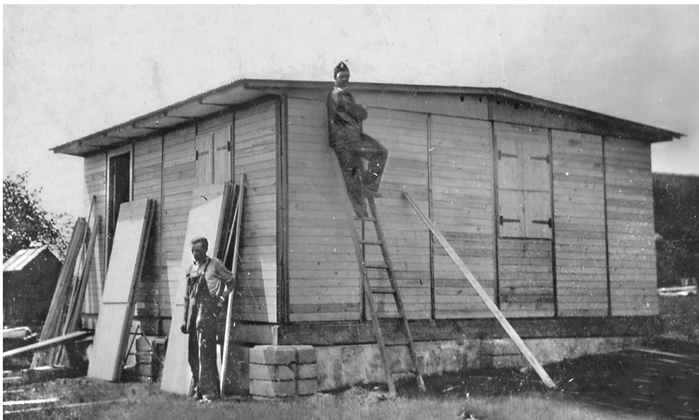
Fig 5 : Maison démontable 6x6, non localisée, 1945.
