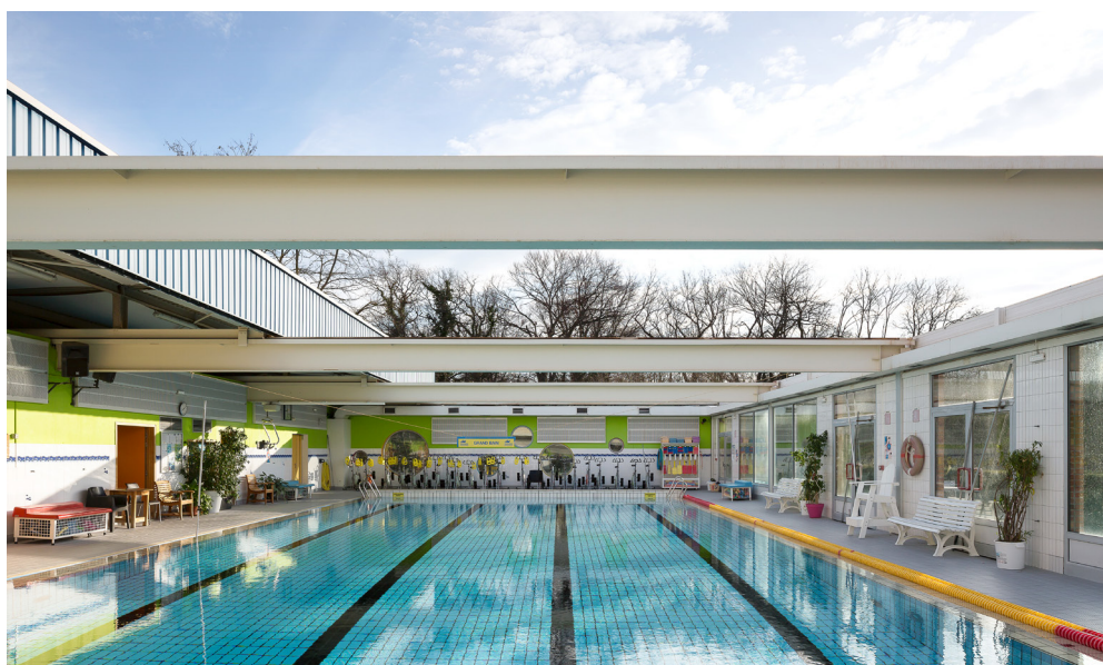
Fig 16 : Vue du bassin intérieur de la piscine Plein Soleil de Ostwald (67) avec la toiture ouverte
