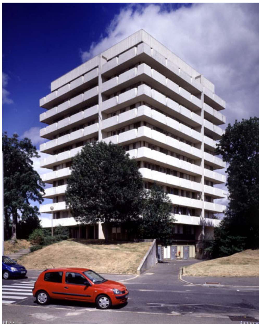
Fig 9 : Logements à plans adaptables de Montereau-Surville réalisé par l'agence d'architecture Xavier et Luc Arsène-Henry, 1969.
