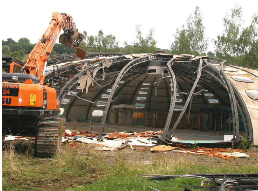
Fig 46 : Démolition de la Piscine Tournesol de Moyeuvre-Grande (Moselle) en 2012
