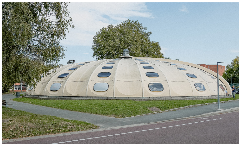
Fig 21 : Vue extérieure de la coupole de la piscine Tournesol de Lambersart, 2025
