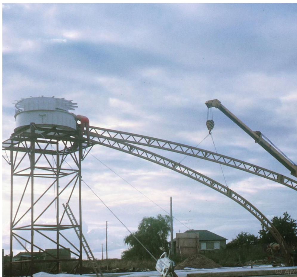
Fig 58 : Mise en place des arcs principaux reliés à la clé de voûte métallique, chantier de la piscine Tournesol de Blois, 1975.
