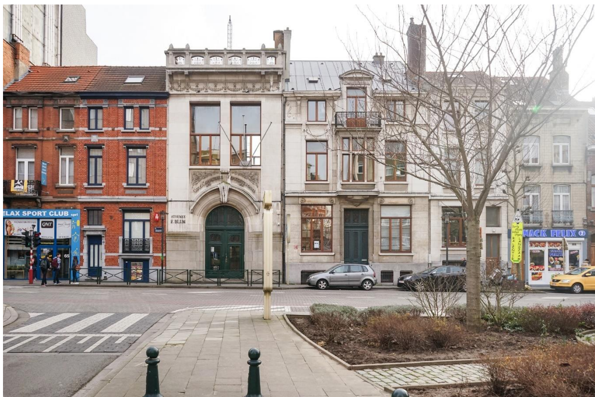
fig. 35 : Façade depuis la rue.
