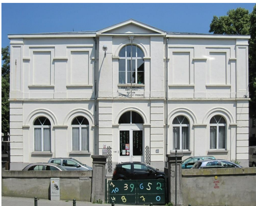
fig. 4 : exemple d'école communale toujours utilisée aujourd'hui : ancienne école communale n°2, aujourd'hui connue sous le nom de Groupe Scolaire Sans Souci. Elle a été conçue en 1870, à Ixelles.
