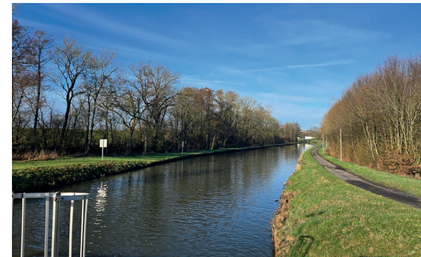
Fig. 19. Photographie du canal de la Sambre à l'Oise, en mars 2026
