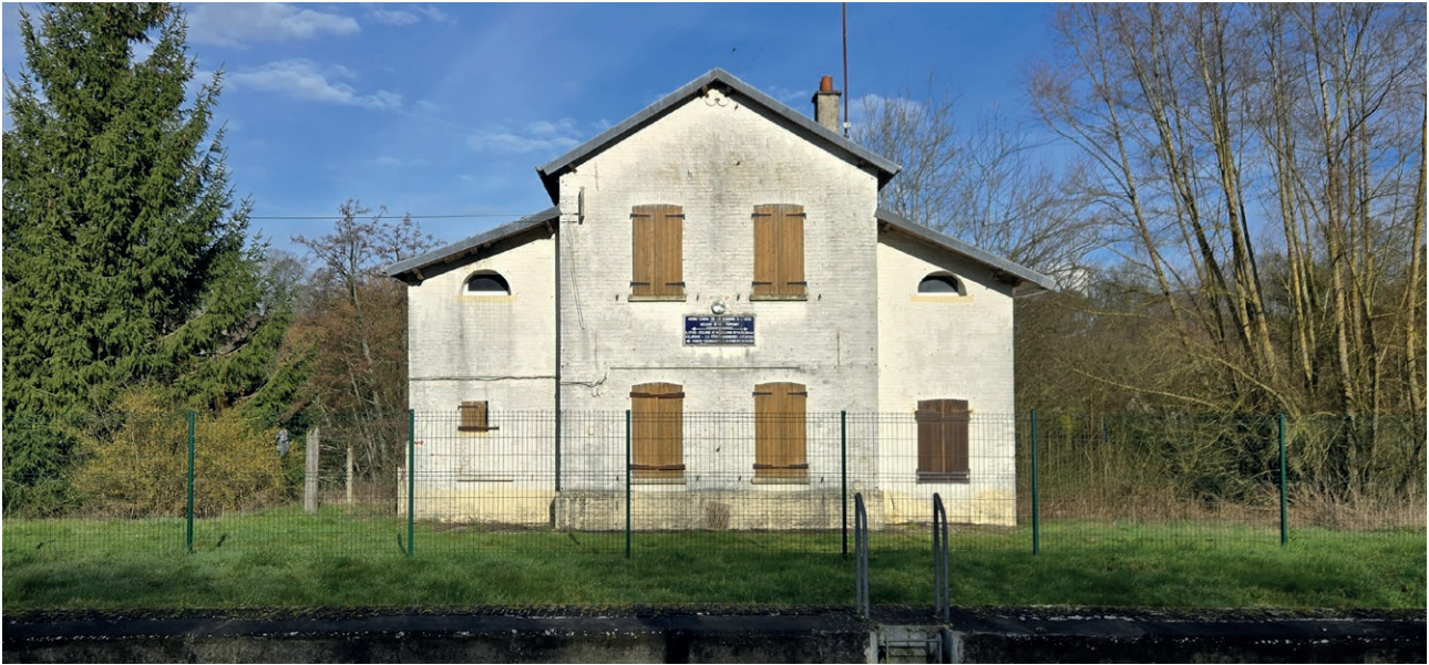
Fig. 61. Maison éclusière n°15
