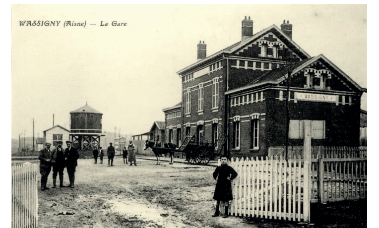
Fig. 14. Ancienne carte postale de la gare de Wassigny, auteur inconnu, avant 1914
