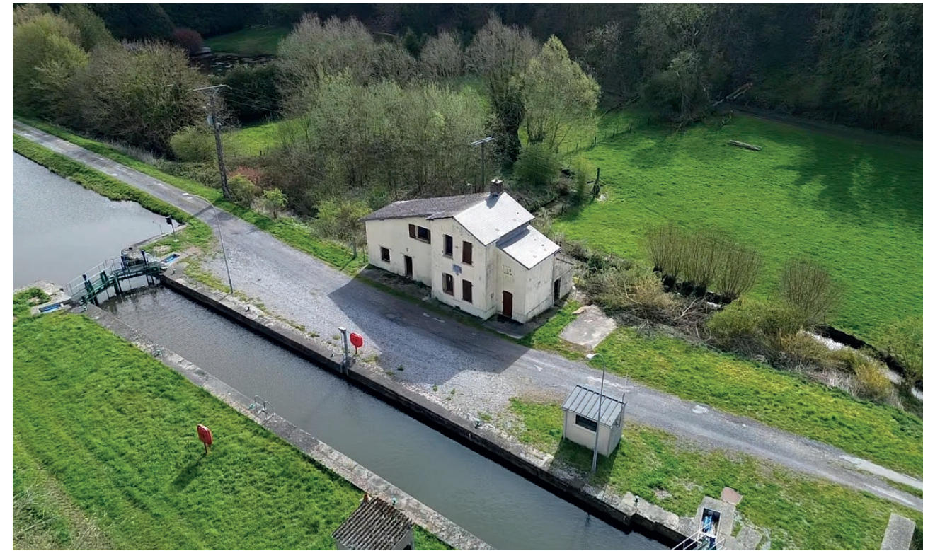
Fig. 82. Vue aérienne de la maison n°16
