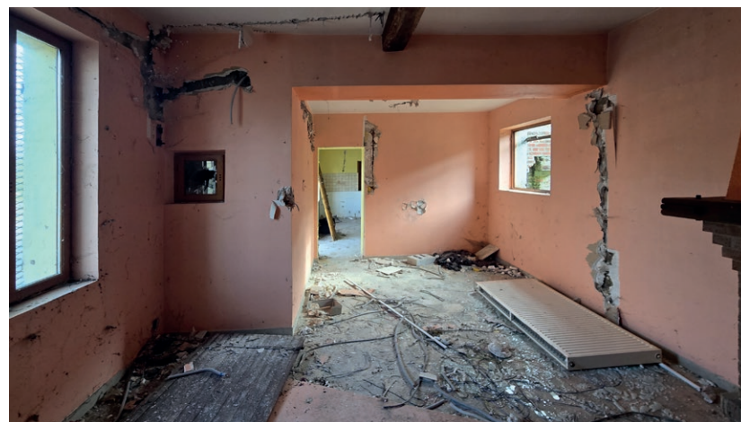
Fig. 56. Intérieur de la maison n°16
