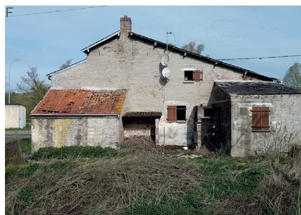
Fig. 90. Photo de l'existant, arrière de la maison n°16
