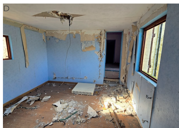
Fig. 87. Photo de l'existant, chambre de la maison n°16
