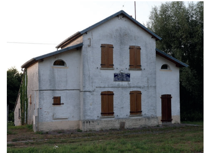
Fig. 12. Maison éclusière n°15 à Tupigny
