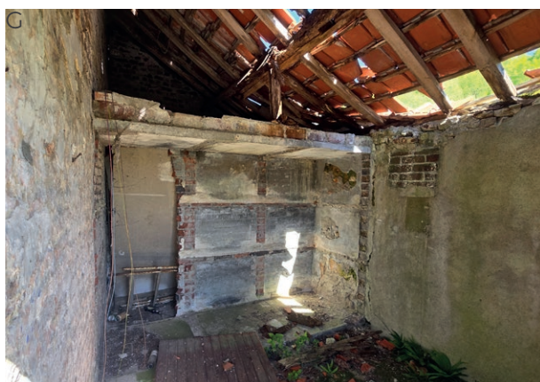
Fig. 91. Photo de l'existant, clapier de la maison n°16
