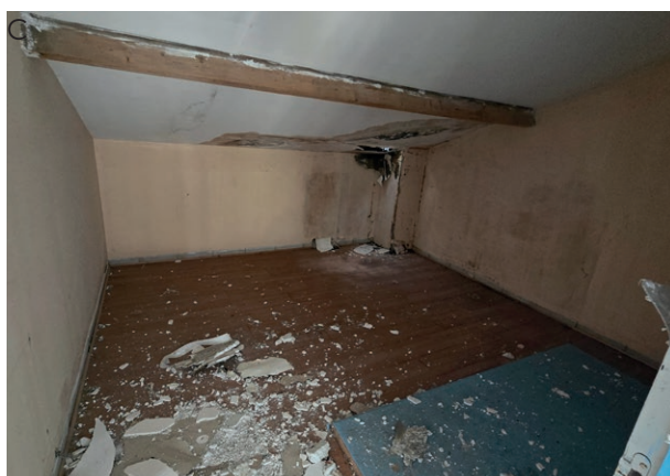
Fig. 86. Photo de l'existant, pièce à l'étage de la maison n°16
