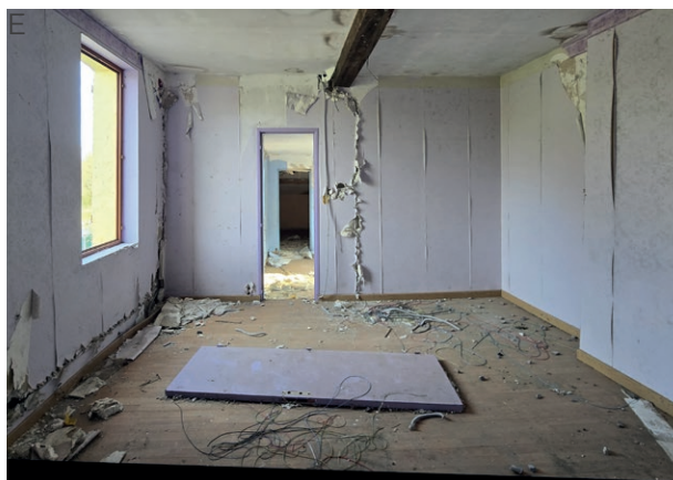
Fig. 89. Photo de l'existant, chambre de la maison n°16
