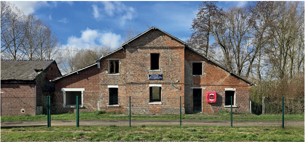
Fig. 73. Maison éclusière n°24
