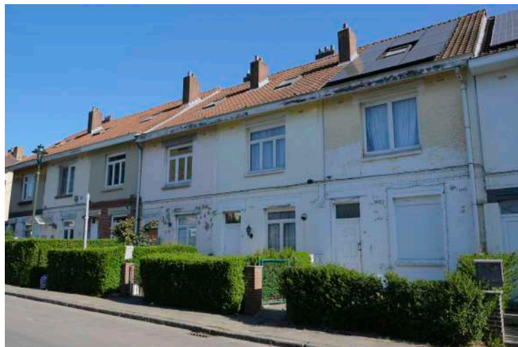
Figure 50 : Photographie de façades modifiées à La Roue.
