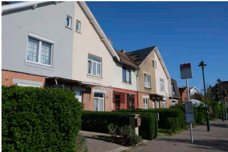
Figure 51 : Photographie de façades dégradées à La Roue.
