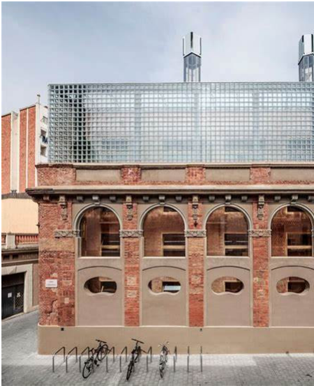
Figure 47 Planell Civic Center à Barcelone, sur le site d'une ancienne cristallerie. Projet par H Arquitectes.
