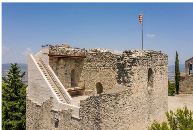
Figure 38 Vue extérieure du Castell de la Tossa (Moià, Espagne) après restauration.
