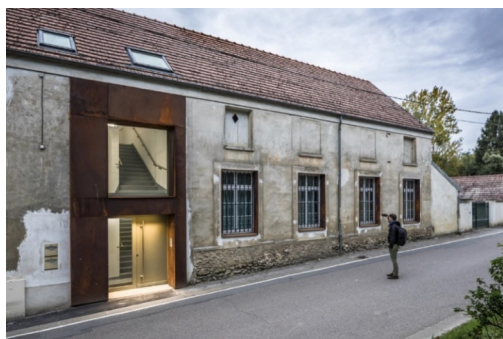
Figure 35 Façade conservée de l'ancienne école d'Essômes-sur-Marne reconverte en logements, France, 2017.
