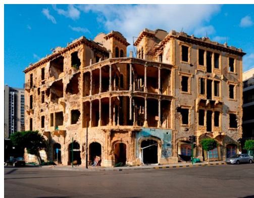
Figure 34 Façade conservée de Beit Beirut, ancien immeuble Barakat, Beyrouth.
