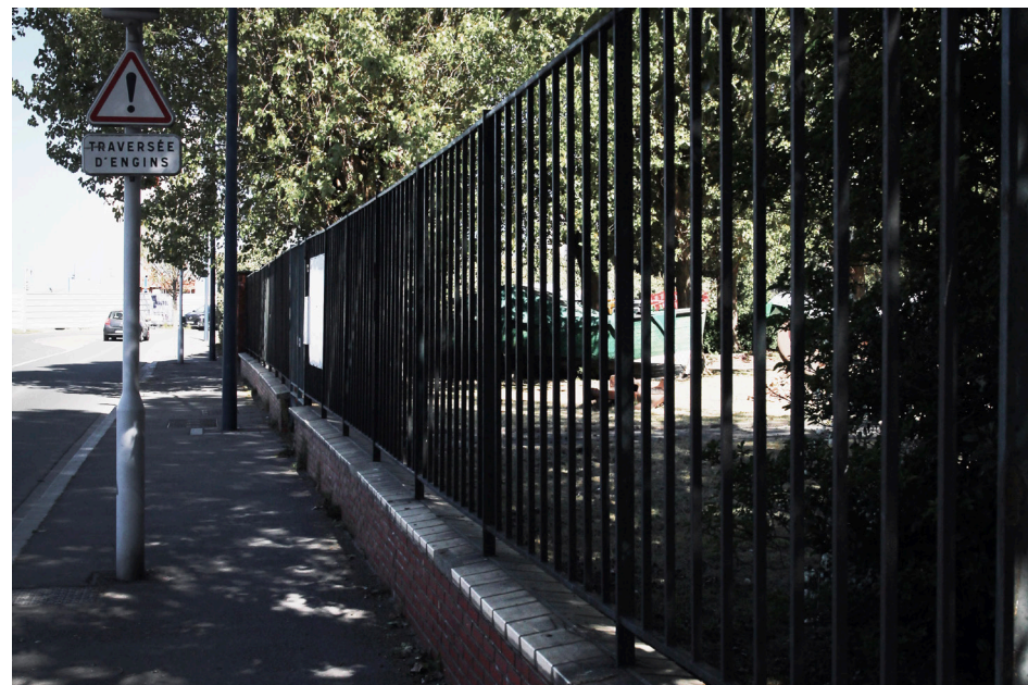
FIG 139. PHOTO VUE 2 – LIMITE DU SITE AVEC MUR EN BRIQUE ET BARREAUX METALLIQUES– 2026 © AUTEUR.
