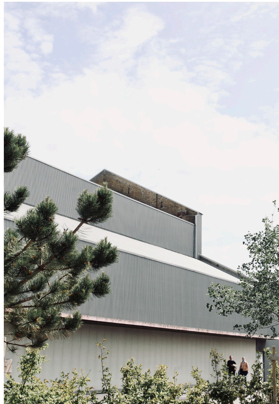
FIG 58. PHOTO DÉTAIL DE LA JONCTION ENTRE LES ÉLÉMENTS DE LA SALLE DES SPORTS DU GRAND LARGE – 2026 ©AUTEUR.
