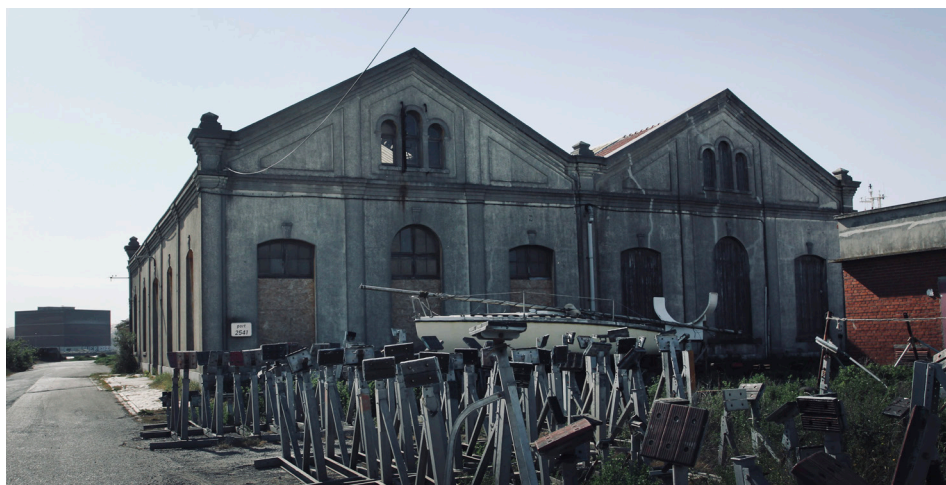
FIG 42. HANGAR PORTUAIRE– 2026 © AUTEUR.
