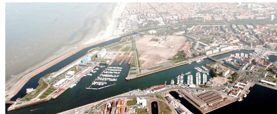
FIG 106. DE LA FRICHE AU QUARTIER MIXTE – AVANT – SITE SUITE AUX DESTRUCTIONS DES CHANTIERS DE FRANCE © ANMA.
