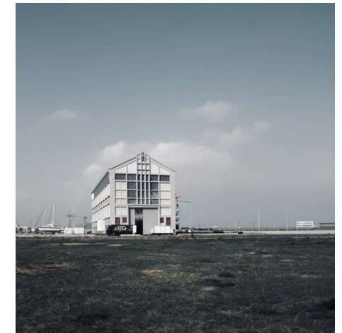
FIG 68. HALLE AP2 EXISTANTE - 2009 © LACATON & VASSAL.
