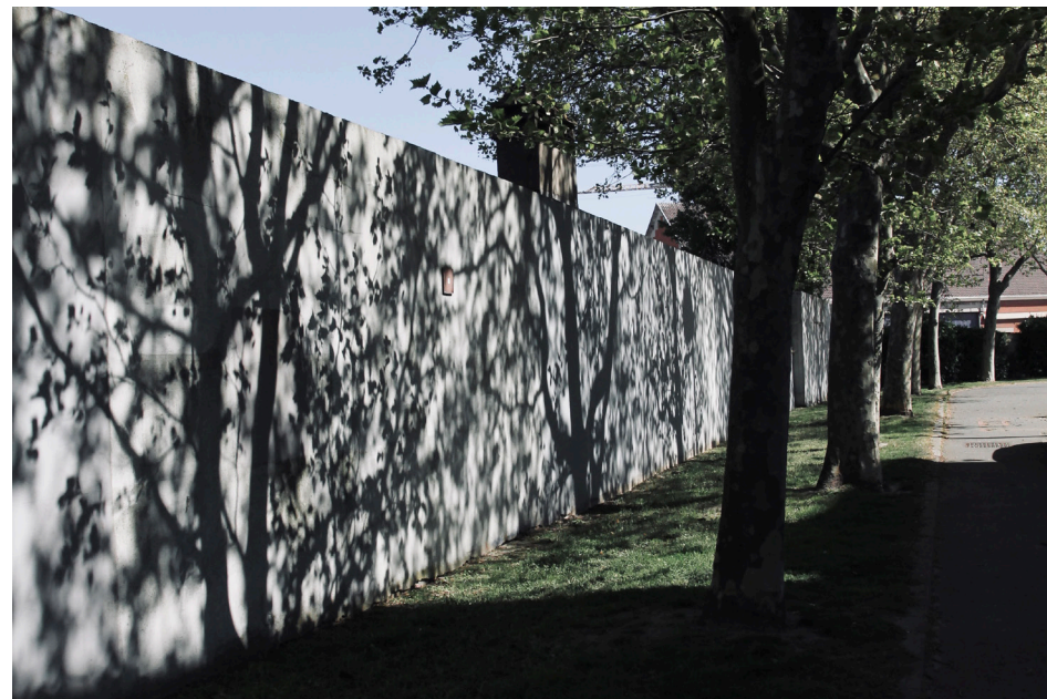
FIG 138. PHOTO VUE 1 – LIMITE DU SITE AVEC MUR EN BÉTON– 2026 © AUTEUR.
