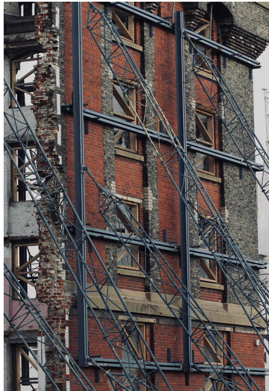
FIG 34. PHOTO DE LA RÉHABILITATION DE LA HALLE AUX SUCRES - 2012 ©S.MISEROLE.
