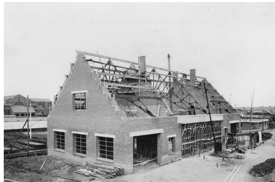
FIG 94. PHOTO DE L'ATELIER EN CONSTRUCTION – DOSSIER DU PORT DE DUNKERQUE – ARCHIVES DE DUNKERQUE.
