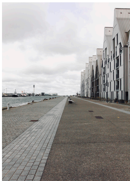
FIG 153. PHOTO DU QUAI DE LA CUNETTE – 2026 ©AUTEUR.
