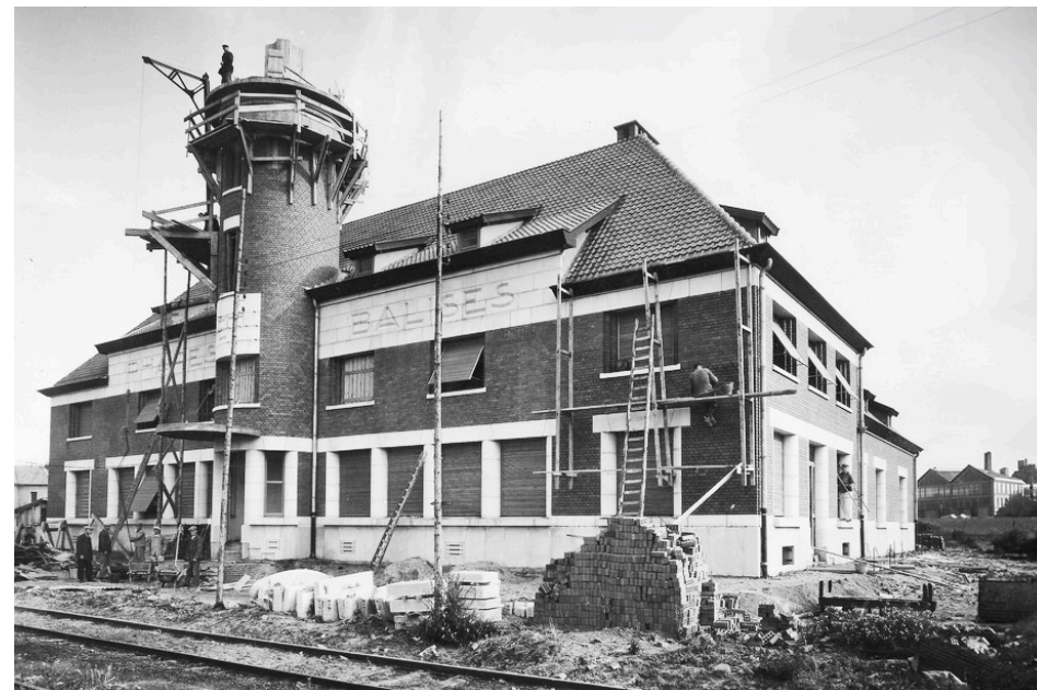
FIG 93. PHOTO DU BÂTIMENT PRINCIPAL EN CONSTRUCTION – DOSSIER DU PORT DE DUNKERQUE – ARCHIVES DE DUNKERQUE.
