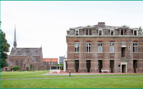
photo montrant le campus psychiatrique de Melle et l'ancienne bâtisse qui accueille le projet. photo prise sur le site architectmagazine.com le 5 juin 2025.
