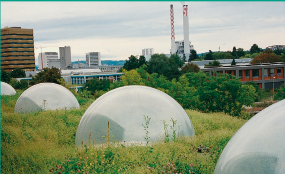
Photo des dispositifs de lumière zénithale des chambres, prise sur le site herzogdemeuron.com le 26 août 2025.
