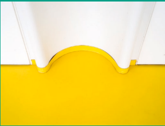
Photo montrant les courbures que l'on peut observer dans les murs du sanatorium, prise par Benjamin Gilbert et empruntée sur le site wellcomecollection.com le 26 août 2025.
