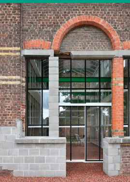
2 Photo montrant les interventions en béton sur la façade, prise sur le site jotail-lieu.com le 6 juin.
