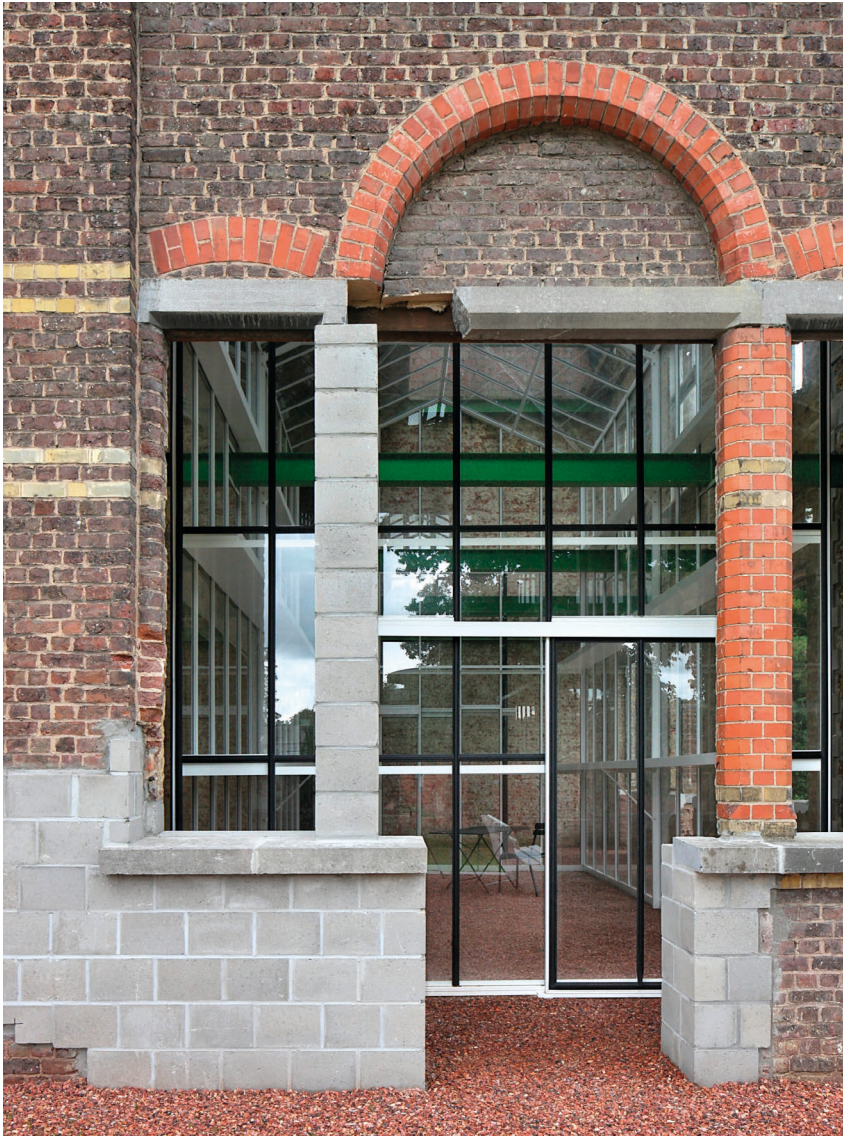
Photo de la façade du Projet PC Caritas, de Vylder Vinck Tailleu à Melle. Les matériaux utilisés pour les interventions se démarquent de la brique de l'ancien pavillon en ruine. Ce décalage de matérialité permet de lire ce qui est ancien et ce qui est nouveau, de manière à mettre en valeur l'histoire du bâtiment, ses vulnérabilités et les réparations nécessaires pour le maintenir. Photo empruntée sur le site jotailleu.com le 12 mai 2026.
