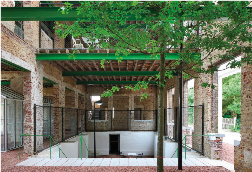
Photo de la couleur du Projet PC Caritas, on remarque que la couleur verte des poutres acier de la consolidation se fonde dans les couleurs de la végétation dans et hors du projet. Photo de Filip Dujardin, empruntée sur le site jotailleu.com le 12 mai 2026.
