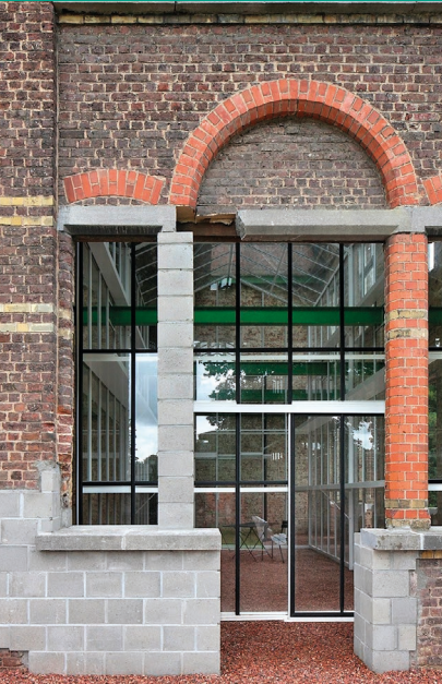
Photo montrant les interventions en béton sur la façade, prise sur le site jotaillieu.com le 6 juin.
