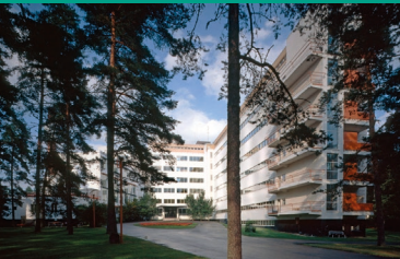
1 : Photo montrant l'arrivée devant le sanatorium, empruntée sur le site architecture-history.org le 26 août 2025.
