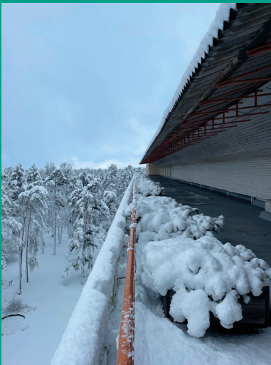
Photo personnelle montrant la vue sur la terrasse du solarium.
