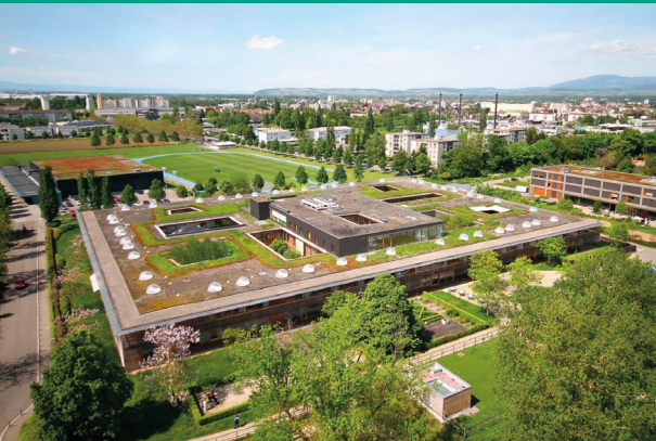
Photo montrant le site dans leuel s'insère rehab et les vues que peuvent avoir les chambres selon leur orientation, prise sur le site rehab.ch le 28 août 2025.
