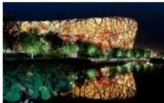
Figure 33 : stade National de Pékin - façade
