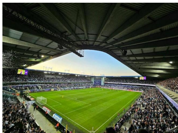
Figure 47 : vue des gradins
