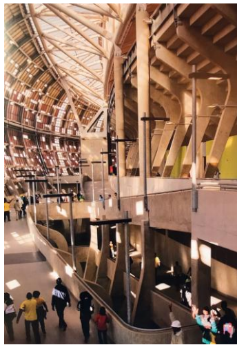
Figure 38 : galerie du Soccer City - espaces de circulation intérieure
