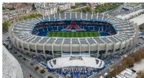
Figure 35 : Parc des Princes : façade avec structure en béton armé apparente
