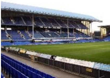
Figure 26 : Goodison Park – tribune en structure de poteau à poteau
