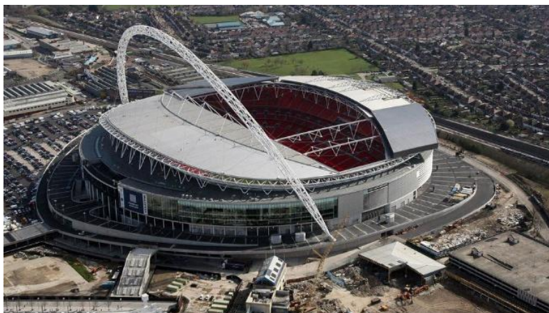
Figure 22 : Wembley Stadium – forme de cercle
