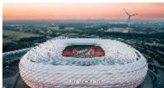
Figure 34 : l'Allianz Arena - façades de coussins d'air
