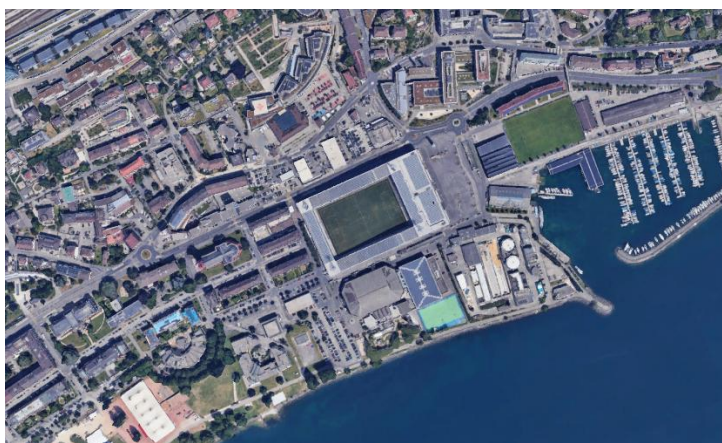
Figure 14 : vue aérienne du stade de la Maladière
