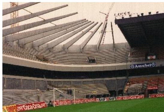
Figure 49 : phase de construction
