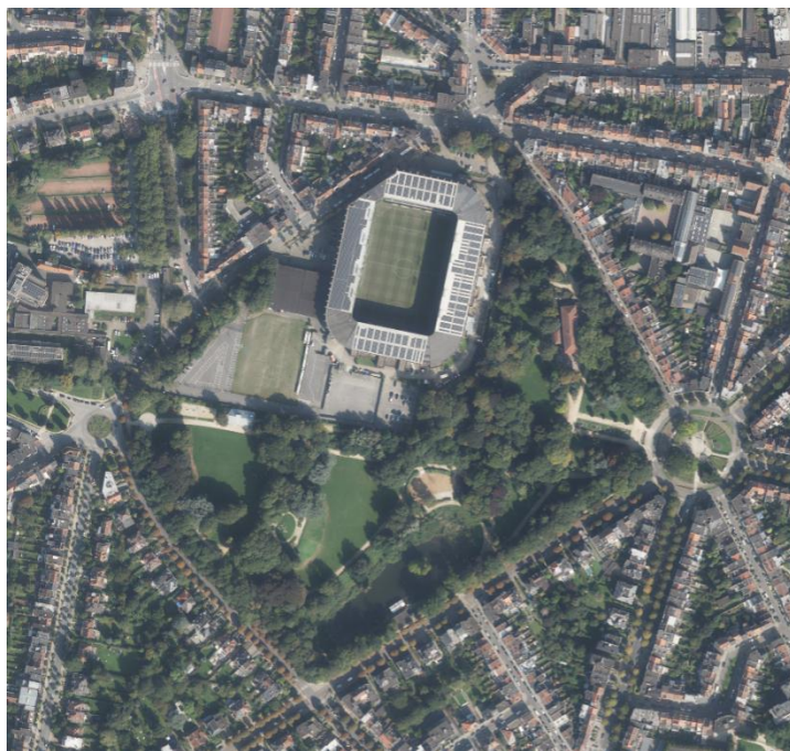
Figure 51 : vue aérienne - implantation
