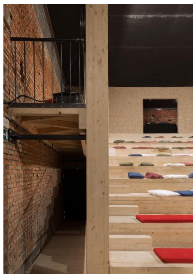
Figure 51 : La jonction entre le nouveau et l'existant © Karbon
