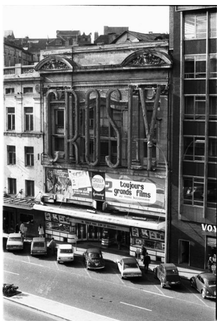
Fig. 24 : Façade du Crosly à Liège en 1936.
