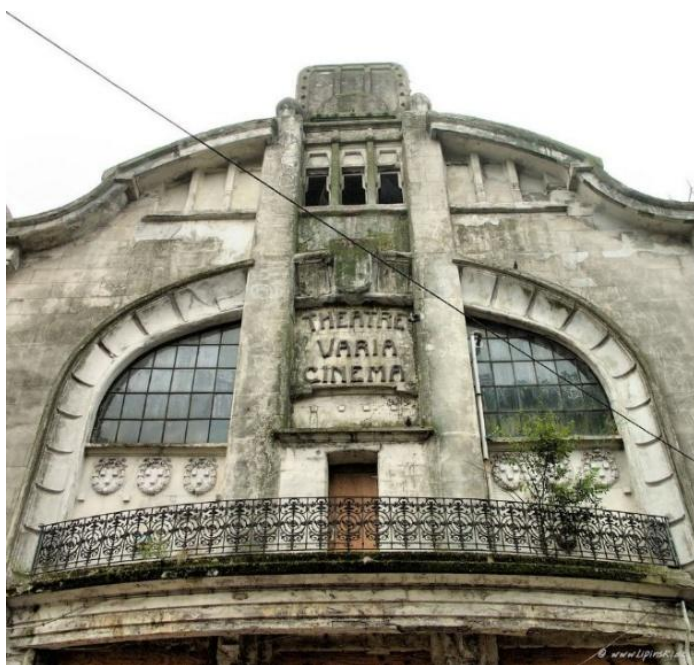
Fig. 71 : La façade aux étages © Skope
