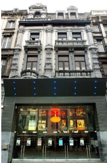
Fig. 21 : La Façade du Palace à Liège en 2017
