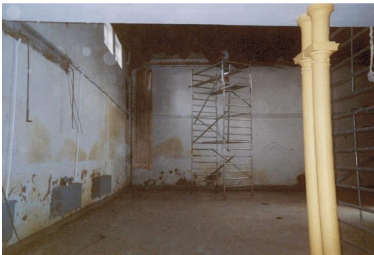
Fig.10 : La salle avant les travaux avant 2003.
