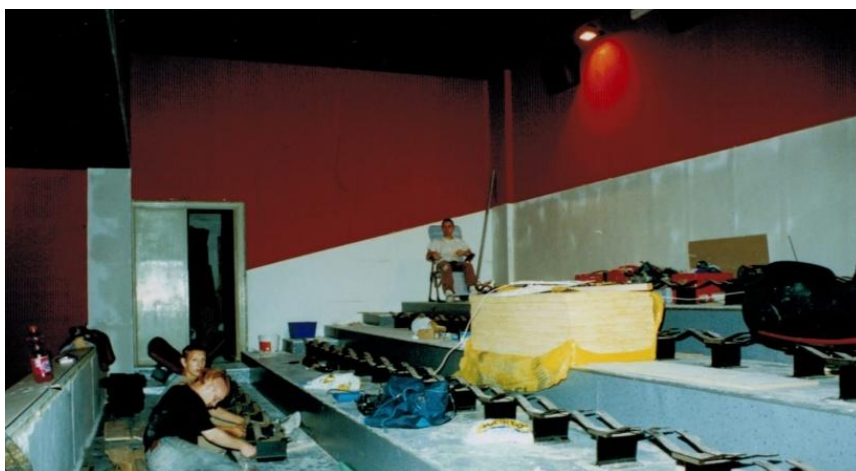
Fig. 13 : Aménagement du balcon en juillet 2004.
