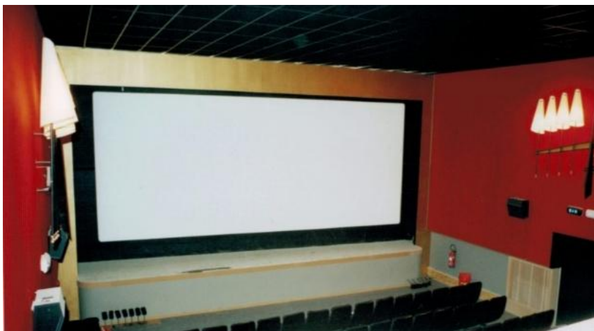
Fig. 12 : Après 6 mois de travaux : le cinéma l'étoile ouvrira sous ce look le 19/12/2003.
