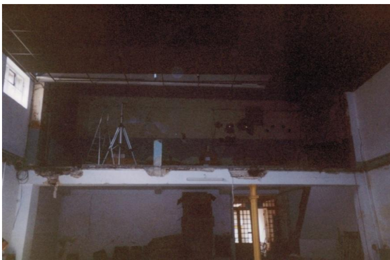
Fig.11 : Les travaux débutent par l'installation d'un faux-plafond en dalles noires 120/60 cm.
