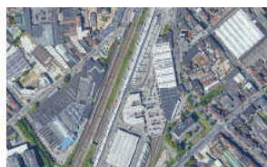
Gare de l'Ouest 3 700 m 2
