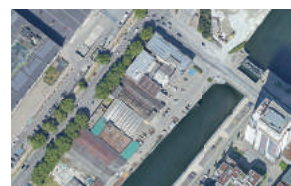
Port de Bruxelles - Bruxelles 9 000 m 2
