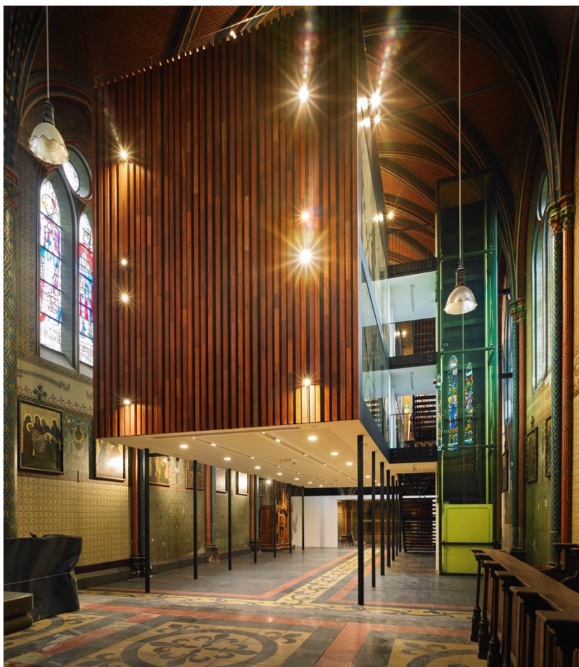
Figure 31 – Principe « box in the box » dans la transformation de la Schoolkapel Broe-der-school – PARCUM
