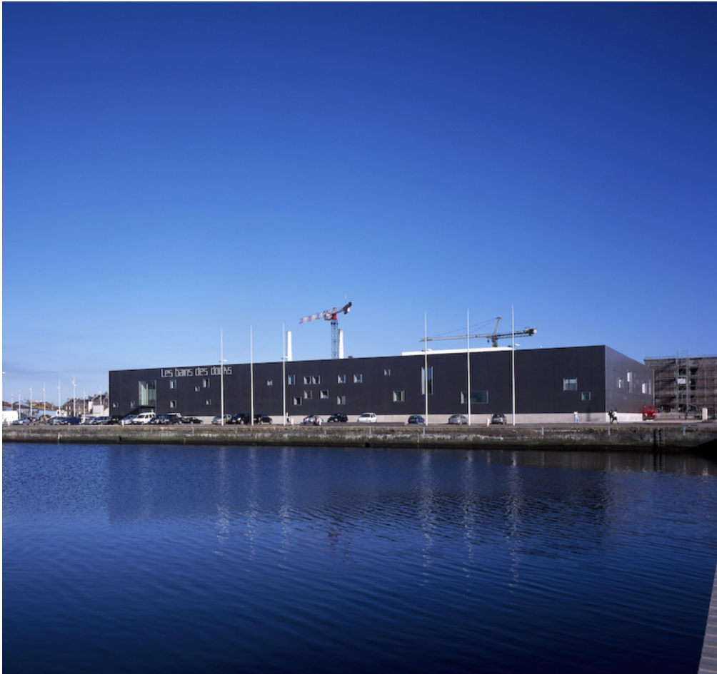
Façade de la piscine «Les bains des Docks» Ateliers Jean Nouvel
