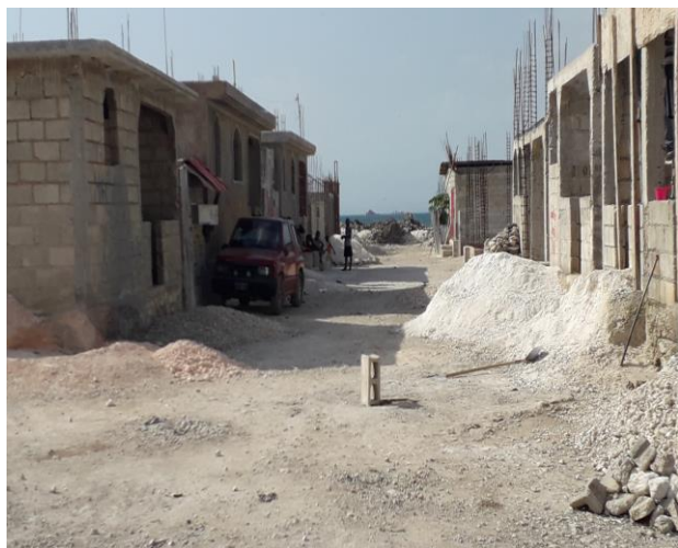
Photos 5: Maisons en construction au bord de mer de Cité Michel
