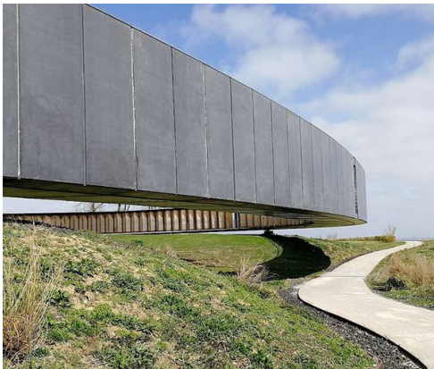
Figure 30 : Zoom sur la façade, voussoirs préfabriqués.
