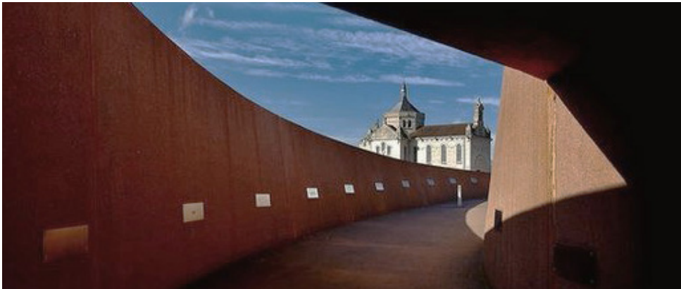
Figure 32 : Les deux murs courbes en béton coloré.
