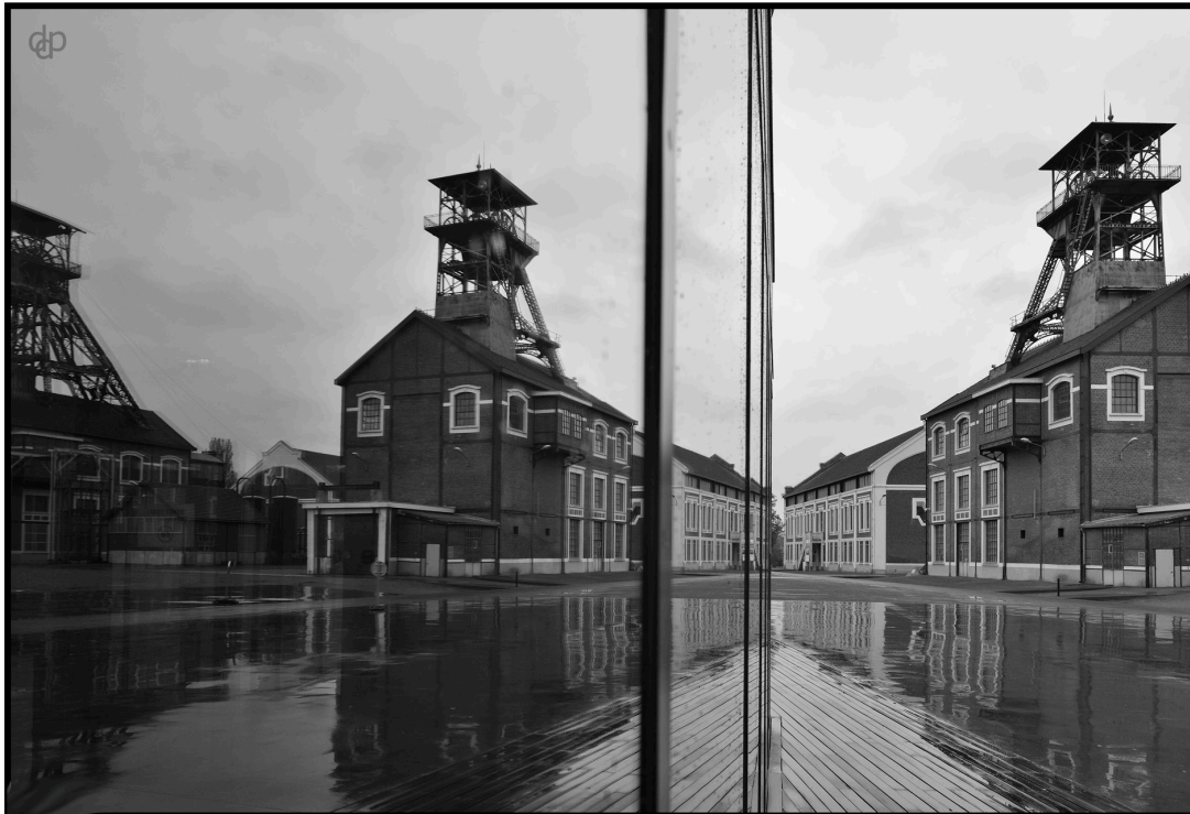
Figure 1 : Photographie sur le carreau du 9-9 bis.
