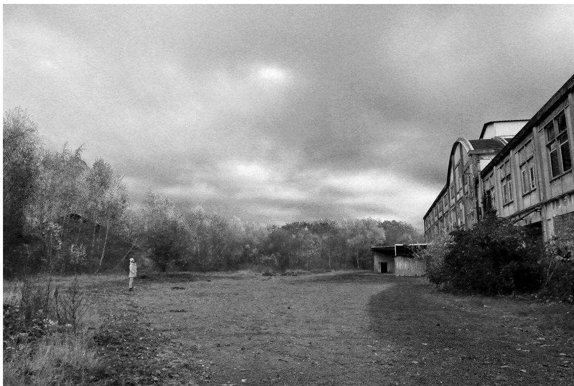
Figure 70 : Photographie de la salle des machines face à sa forêt. On aperçoit le terril 87 en arrière-plan.
