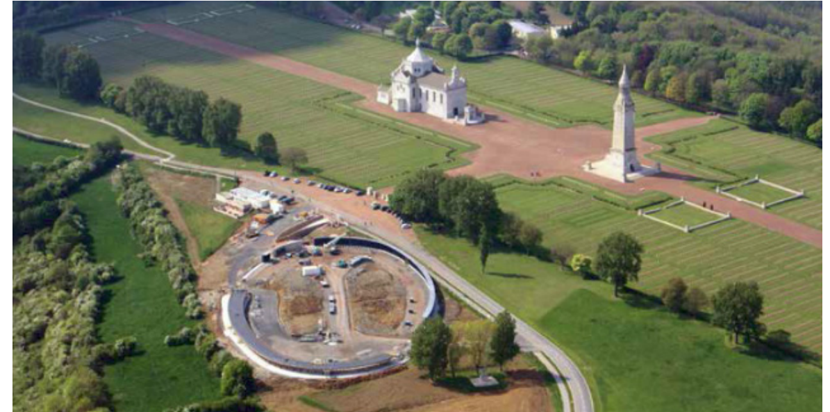
Figure 93 : L'Anneau de la Mémoire en phase de construction.
