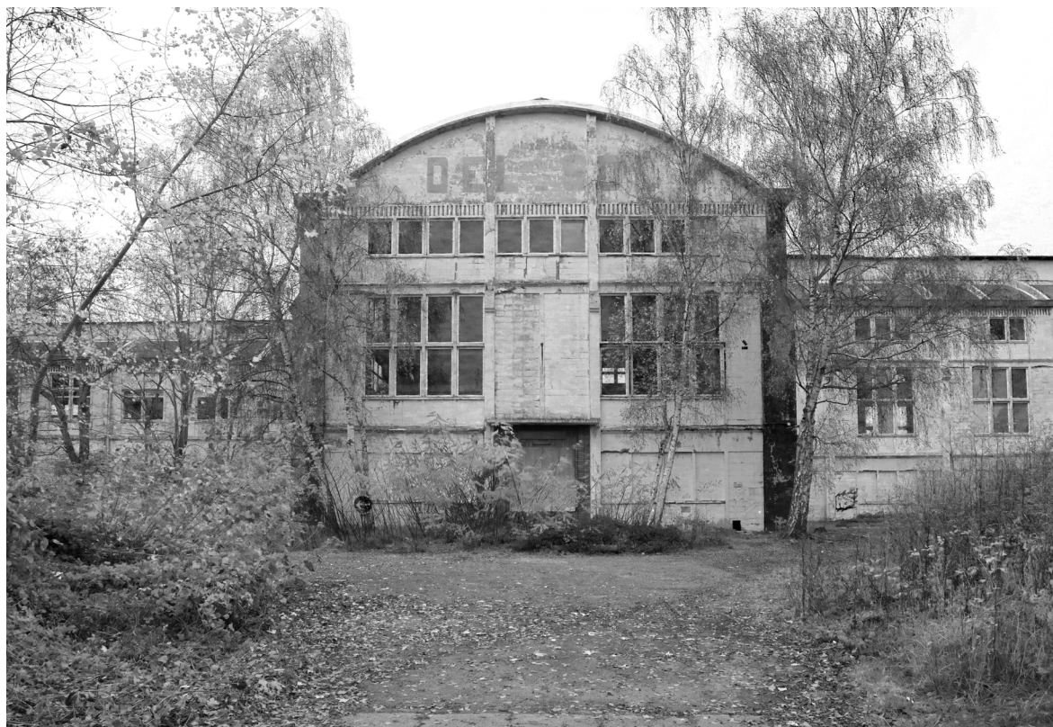
Figure 71 : Photographie de l'entrée de la salle des machines. Une plaque commémorative à la mémoire des mineurs ayant combattu durant la première guerre mondiale s'installe sur sa façade.
