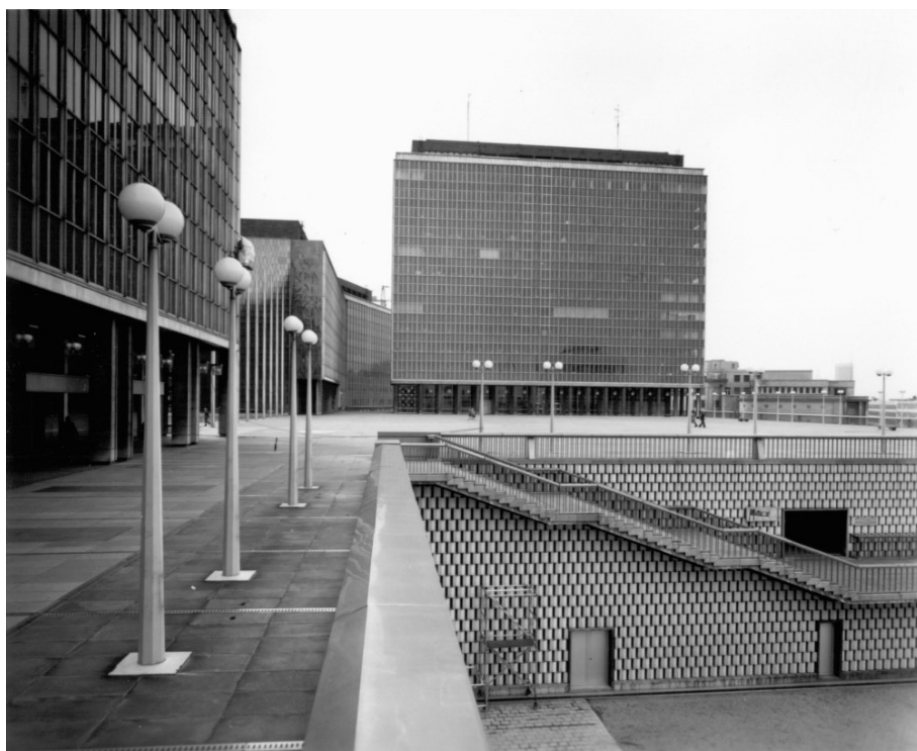
L'esplanade et le bâtiment G (au fond) et la rue de Rivoli (à gauche)
