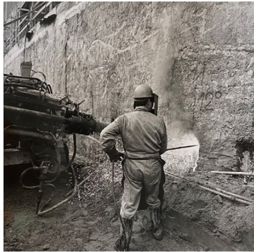
Préparation du placement des tirants d'un mur emboué (ministère des travaux public, 1973) (Source : Archives Générales du Royaume)
