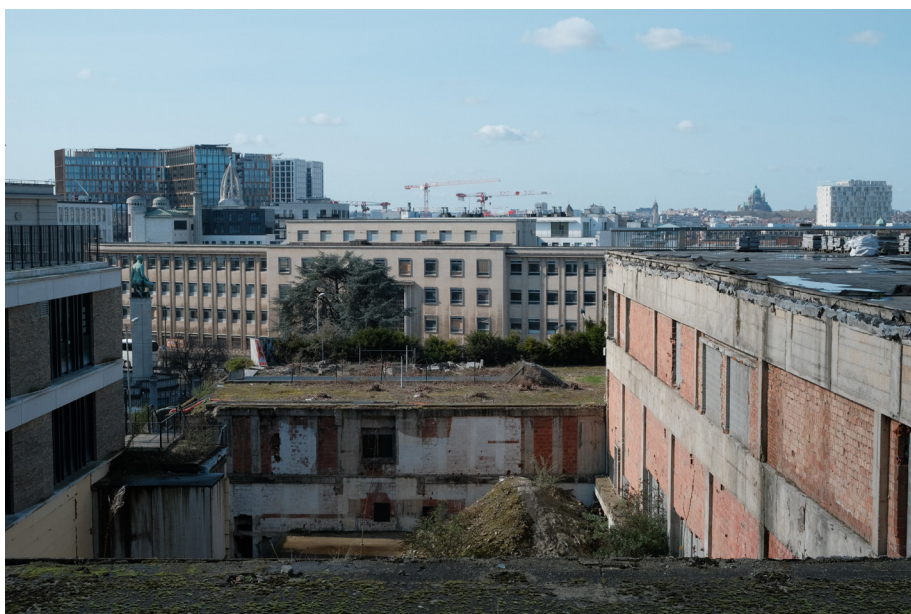
Photo du trou créé par la démolition du bâtiment (prise par l'auteur)
