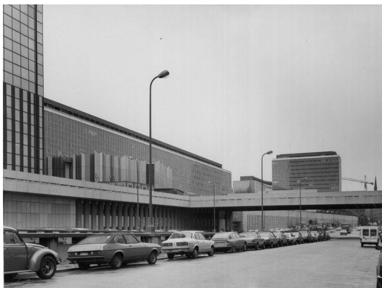
Passerelle suspendue au-dessus du Boulevard Pacheco (1980) (Source : Brugis)
