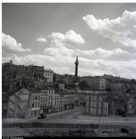
Quartier du Marais durant les travaux de la jonction Nord-Midi (auteur inconnu, circa 1950)
