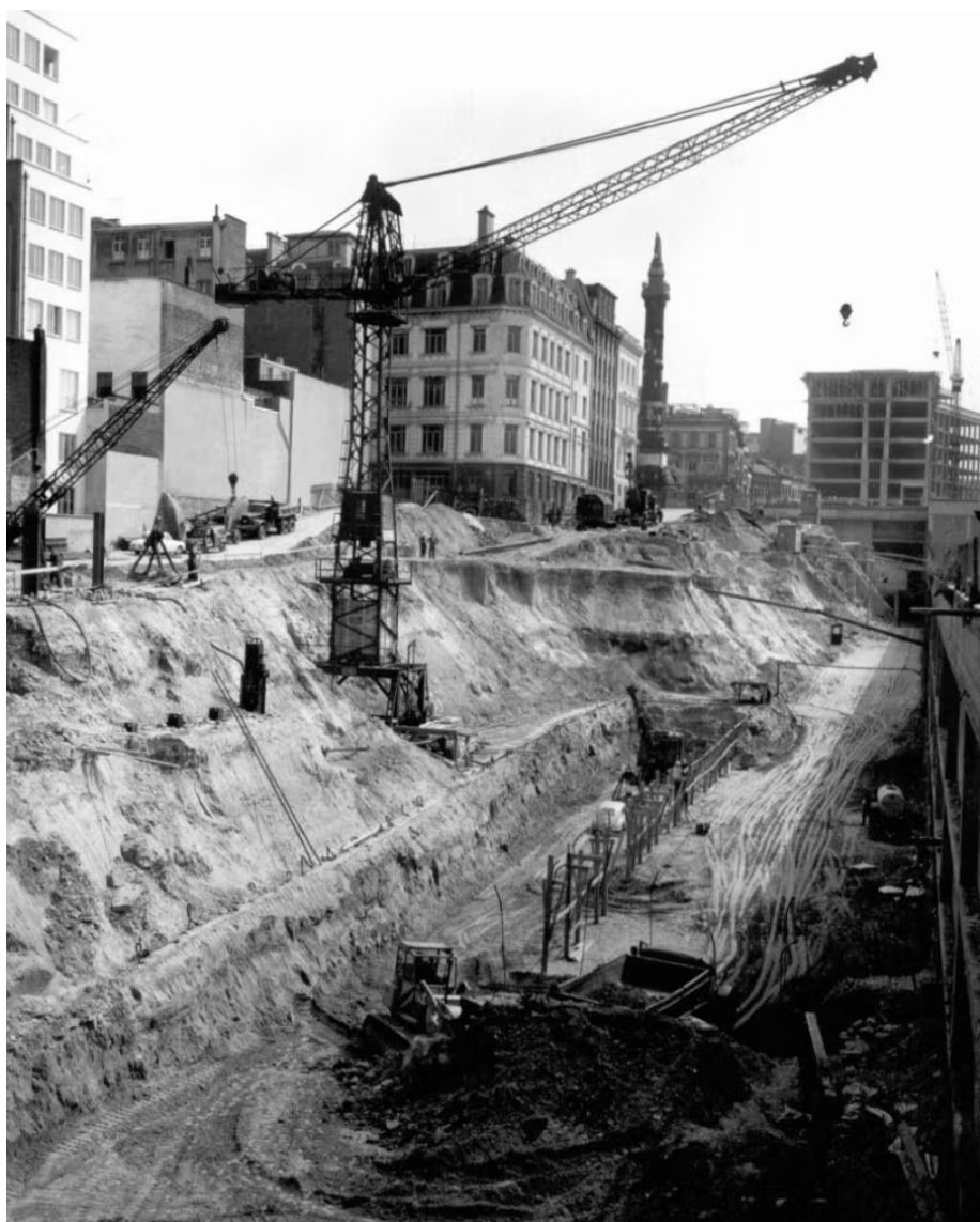
Chantier de la Cité Administrative de l'État (auteur et date inconnue)
