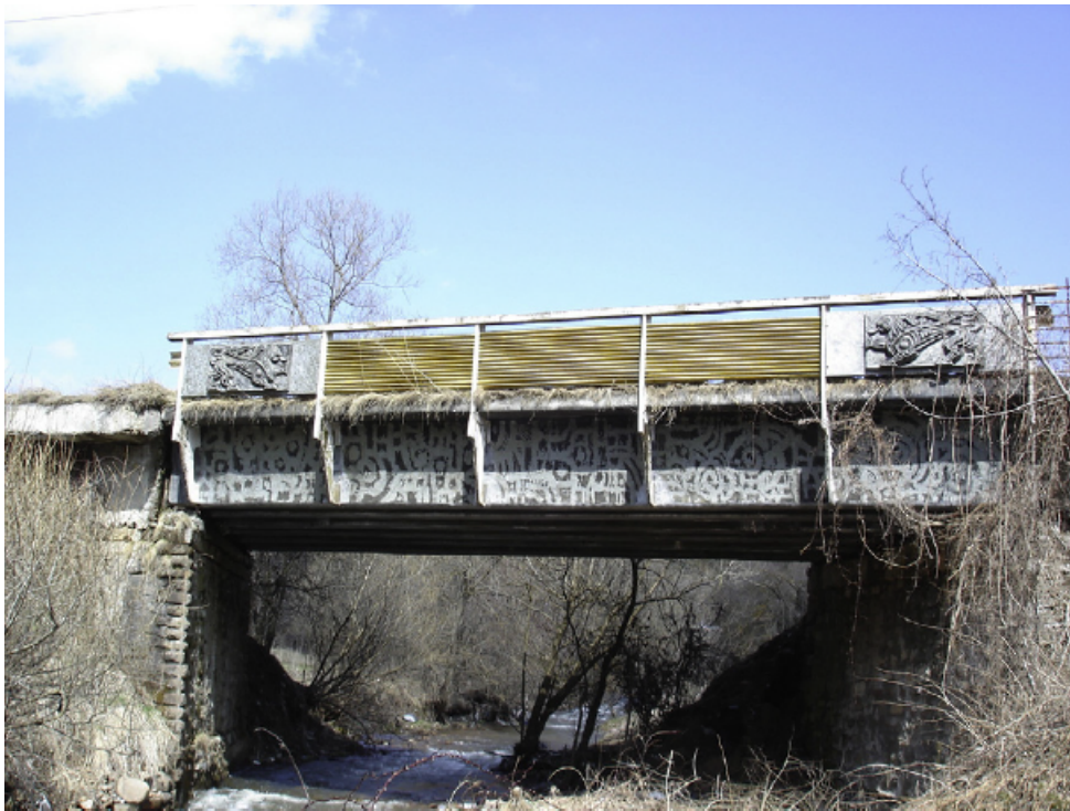
FIGURE 2.8 – Pont de Ginzi, Bulgarie : un des premiers ponts entièrement en composite[27]
