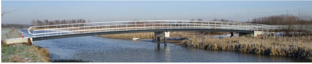
FIGURE 2.22 – Passerelle de Grote Wetering
