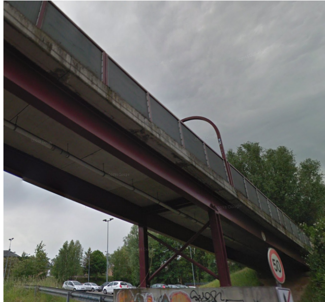
FIGURE 4.4 – Passerelle reliant la gare des bus de Louvain-la-Neuve au quartier du Biéreau
