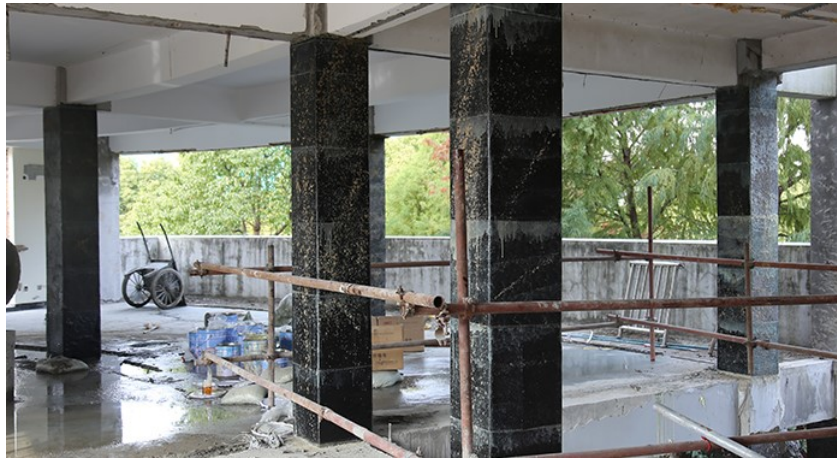
FIGURE 2.5 – Colonnes renforcées à l’aide de fibres de carbone
