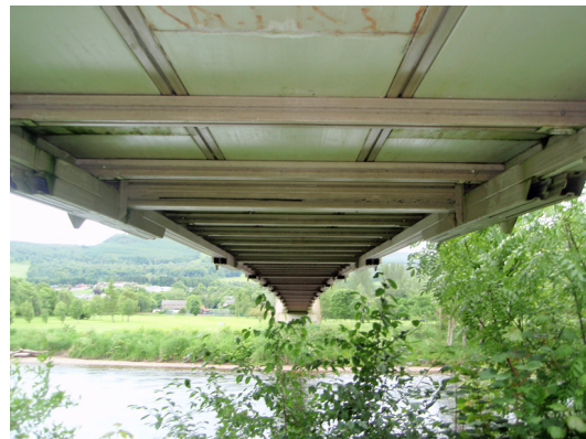
(b) Dessous du tablier[30]
