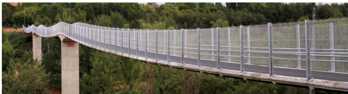
FIGURE 2.20 – Passerelle de Cuenca
