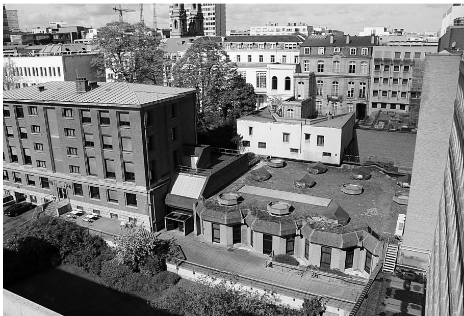
Fig.33 Vue sur l'intérieur d'ilot
