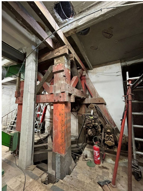
Figure 38 photographie du système de rigidification, 7 juillet 2026 © Büsra Jouant
