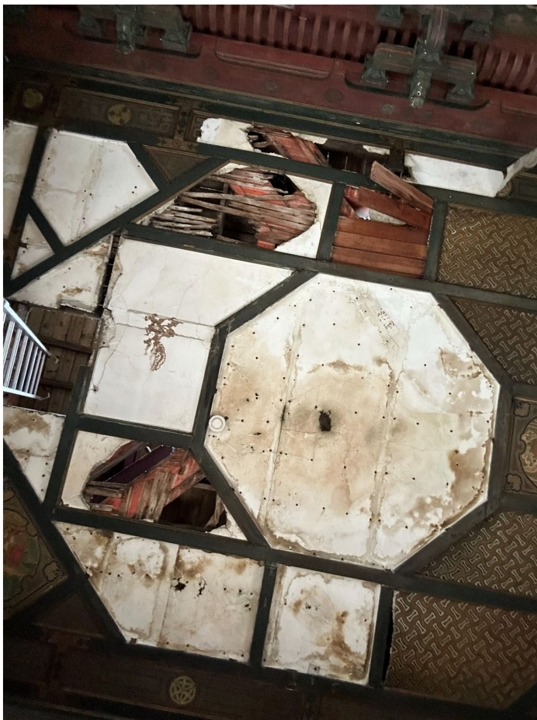
Figure 75 photographie du plafond du cinquième étage, laissant apparaître certaines parties de la charpente, 16 avril 2024, ©Büsra Jouant
