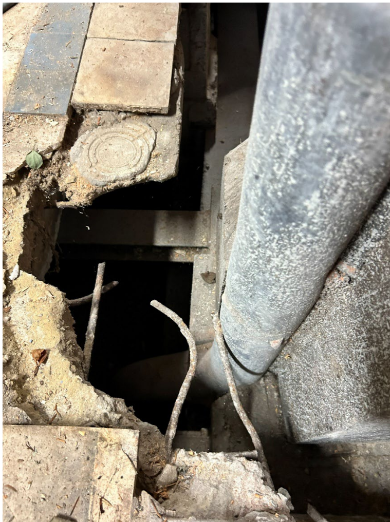
Figure 29 photographie d'une poutrelle métallique, 7 juillet 2026 © Büsra Jouant
