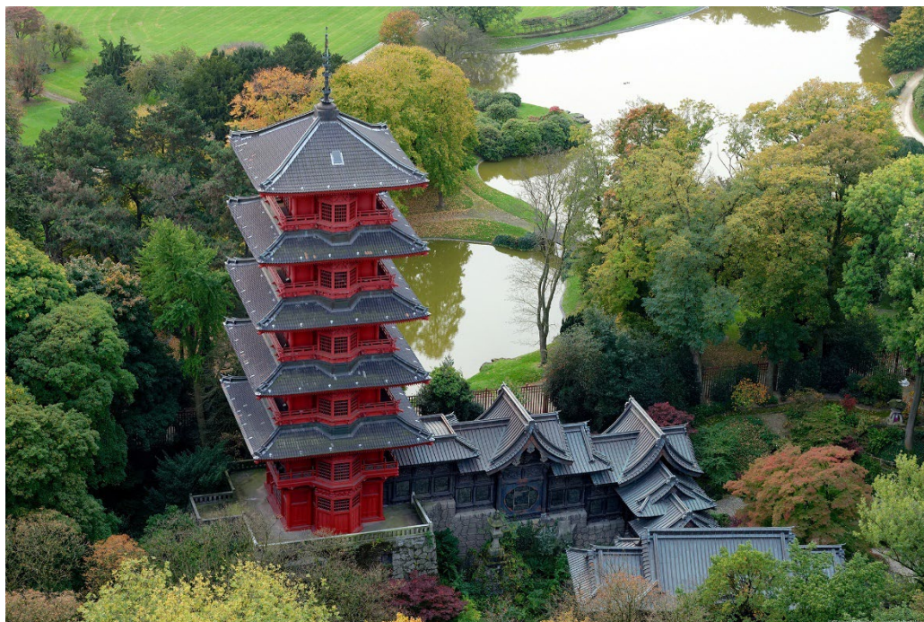
Figure 18 vue nord de la Tour japonaise, s. d. © Régie des Bâtiments
