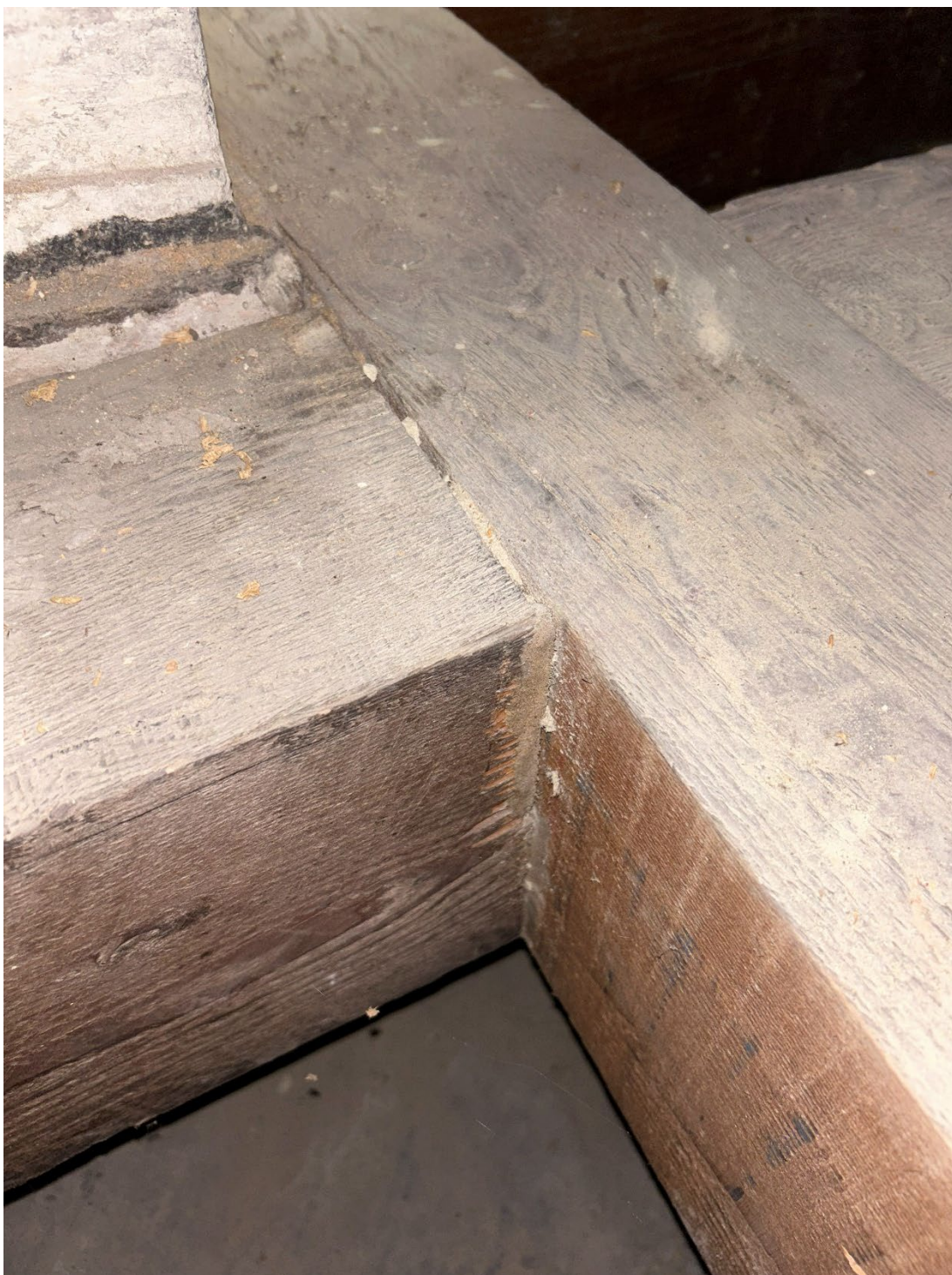
Figure 32 au troisième niveau, les quatre colonnes d'une même fondation sont reliées par des moises* disposées en diagonale. Les assemblages* observés sont réalisés à mi-bois*. 7 juillet 2026. © Büsra Jouant
