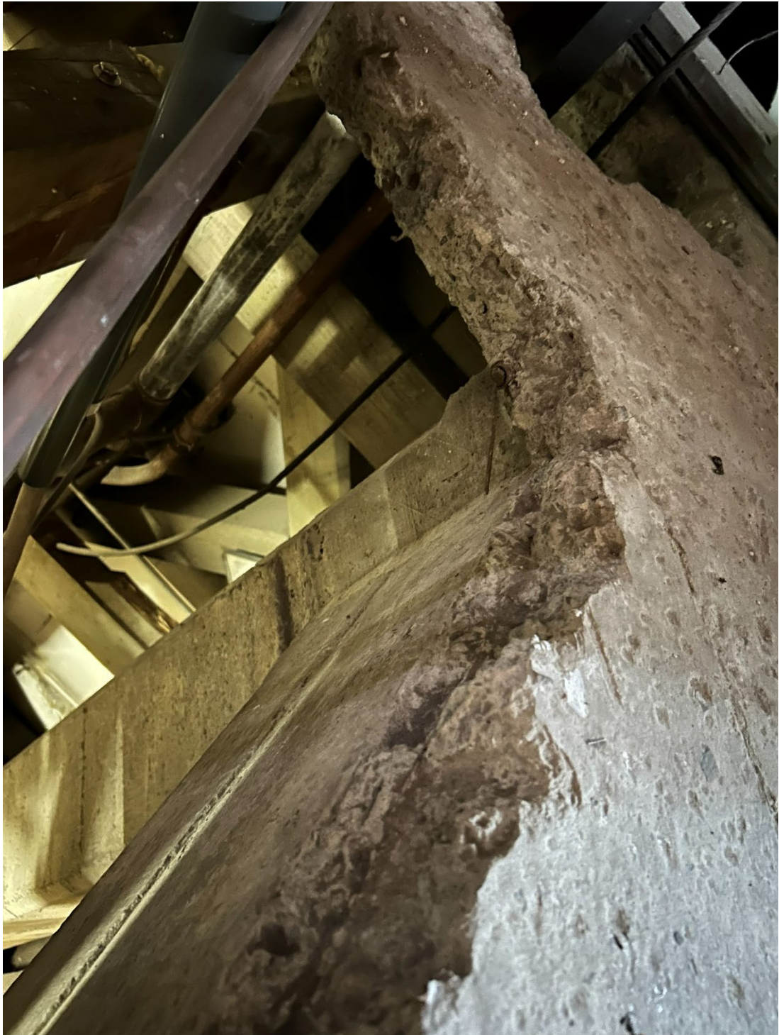
Figure 82 photographie de la fine dalle au niveau du rez-de-chaussée, 7 juillet 2026 ©Büsra Jouant
