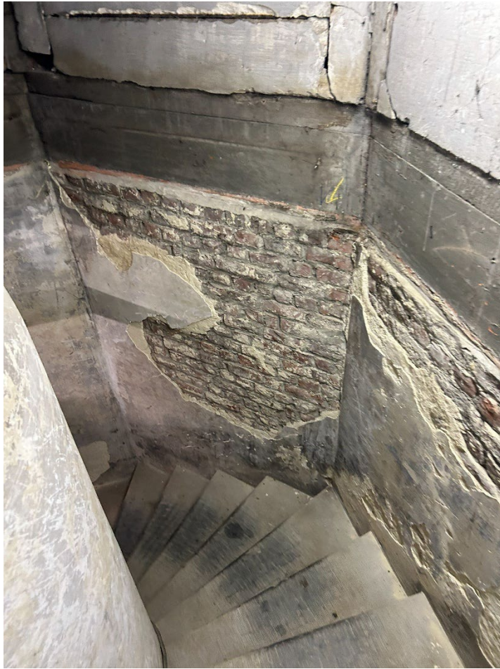
Figure 71 photographie de la cage d'escalier vers les caves, 16 avril 2026 ©Büsra Jouant
