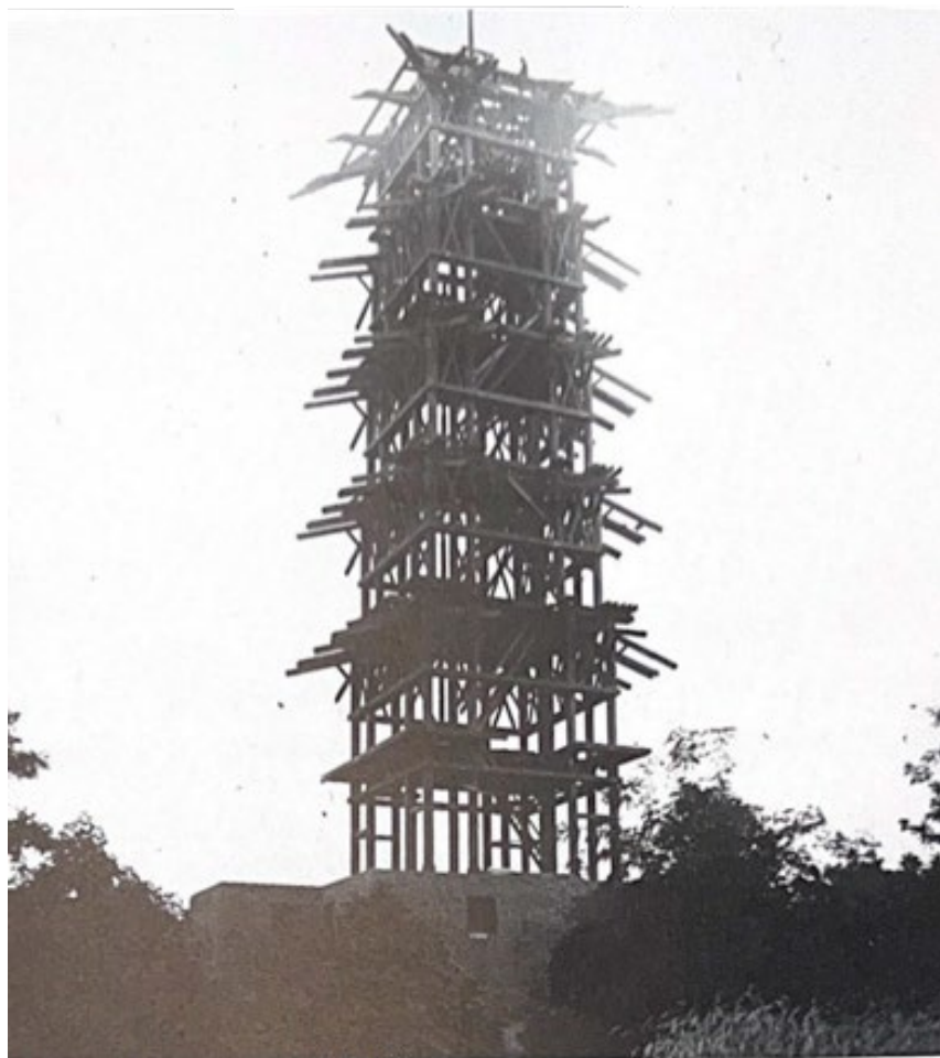
Figure 70 photographie du chantier de la Tour japonaise avant la mise en œuvre de l'escalier, 1902
