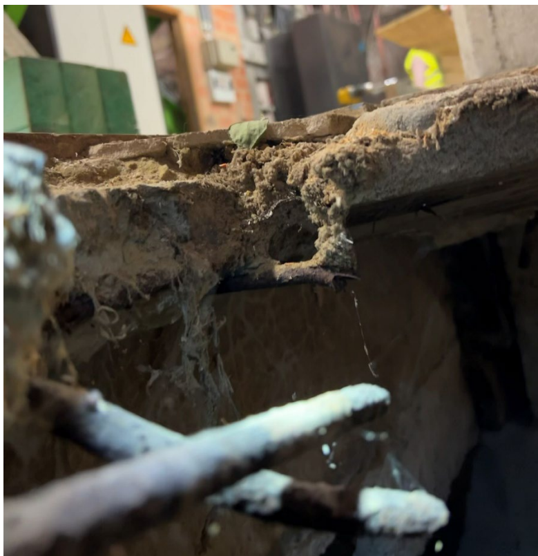
Figure 81 dalle de sol de la cave avec ses armatures, 7 juillet 2026 ©Büsra Jouant
