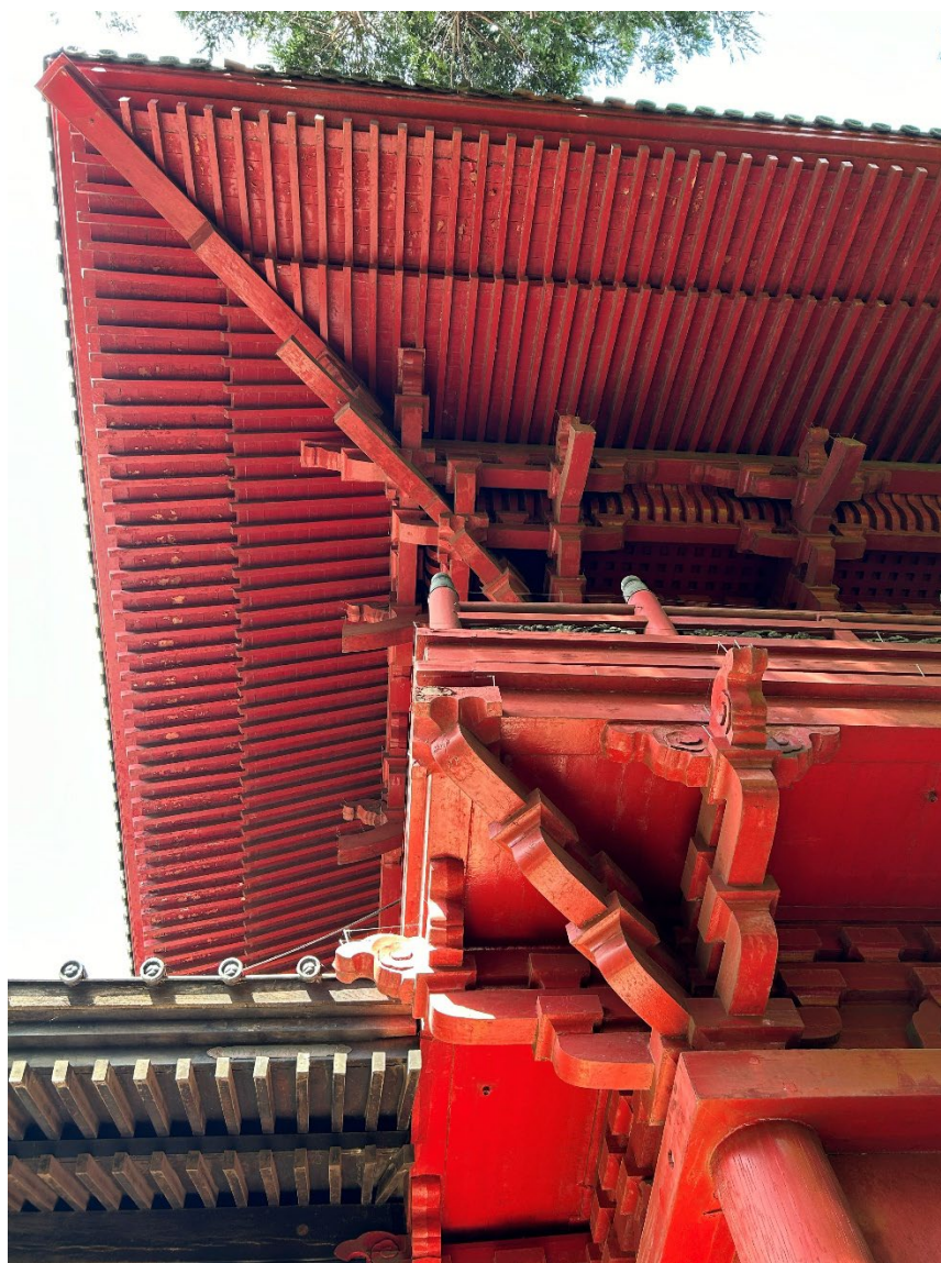
Figure 57 photographie en contre-plongée de l'angle de la toiture du deuxième étage de la Tour, 16 avril 2025 ©Büsra Jouant
