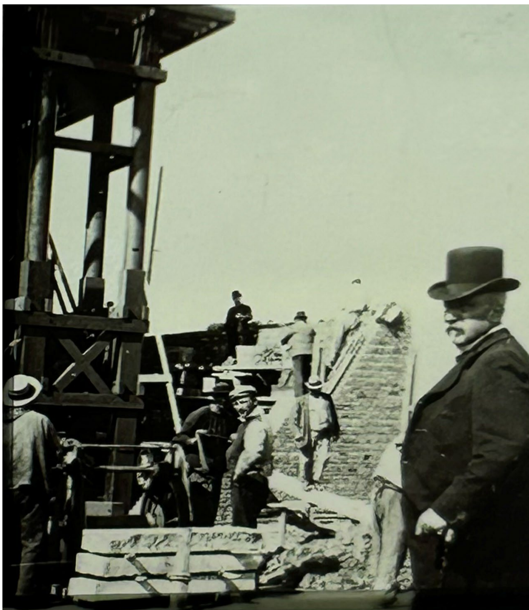
Figure 44 l'inspecteur des bâtiments de la Liste civile du Roi, Faldoni Van de Velde sur le chantier de la Tour japonaise, 1902 ©Archives du Palais Royal
