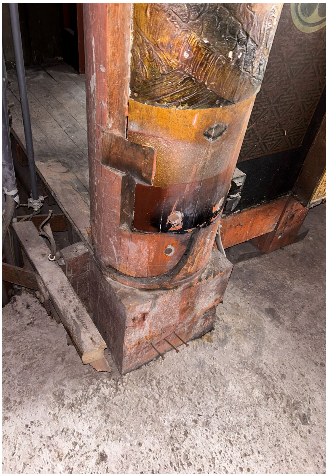
Figure 43 photographie de la base de la colonne au rez-de-chaussée, sous le niveau de sol fini, traversant la fine dalle en « ciment armé* », 7 juillet 2026 ©Büsa Jouant
