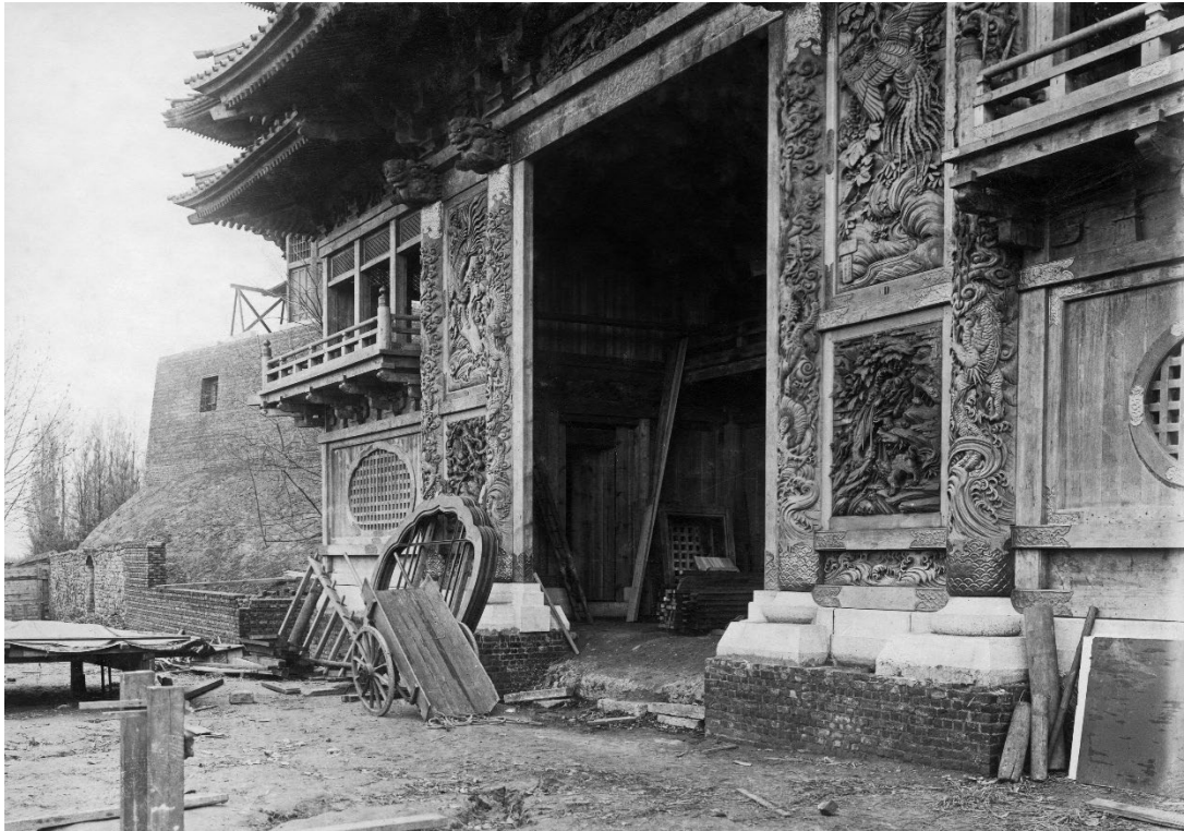
Figure 11 le porche du "Tour du monde" en cours de remontage à Laeken, 1902 ©Institut royal du patrimoine artistique
