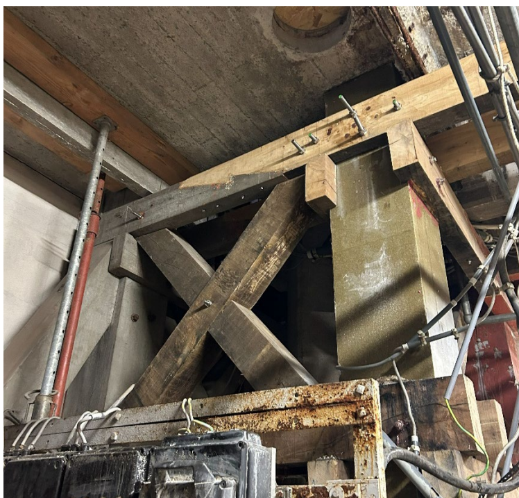
Figure 76 travaux d'assainissement en cours dans les caves, 7 juillet 2026 ©Büsra Jouant
