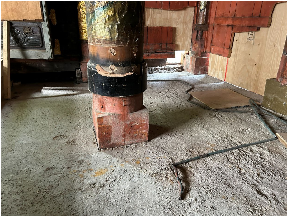
Figure 42 photographie de la base carrée de la colonne traversant la fine dalle en « ciment armé* », avant de laisser place à une colonne circulaire, 7 juillet 2026 ©Büsra Jouant
