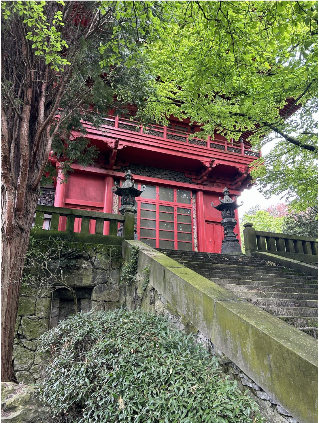
Figure 19 terrasse de la tour japonaise, s.d. ©Régie des Bâtiments
