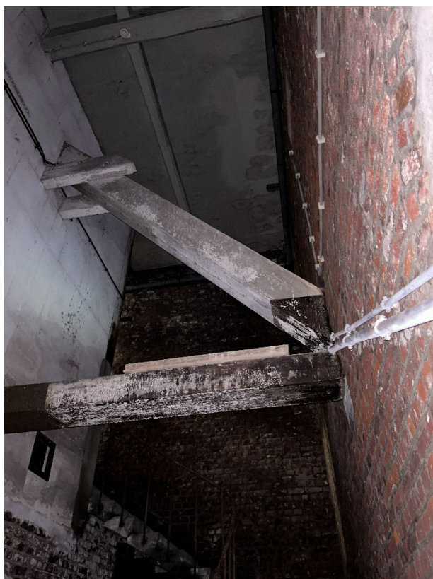
Figure 79 état des caves de la Tour japonaise en avril 2024, 16 avril 2024 ©Büsra Jouant
