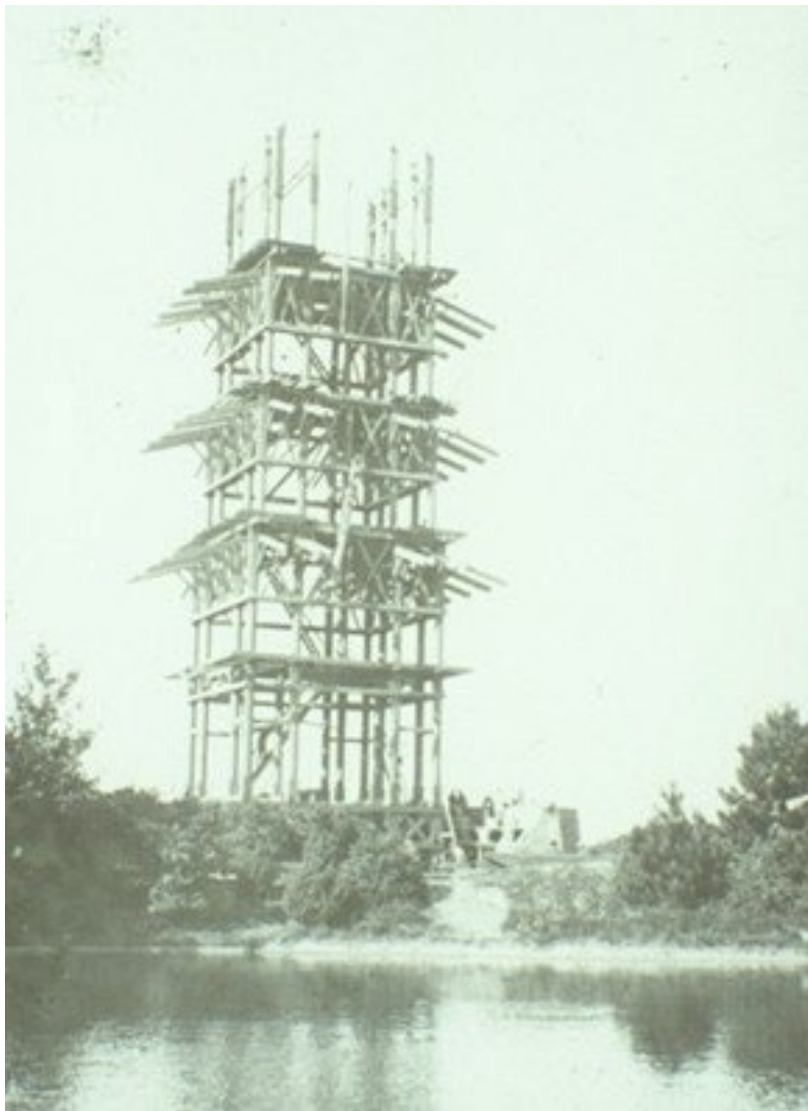
Figure 10 photographie de la Tour lors du chantier, 1902 ©Archives du Palais Royal
