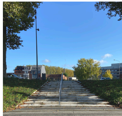
Fig. 31 : L'arrivée sur site depuis l'Escaut
