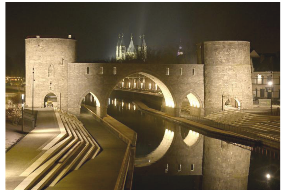
Fig. 27 : Le Pont des Trous de nos jours
