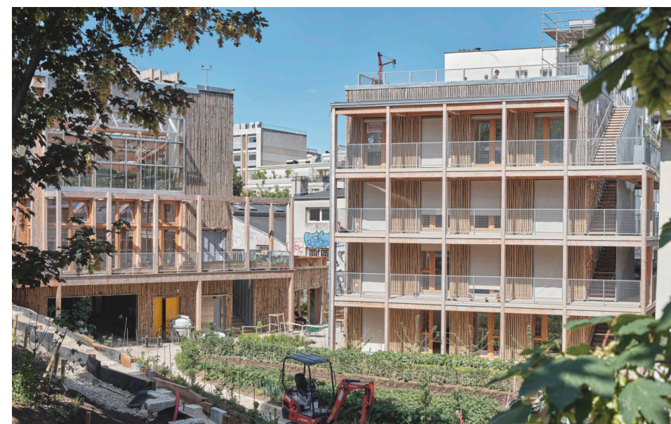
Fig. 19 : La Ferme du Rail, le bâtiment de logement à droite et le restaurant à gauche
