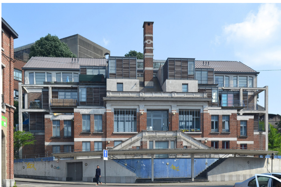
Fig. 9 : Logements sociaux «Piscine de la Brouchettere», Charleroi
