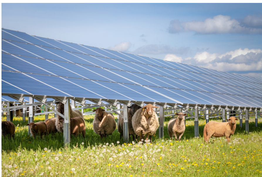
FIGURE II.2 – Exemple de structures agrivoltaïques basse à panneaux inclinés. ©Harry Koerber
