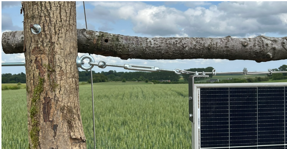
FIGURE IV.18 – Photo du système de fixation à câble.
