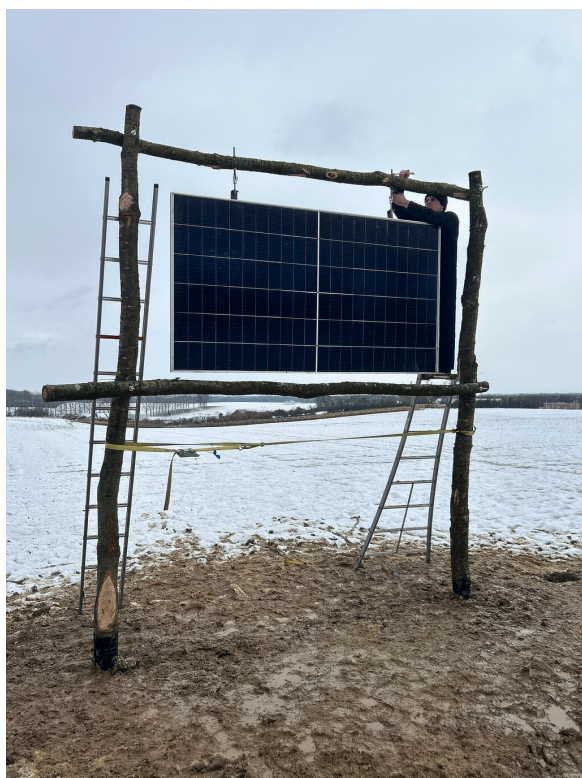
(a) Construction du prototype.
