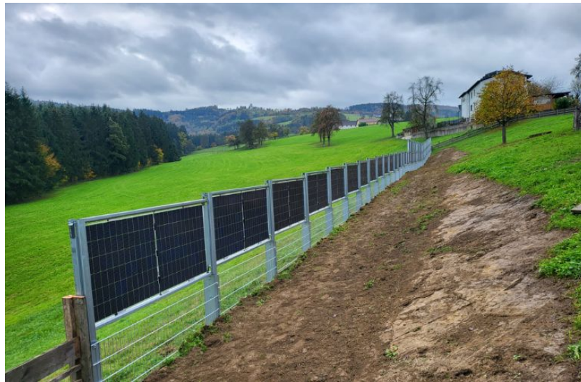
FIGURE II.3 – Exemple de barrières installées. ©Next2Sun
