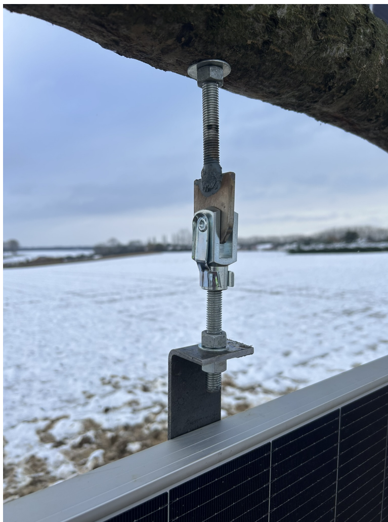
FIGURE IV.9 – Système de rotule mécanique installé sur le prototype.
