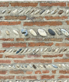
Mur mortier de terre et briques foraines
