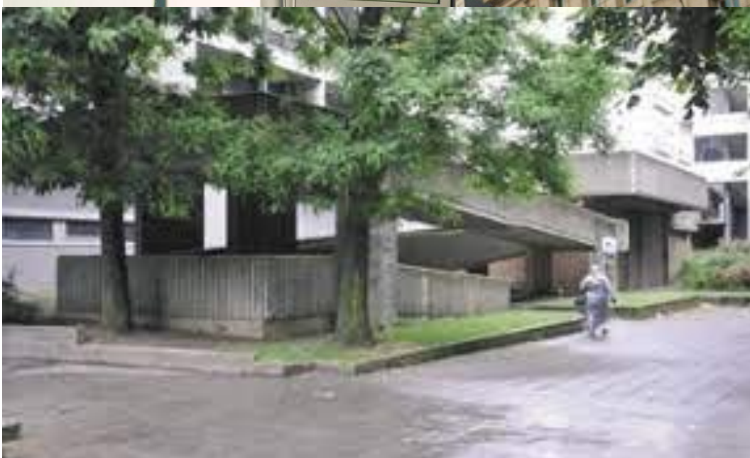
Illustration 23 : Rampe d'accès bétonnée et représentant un obstacle visuel
