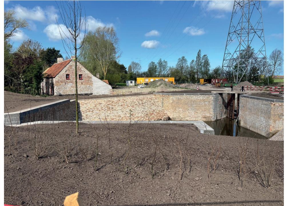
Fig. 4.13: L'écluse de Twee Speyen en restauration, le long du canal Gand-Ostende
