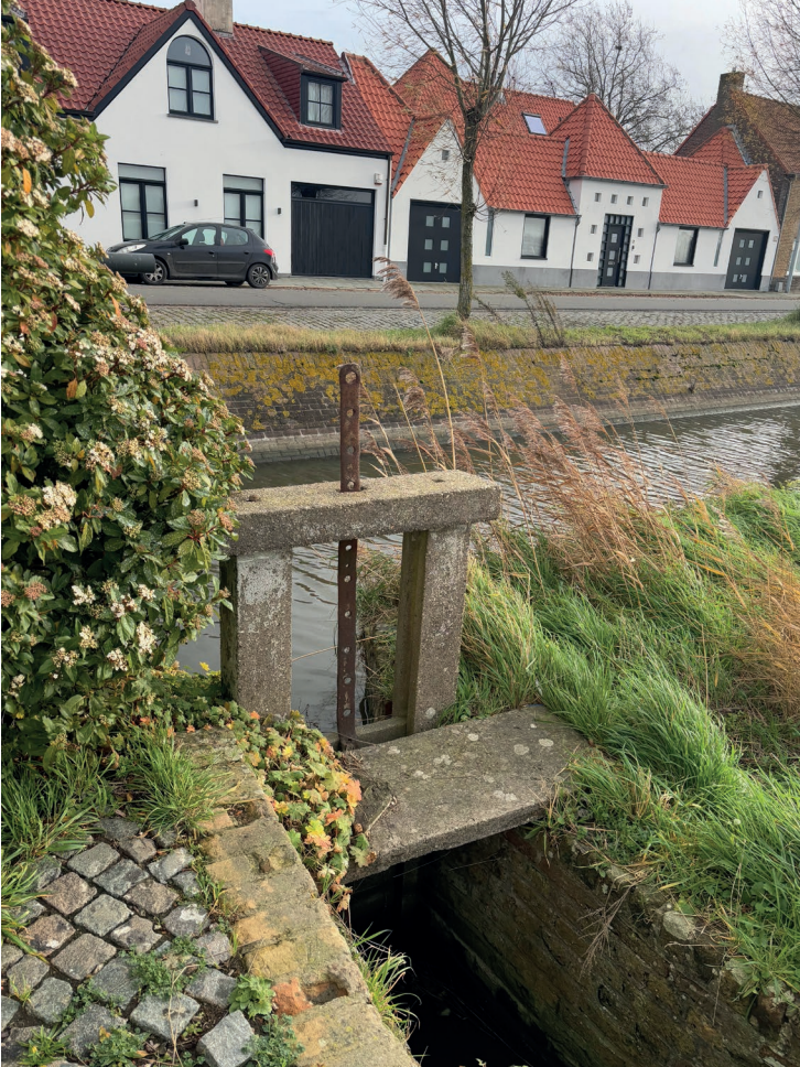
Fig. 4.10: Vanne ouverte/fermée le long du canal Lissewege
