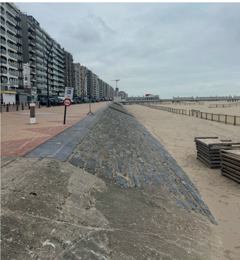
Fig. 2.13: Digue à Blankenberge
