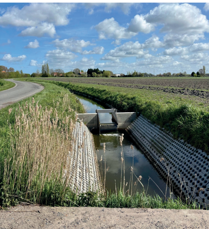
Fig. 4.11: Barrage à poutrelles amovibles le long du canal Blankenberge
