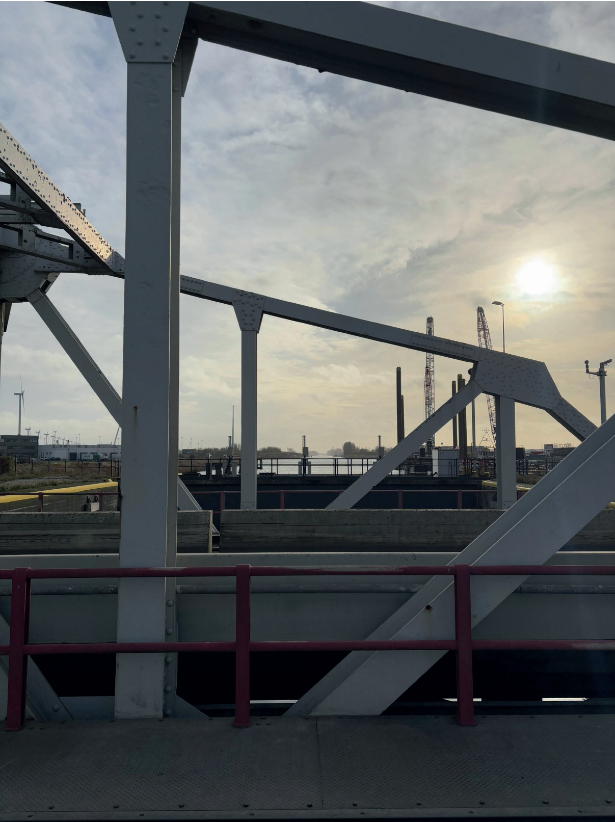
Fig. 4.12 L'écluse Visart dans le port de Zeebruges
