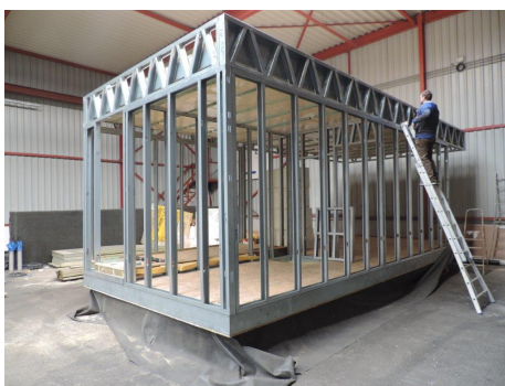
Figure 6. Structure en acier du SmartLiving
