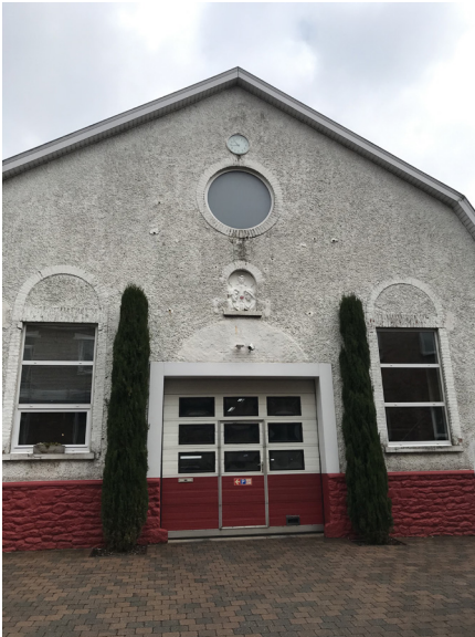
Figure 69 : Façade du garage BCS
