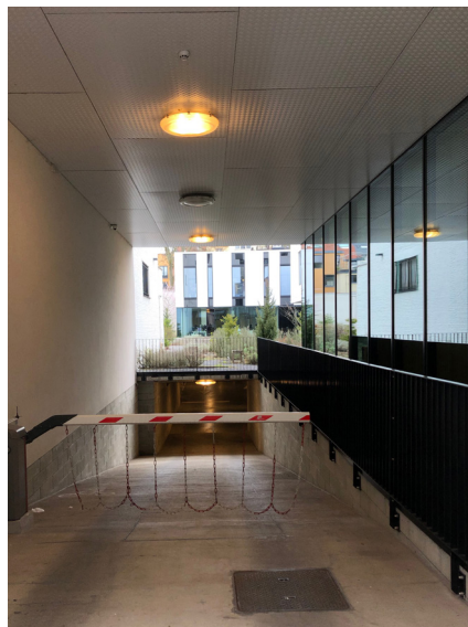
Figure 144 : Accès vers un parking souterrain
