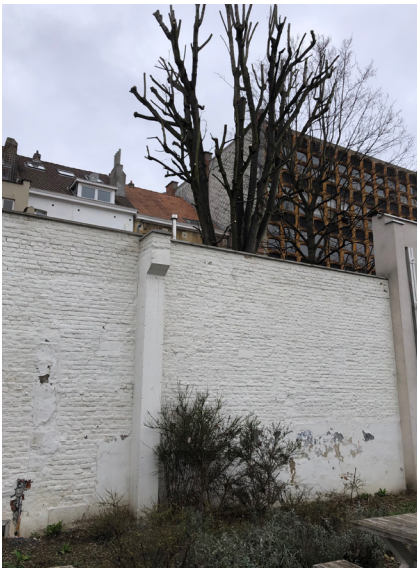
Figure 143 : Un mur mitoyen en intérieur d'îlot
