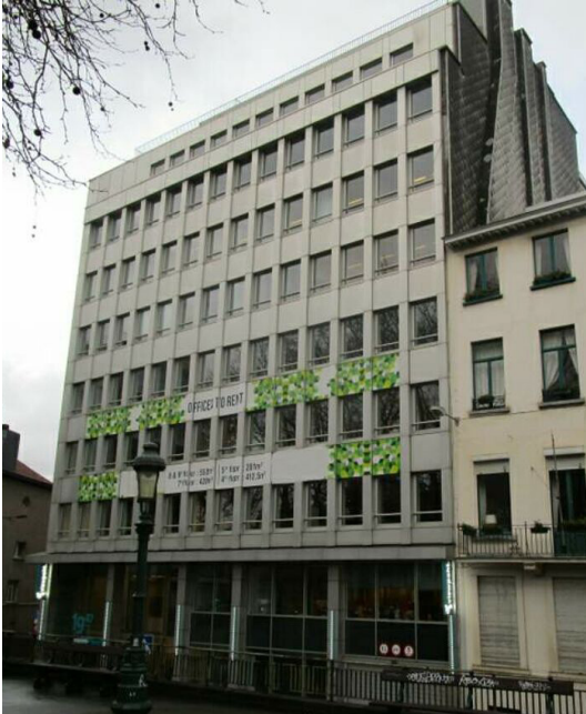
Figure 119 : Vue de l'immeuble de bureaux Avenue des Arts 19
