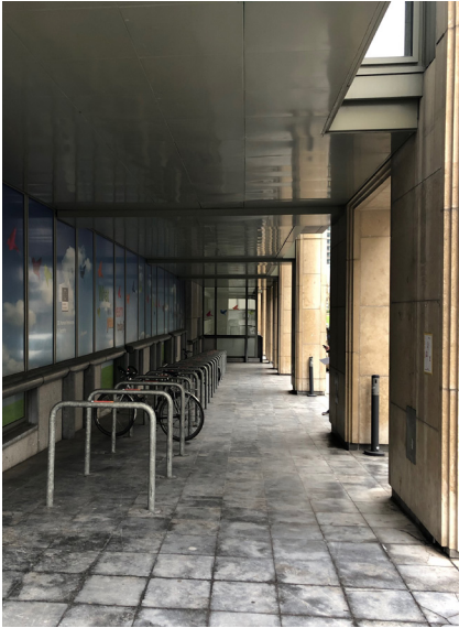
Figure 141 : Aucun accès vers la rue au rez-de-chaussée d'un immeuble de bureaux
