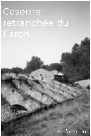
Caserne retranchée du Faron vue de la cuve depuis le jardin au nord
