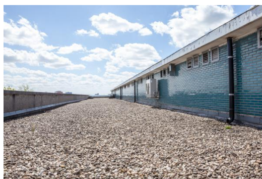
Toiture en gravier
