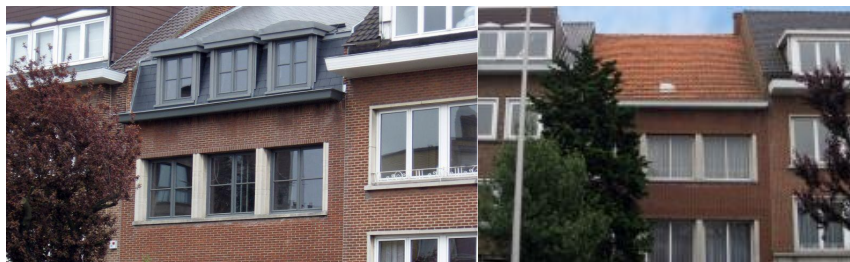
Rehaussement d'immeuble bruxellois
