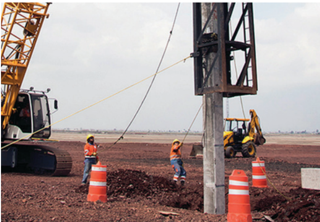
Fig. 76 : Mise en oeuvre de pieux de fondation © Cimesa
