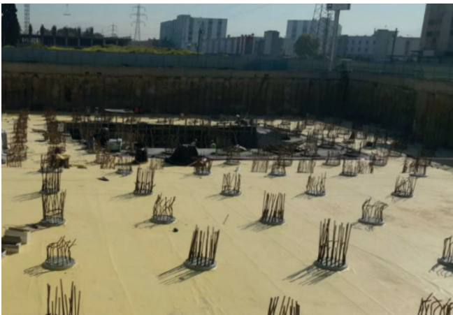
Fig. 78 : Utilisation de membranes géotextiles imperméables © Renolit SE
