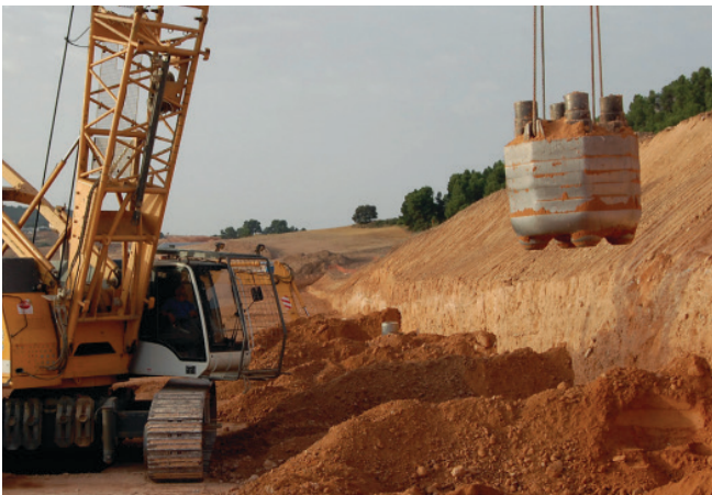
Fig. 77 : Compactage dynamique par poids en béton © Menard
