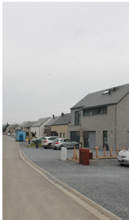
Fig 32 rue Dry Herleux
