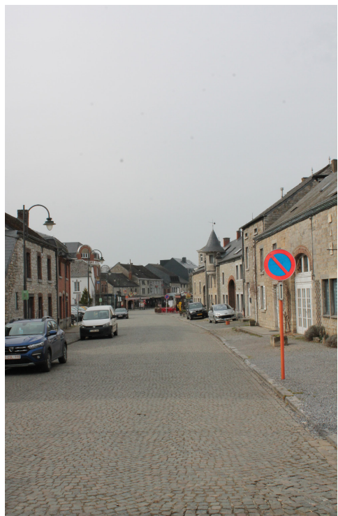
Fig 30- rue des Grottes
