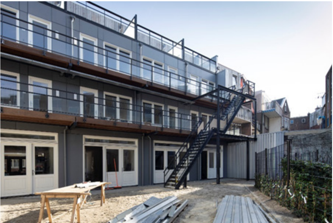
Figure 34 : Façade réhabilitée du projet
