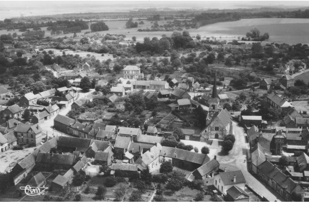
Figure 11: Photo aérienne de la commune de Moyvillers
