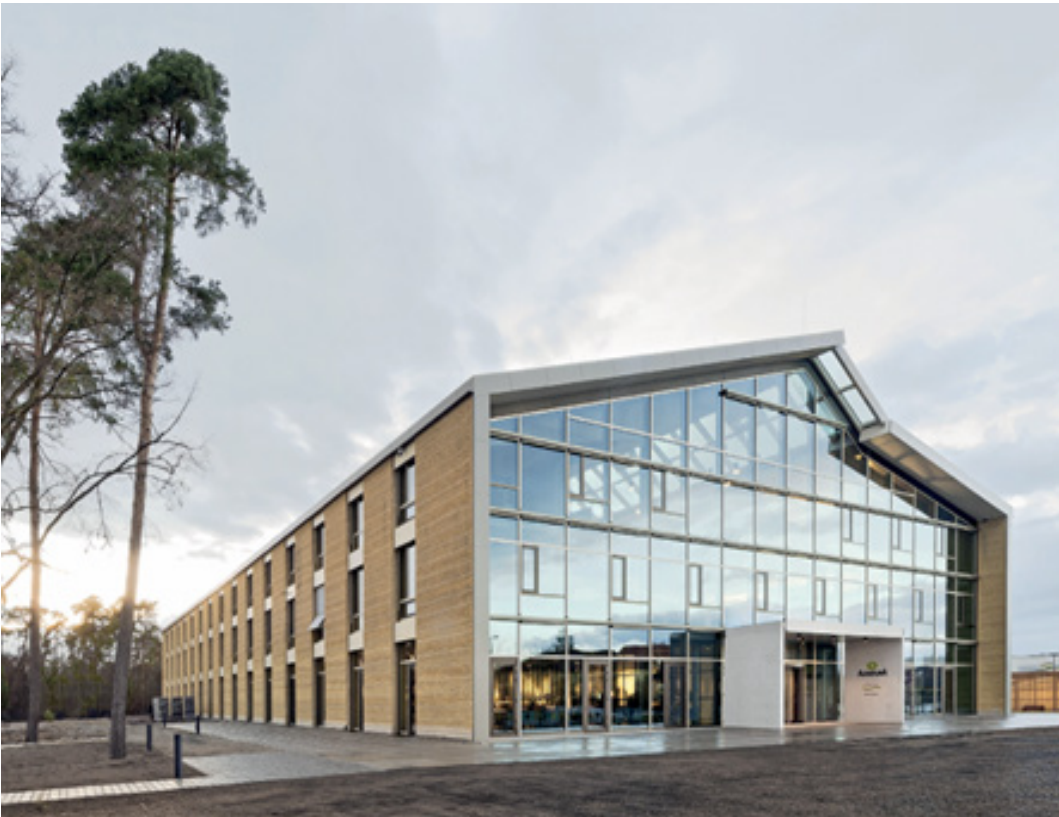
Figure 45 : Photographie de l'ensemble du projet
