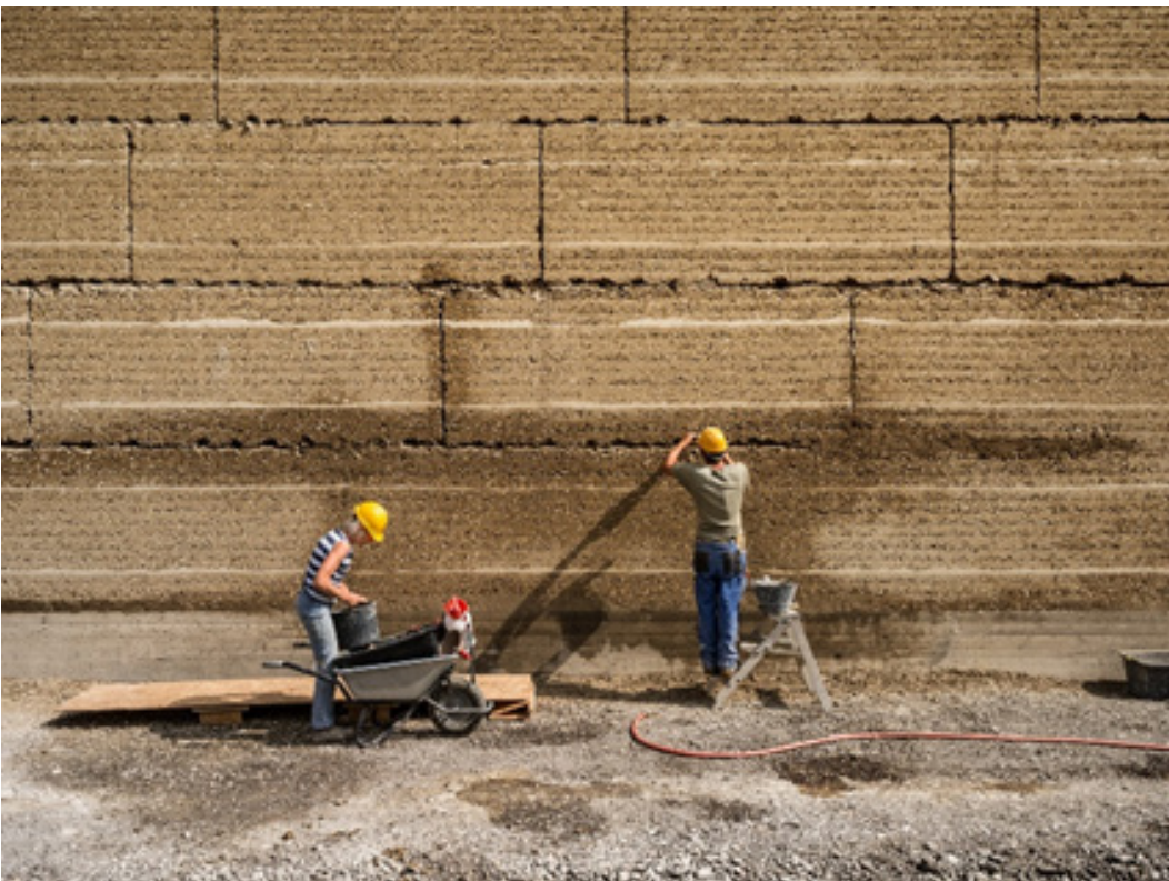
Figure 44 : Photographie du chantier Ricola, retouche des joints
