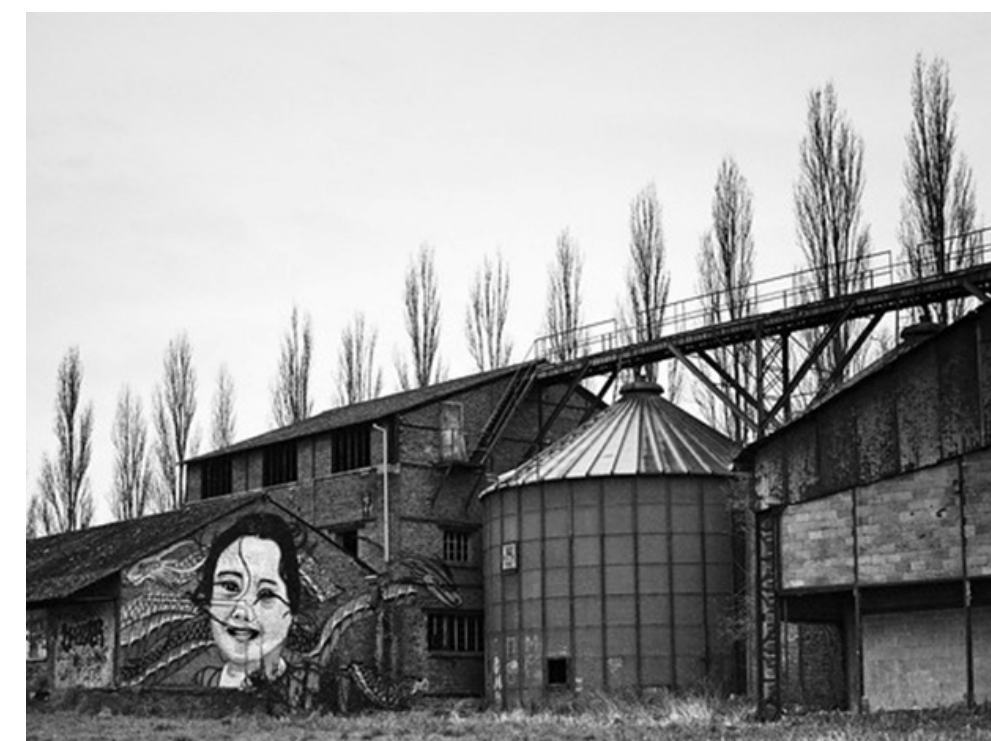
Figure 15: Photographie de la sécherie en 2010, vue des anciens silos
