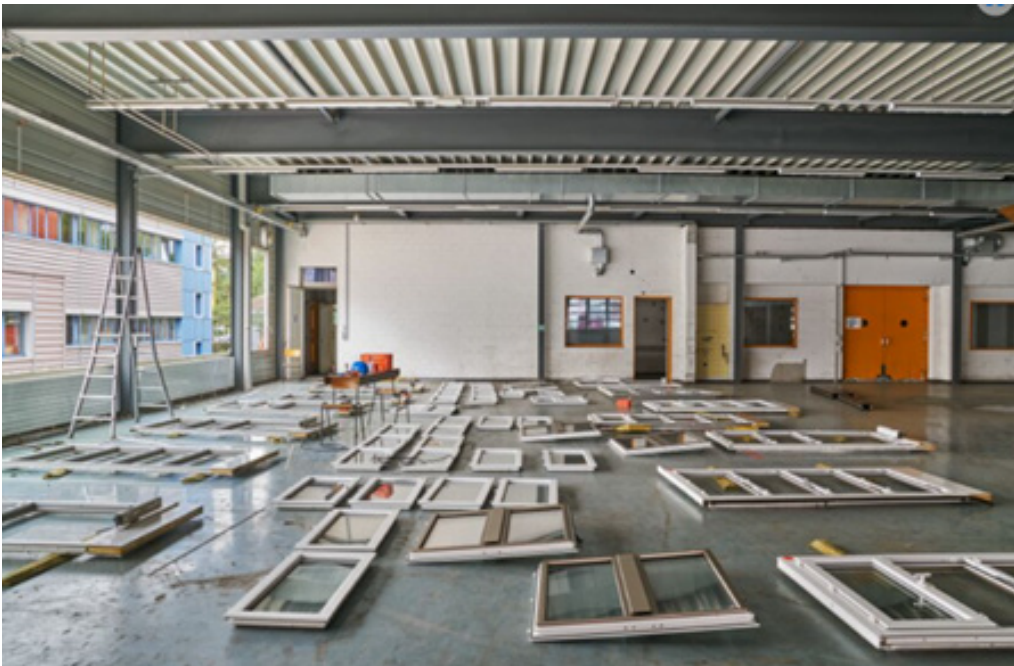
Figure 37 : Photographie du réemploi mis en place sur le projet.
