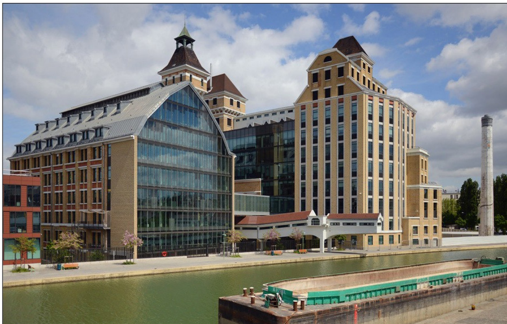
Figure 43 : Photographie de la réhabilitation du Grand Moulin de Pantin
