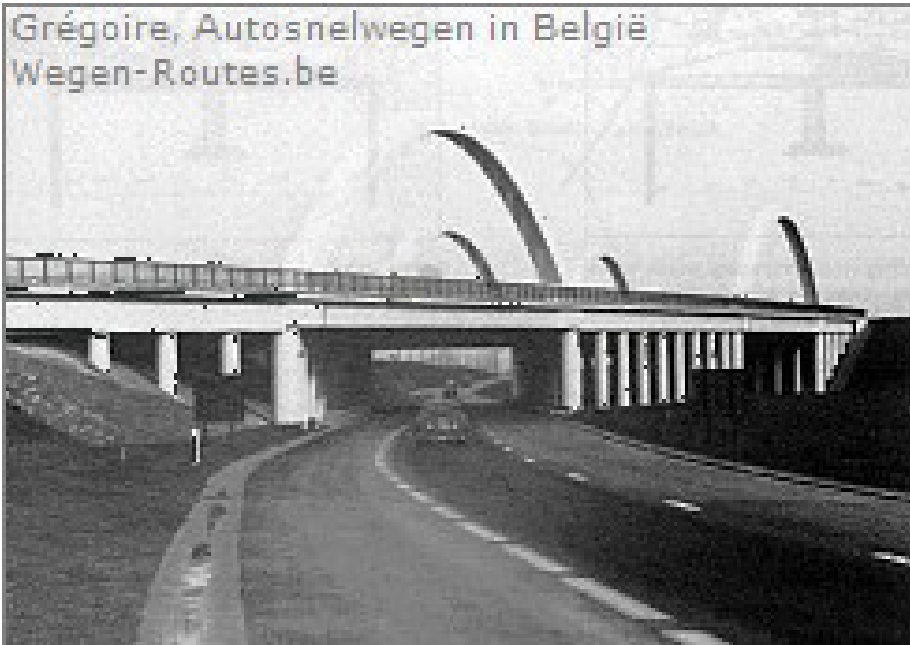
Fig. 19 - Construction of the E19 motorway - Wegen-Routes.be, 1967
