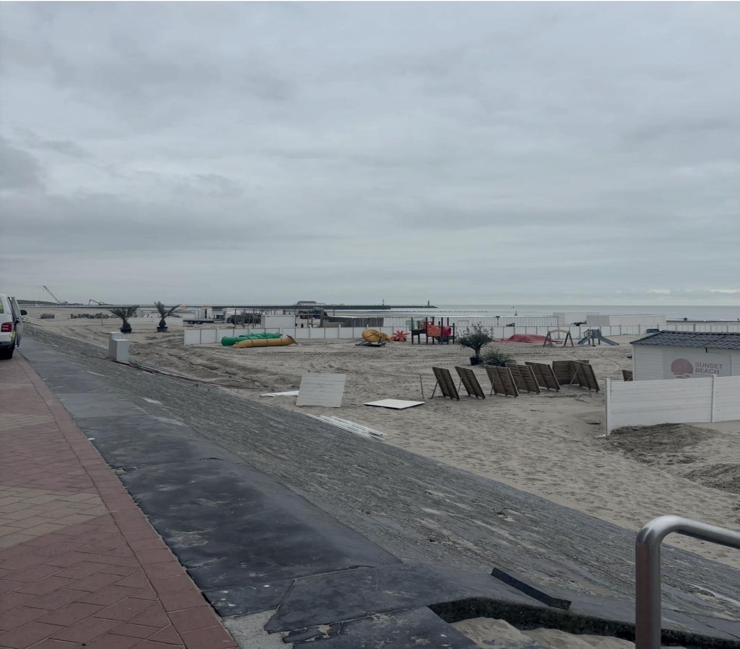
La digue de Blankenberge
