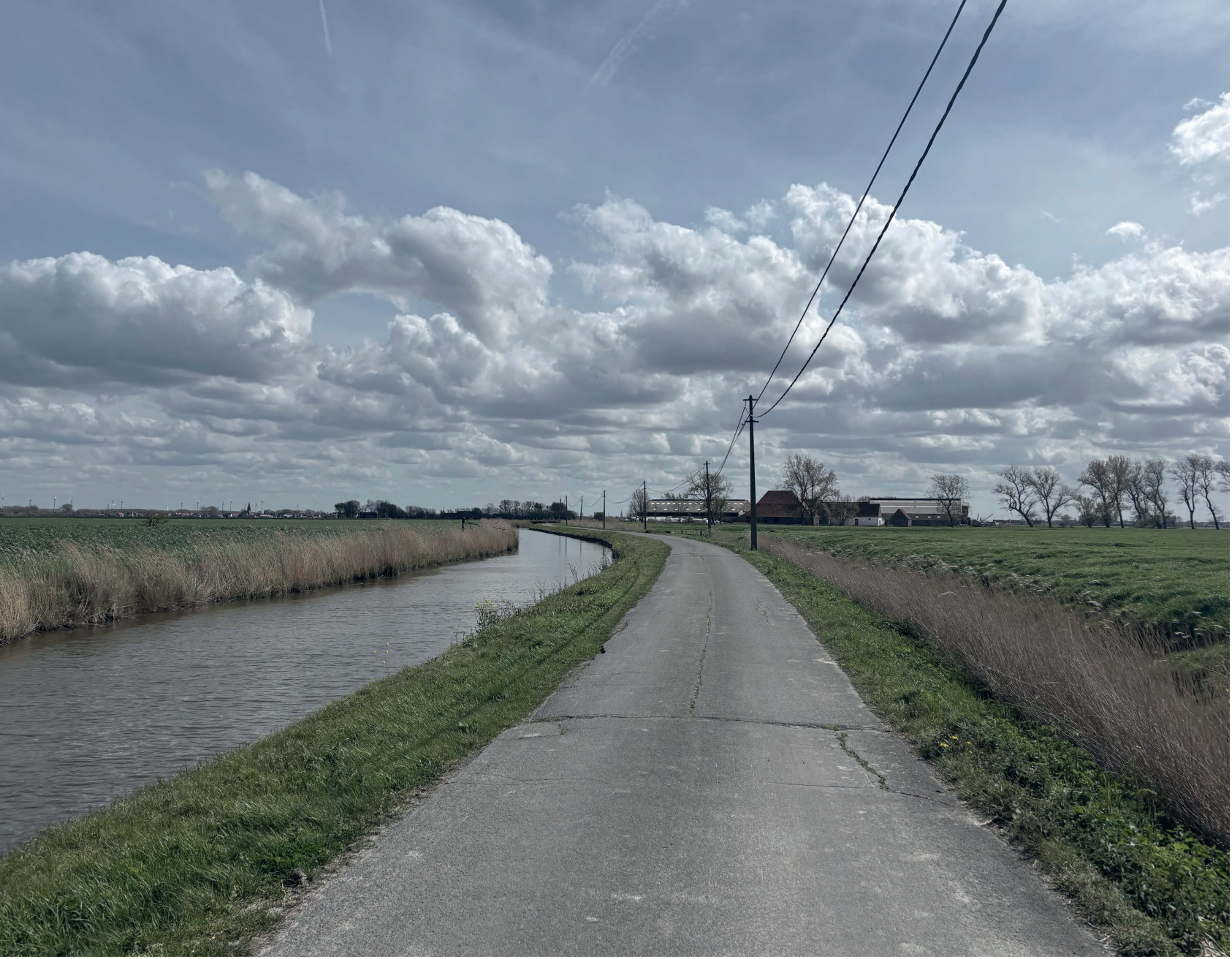
Canal Blankenberge et ferme de production
