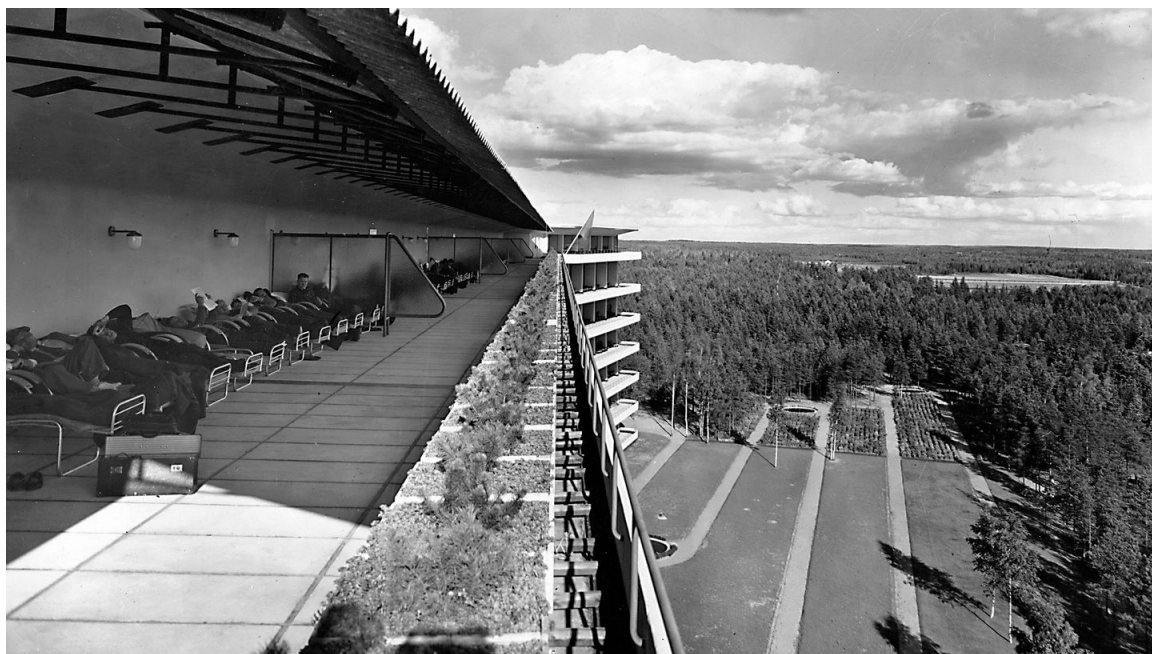
Fig 26: Le toit terrasse du Sanatorium - Alvar Aalto © Auteur inconnu
