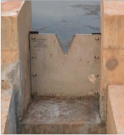
(a) Déversoir de mesure (EDC, 2019)
