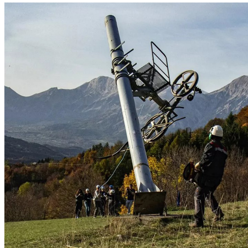
Démantèlement d'un téléski abandonné par l'association Mountain Wilderness. Photographie de Jeandel, S. (2023).
