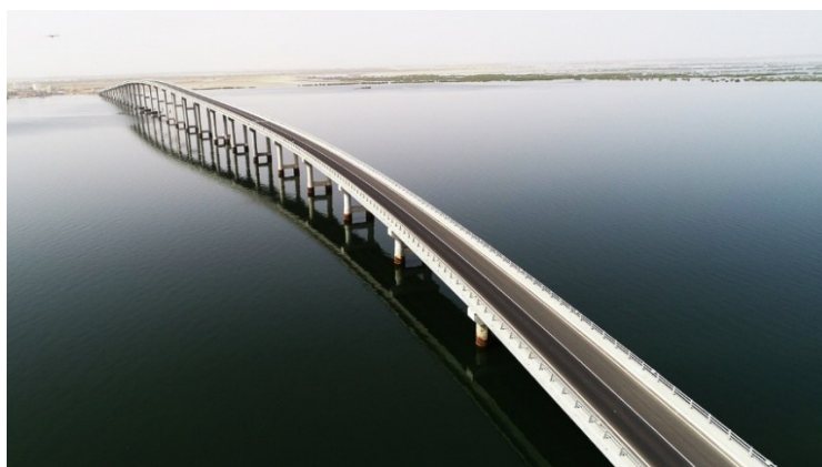
Figure 5 : Photo du pont Nelson Mandela de Foundiougne. Source : AGEROUTE (s. d.-b).
