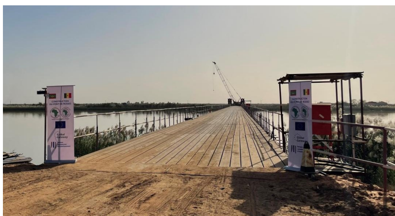
Figure 3 : Photo du pont de Rosso en construction. Source : Délégation de l'Union européenne en Mauritanie (2025).
