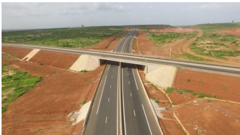
Figure 7 : Photo de l'autoroute Mbour-Fatick-Kaolack. Source : Sikafinance (2026).
