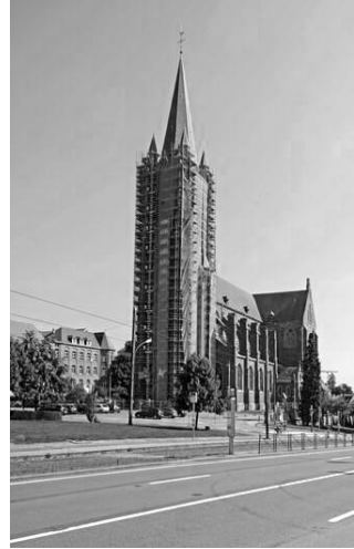
Fig 8. Eglise Saint-Hubert, Bruxelles, 1936 Photo: Inventaire du patrimoine architectural, 2014.
