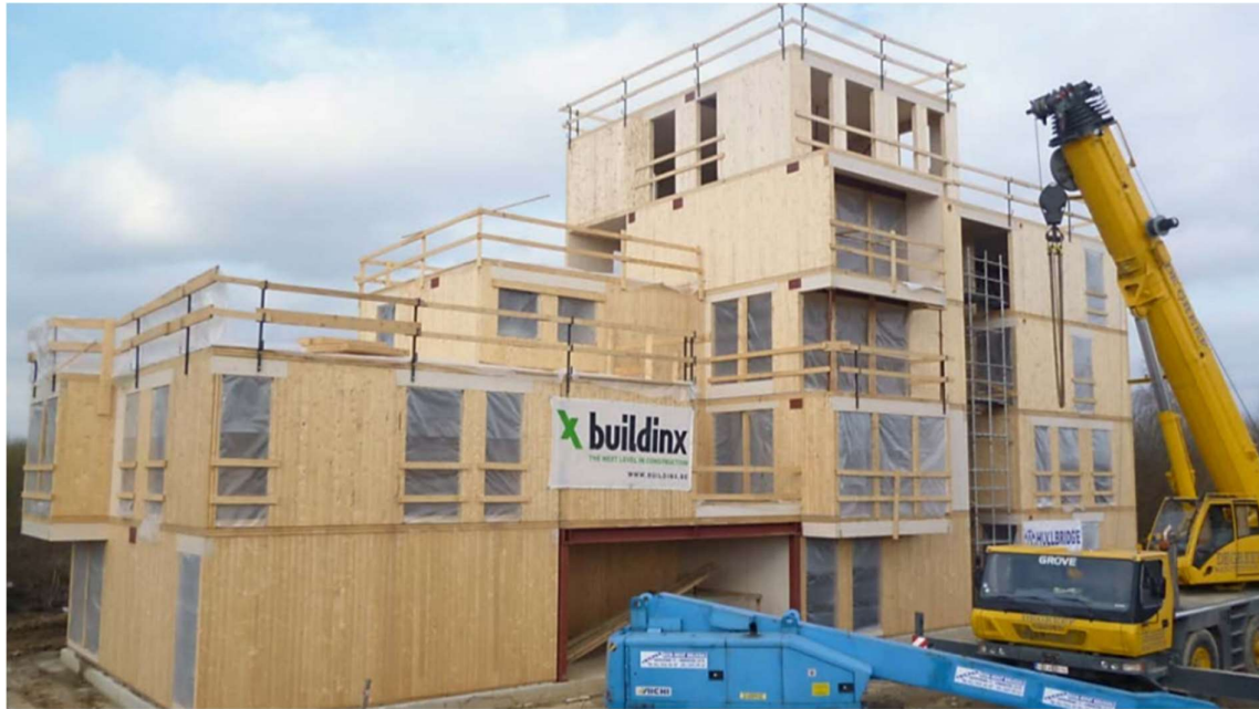
Figure 15 - Les cloisières en construction [17]
