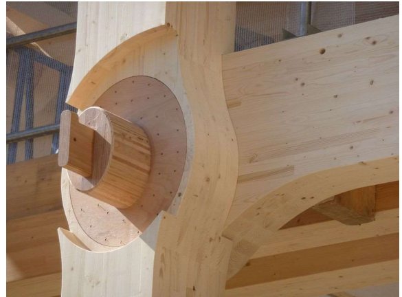
Figure 7 - Maison des médias "Tamedia" : structure en poteaux-poutres et connexion bois-bois [19]
