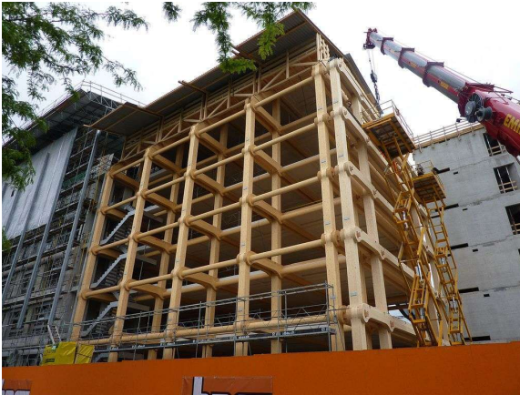
Figure 7 - Maison des médias "Tamedia" : structure en poteaux-poutres et connexion bois-bois [19]
