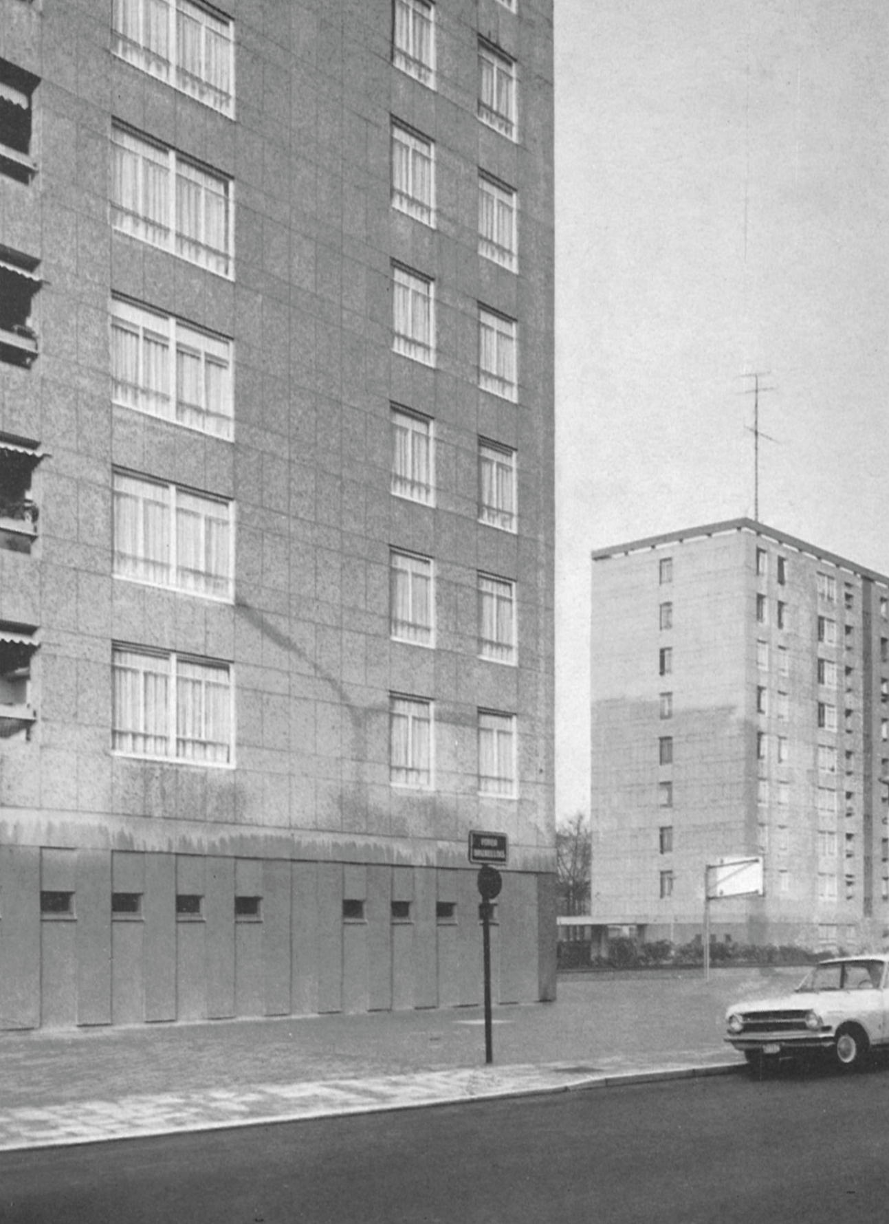
Figure 2 - Vue de l'ensemble Rempart des
