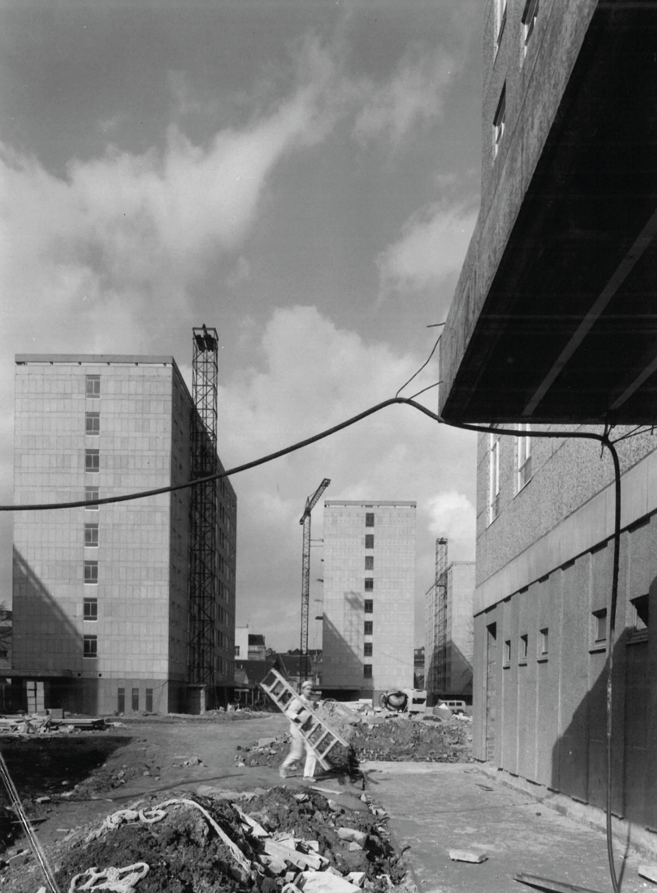
Figure 9 - Vue du chantier de l'ensemble Rempart des Moines issue de la revue « 3000 foyers bruxellois, cela ne se bâtit pas en un jour ! » dans les dossiers de la Fonderie 2, Le Foyer Bruxellois, 1997
