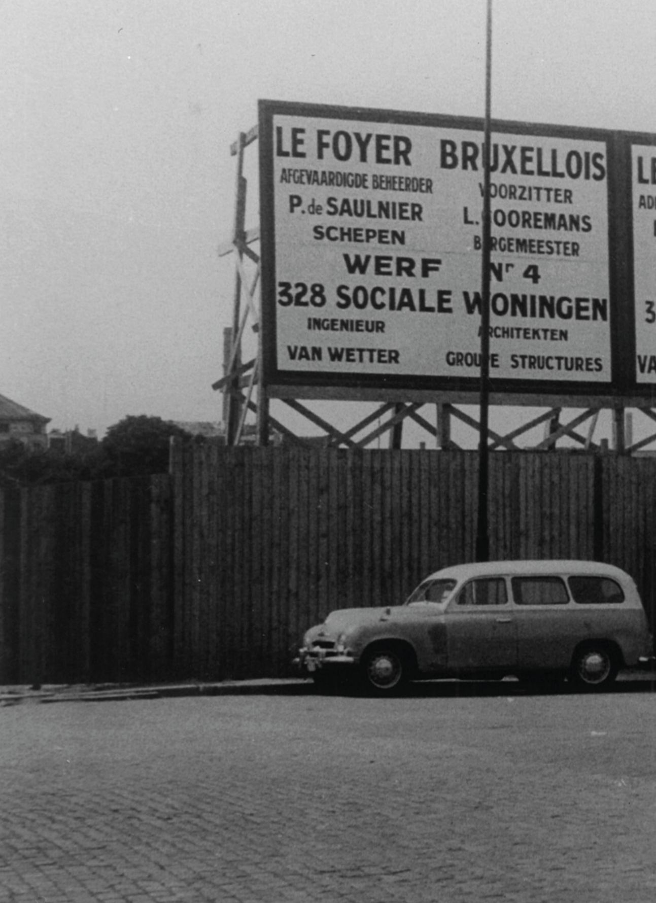
Figure 7 - Vue du chantier de l'ensemble Rempart des
