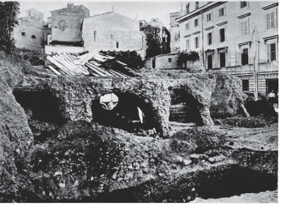
Découvertes lors des fouilles avant la construction de la cabine électrique, 1952.
